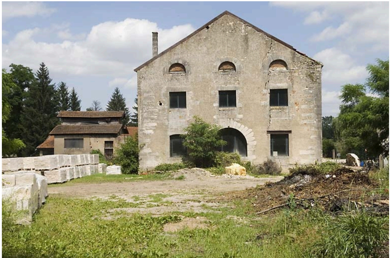
Pignon du bâtiment du haut fourneau ouest.
