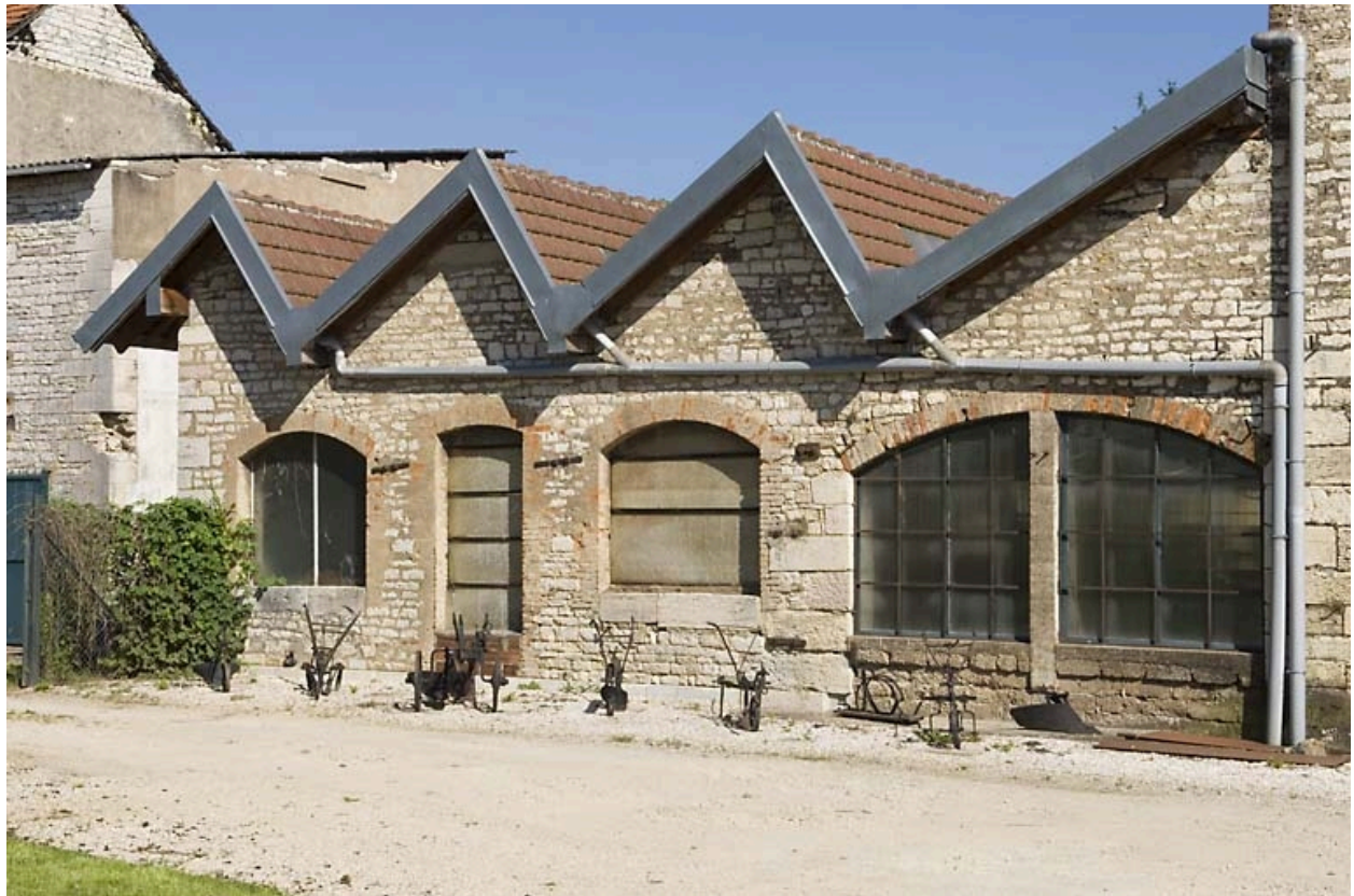
Extension ouest du bâtiment du haut fourneau.
