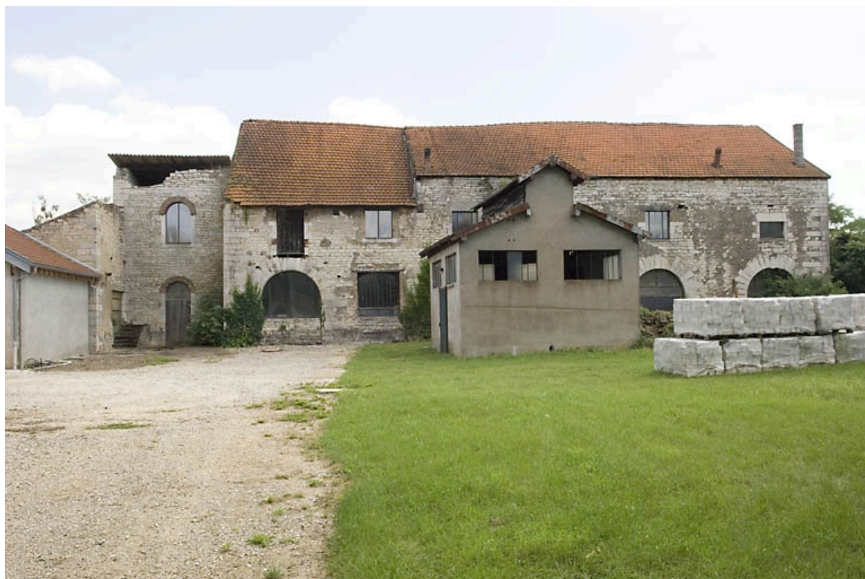
Façade nord du haut fourneau ouest.
