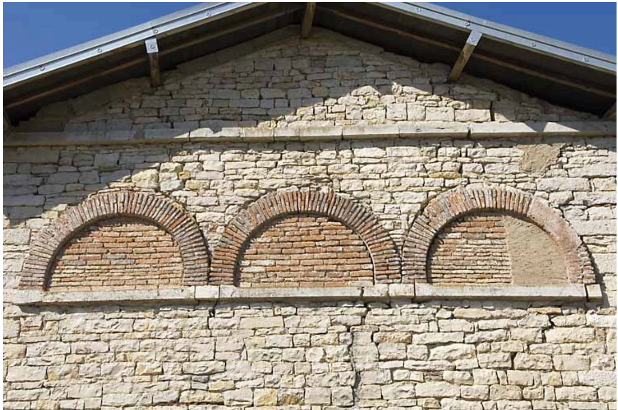
Logement (?) nord. Détail d'arcatures sur le pignon.
