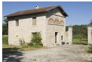
Logement (?) nord. Phot. Jérôme Mongreville IVR43_20087000810NUC2A
