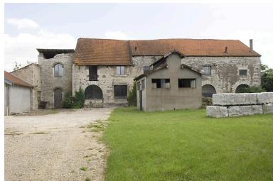
Façade nord du haut fourneau ouest. Phot. Jérôme Mongreville IVR43_20087000859NUC2A
