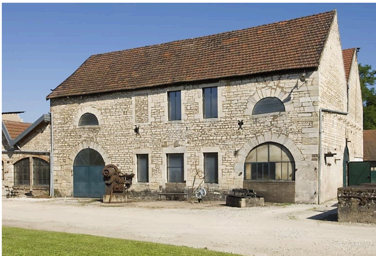
Bâtiment du haut fourneau est.
