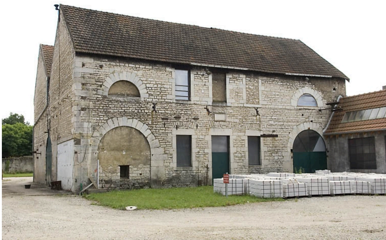
Bâtiment du haut fourneau est.
