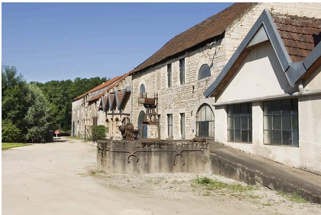
Façades sud des divers ateliers de métallurgie.
