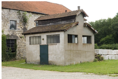
Bâtiment à usage indéterminé. Phot. Jérôme Mongreville IVR43_20087000858NUC2A
