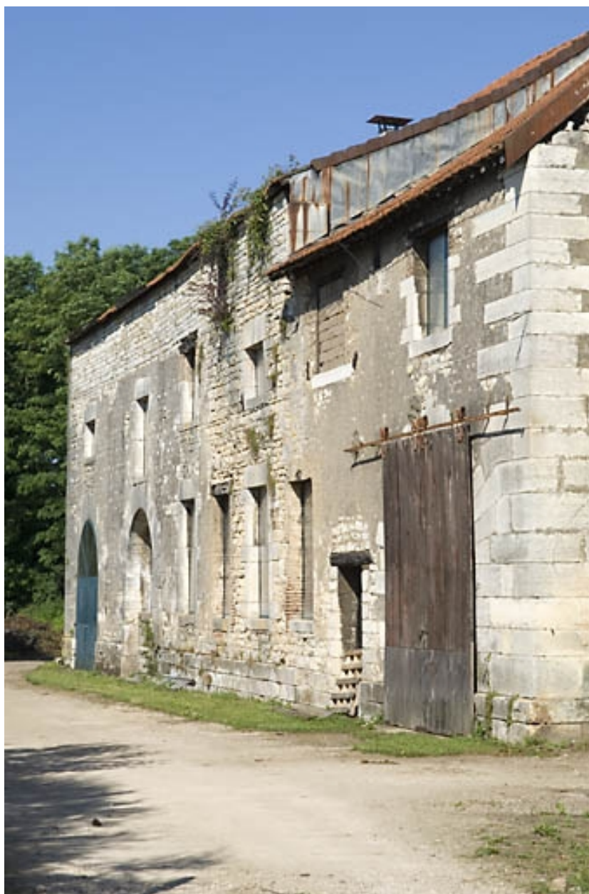
Bâtiment du haut fourneau ouest.
