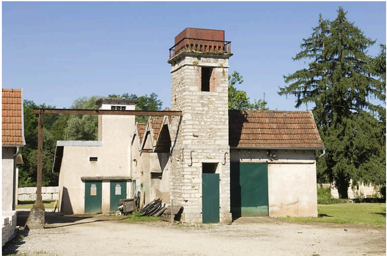
Transformateur, magasin et réservoir industriel (?).
