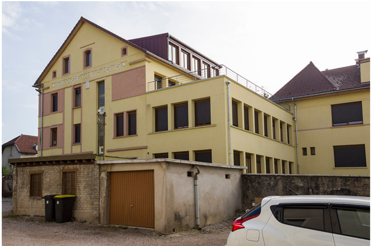
Immeuble et extension, depuis le sud-ouest.
