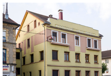
Immeuble : façades antérieure et latérale gauche.
