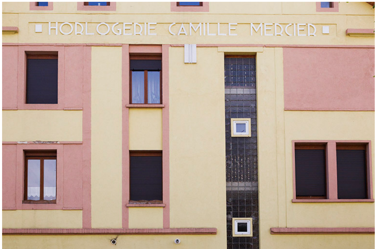
Immeuble : façade latérale droite (étages).
