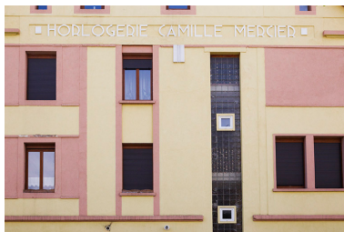
Immeuble : façade latérale droite (étages).
