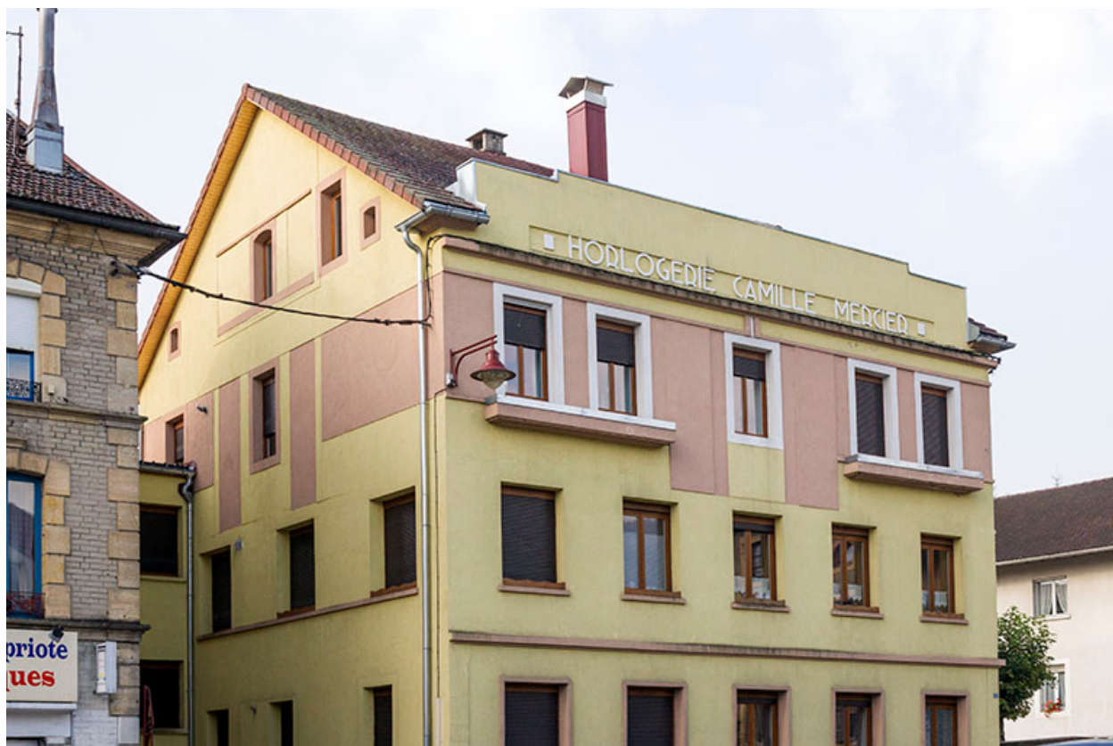
Immeuble : façades antérieure et latérale gauche.
