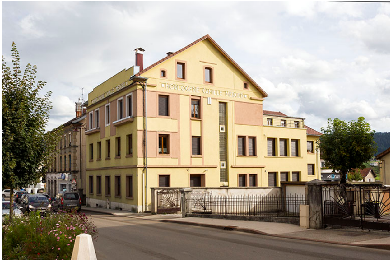
Vue d'ensemble, depuis l'ouest (immeuble et extension).
