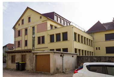
Immeuble et extension, depuis le sud-ouest.
