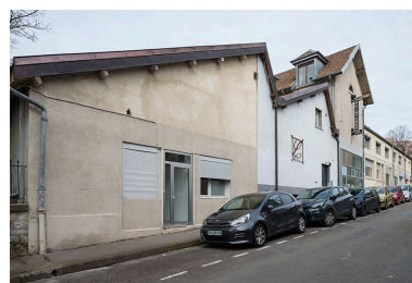
Façades est sur la rue. Phot. Jérôme Mongreville IVR43_20182500533NUC4A
