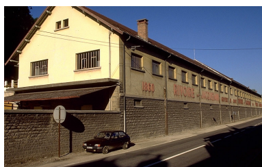
Pièce d'affinage (1953). Phot. Jérôme Mongreville IVR43_19963900519ZA
