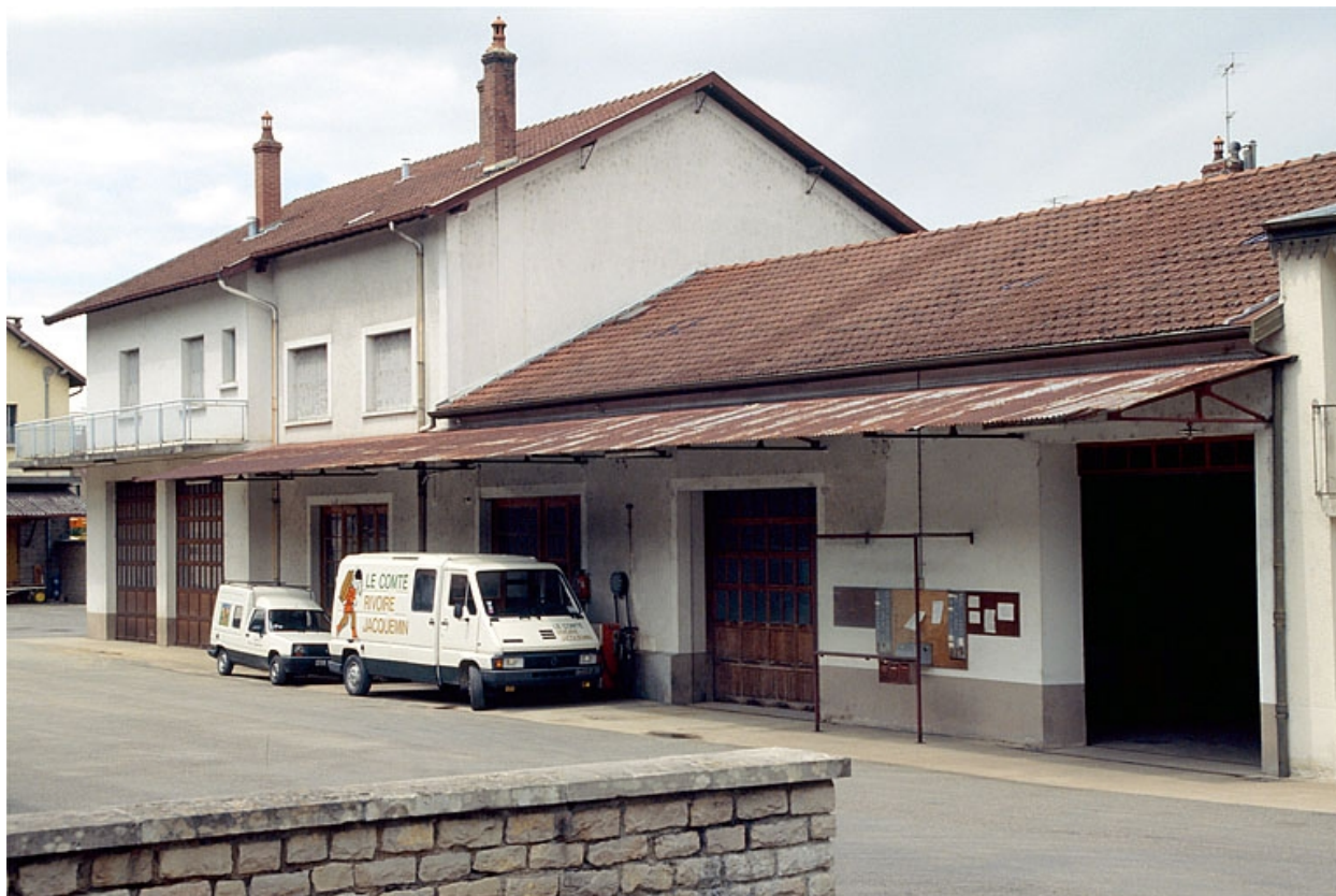
Atelier de réparation, logement et remise.
