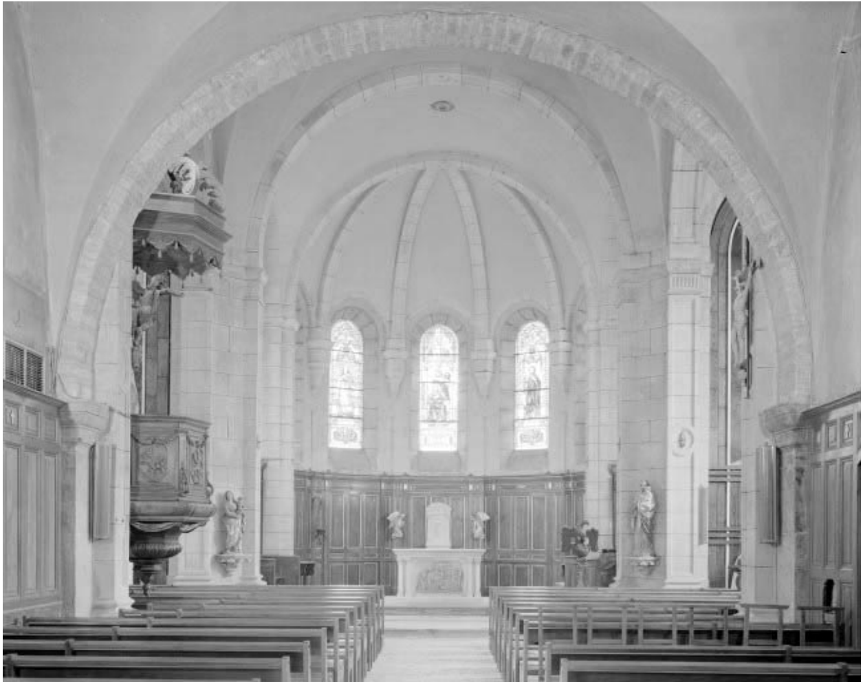
Intérieur vu depuis l'entrée.
