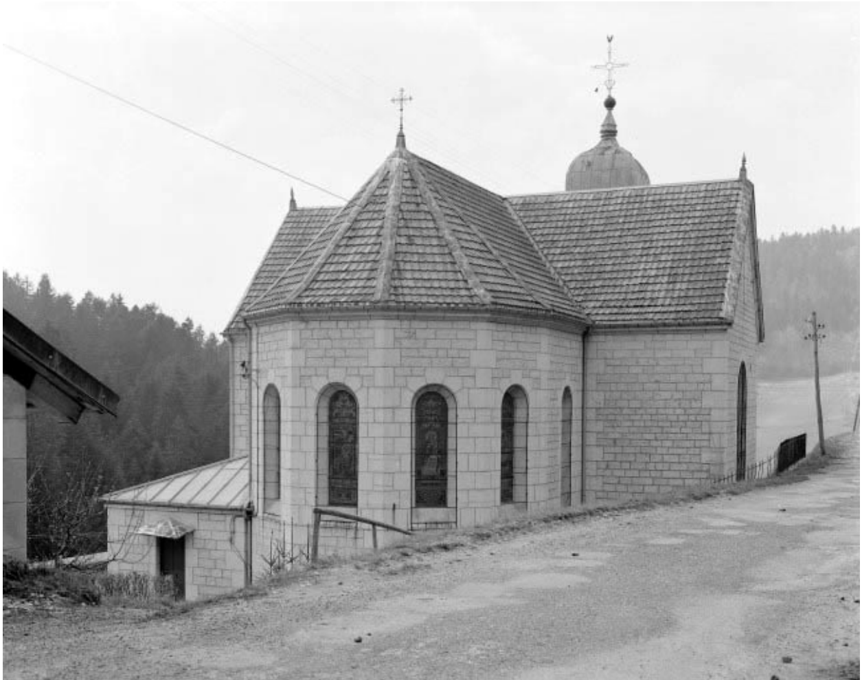
Extérieur : façade postérieure.
