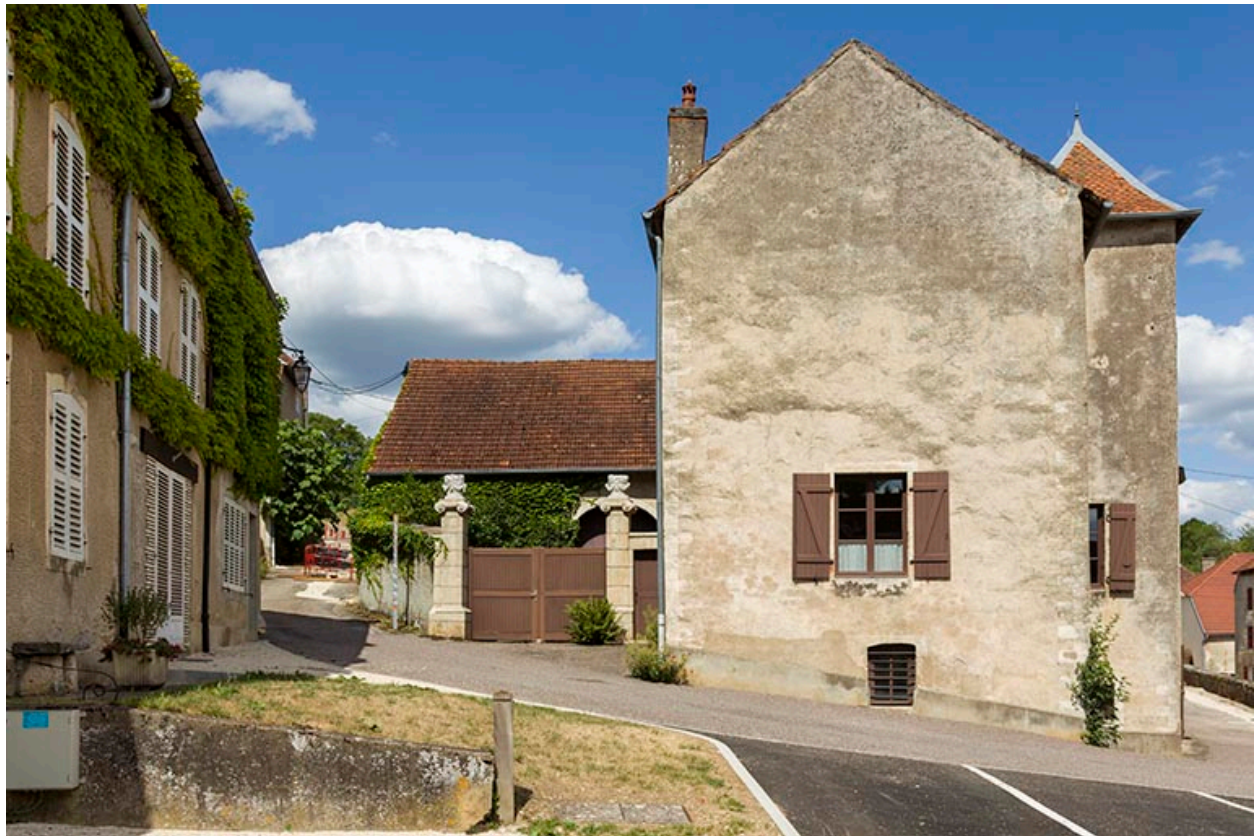
Vue générale depuis la place de l'Abondance.
