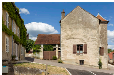
Vue générale depuis la place de l'Abondance.
