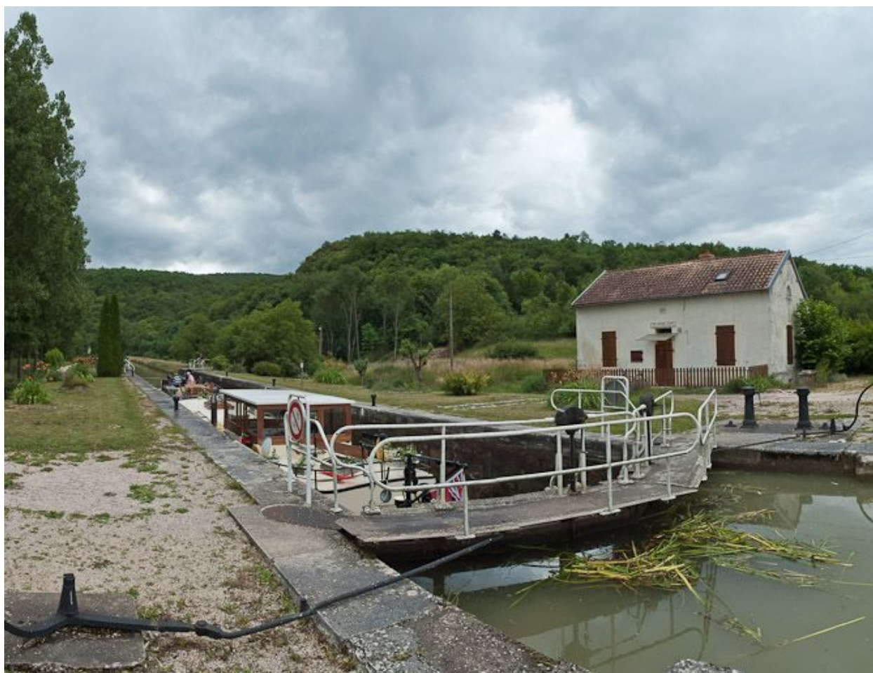
Vue d'ensemble du site d'écluse.
