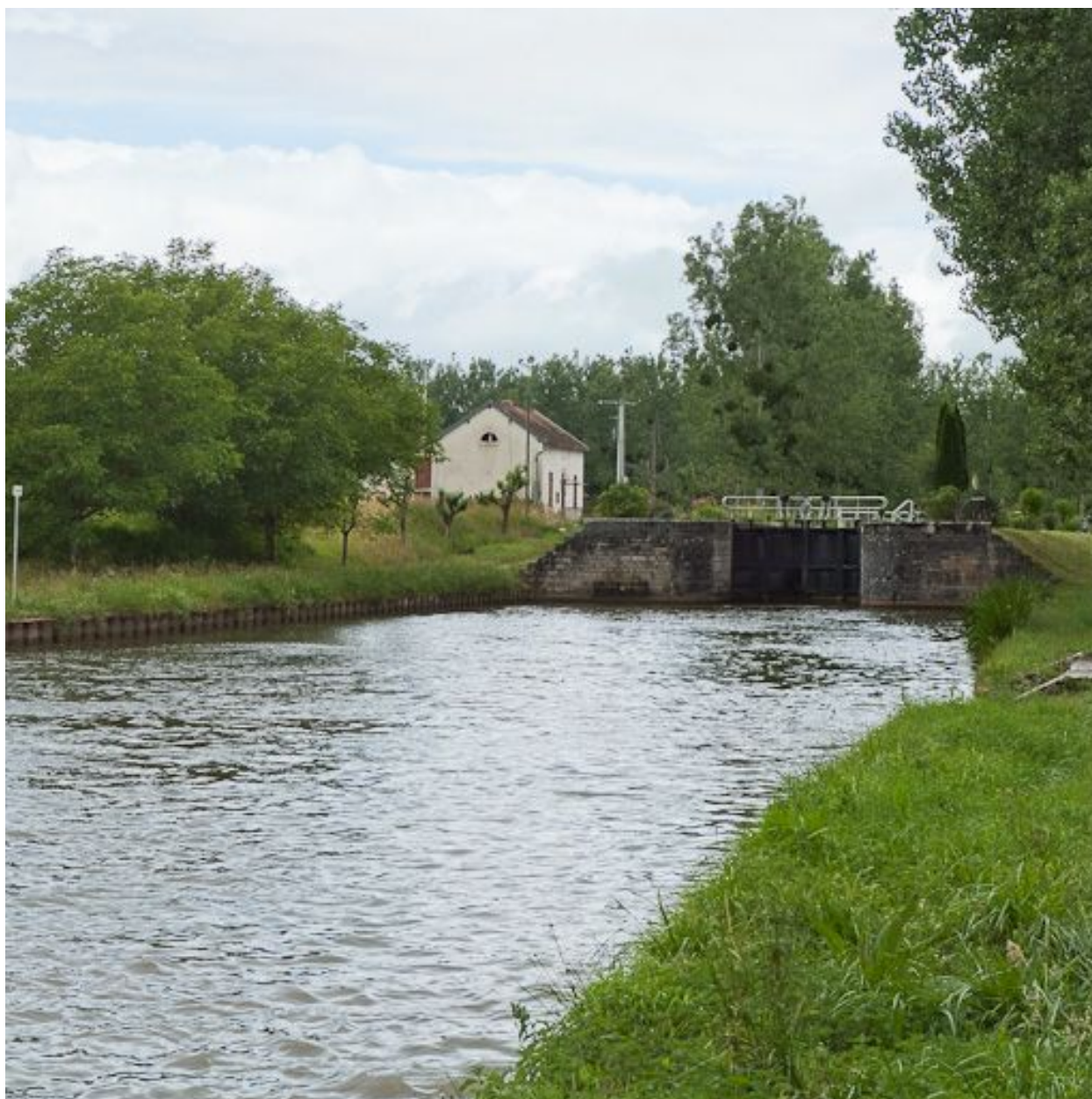
Site d'écluse vu depuis l'aval.
