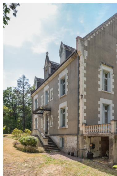
Façade sud-est, vue depuis l'est. Phot. Pierre-Marie Barbe-Richaud IVR26_20195800488NUC4A
