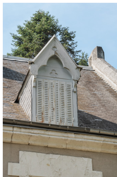
Lucarne de droite du versant sud-est de la toiture. Phot. Pierre-Marie Barbe-Richaud IVR26_20195800493NUC4A
