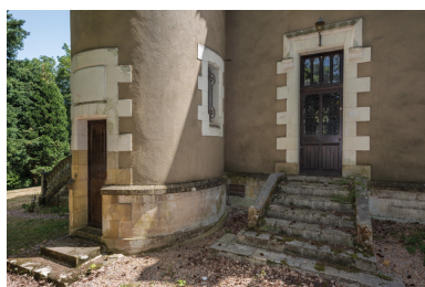
Perron de la façade nord-ouest et tour. Phot. Pierre-Marie Barbe-Richaud IVR26_20195800529NUC4A
