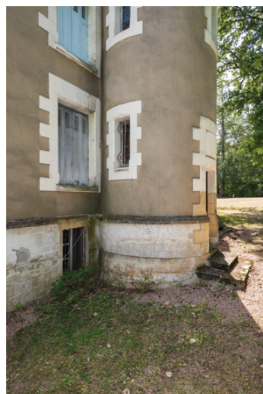
Partie inférieure de la tour d'escalier. Phot. Pierre-Marie Barbe-Richaud IVR26_20195800530NUC4A
