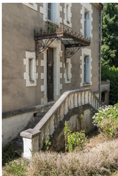
Perron de la façade sud-est. Phot. Pierre-Marie Barbe-Richaud IVR26_20195800491NUC4A
