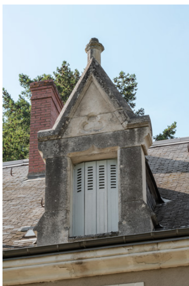
Lucarne centrale du versant sud-est de la toiture. Phot. Pierre-Marie Barbe-Richaud IVR26_20195800492NUC4A
