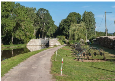
Vue rapprochée de l'écluse depuis l'aval. Phot. Pierre-Marie Barbe-Richaud IVR26_20122101902NUC4AQ
