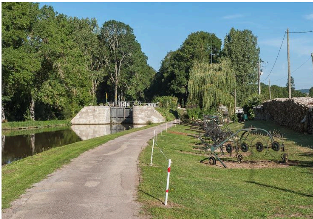
Vue rapprochée de l'écluse depuis l'aval.
