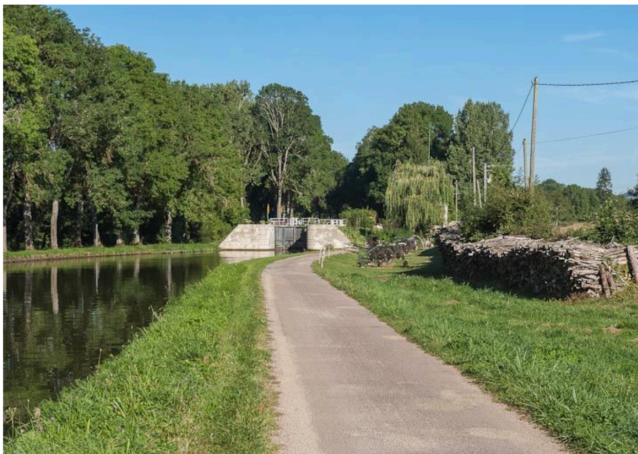
Vue de l'écluse depuis l'aval.
