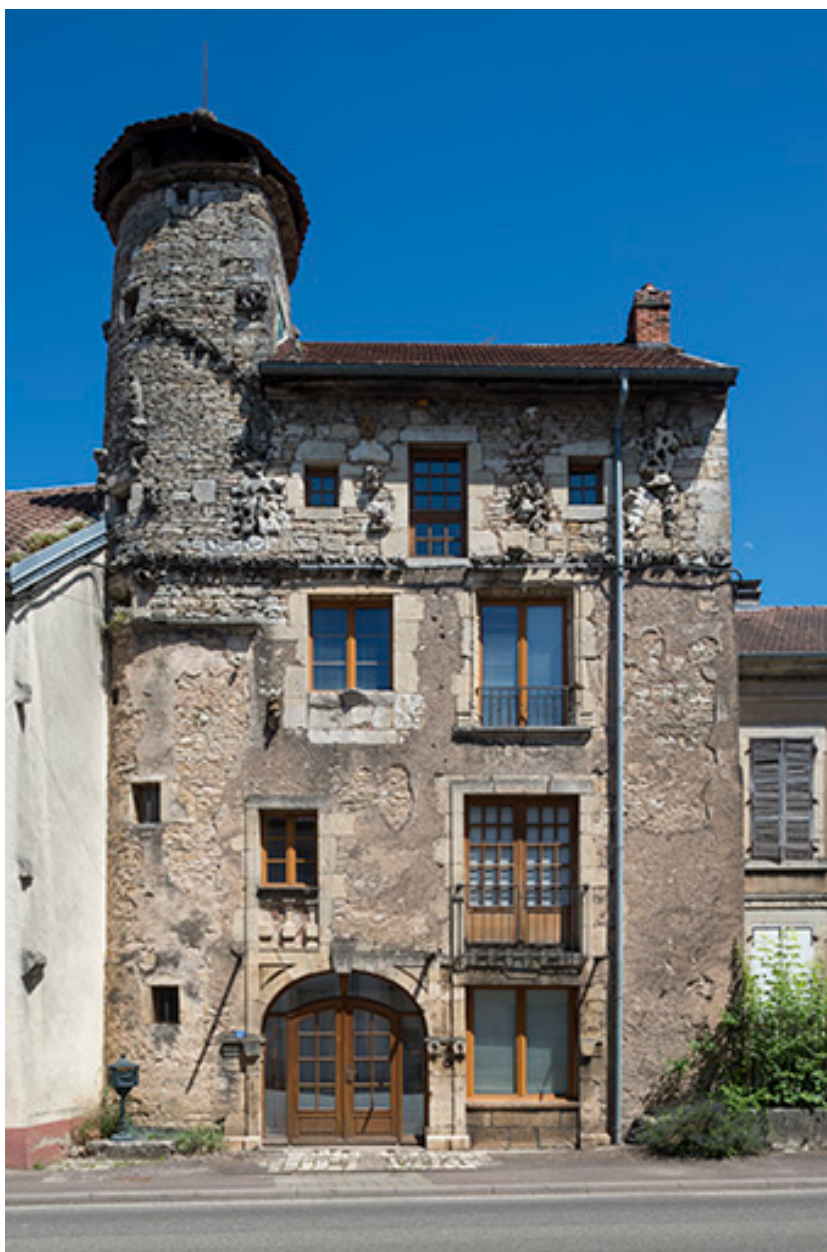
Élévation sur la rue Armand-Paulmard, vue de face.
