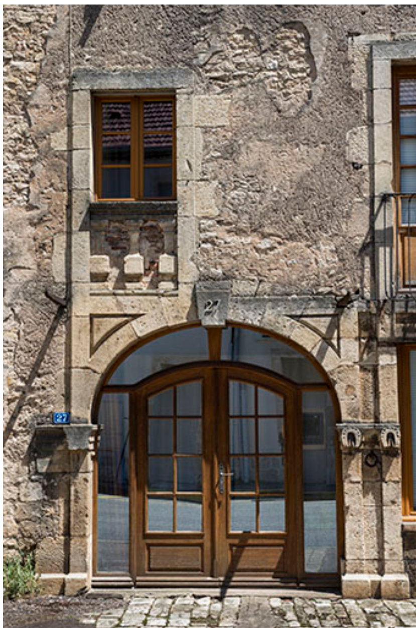
Baies du rez-de-chaussée et du premier étage.
