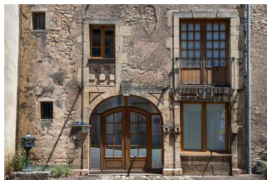
Baies du rez-de-chaussée et du premier étage. Phot. Jérôme Mongreville IVR43_20187000427NUC4A
