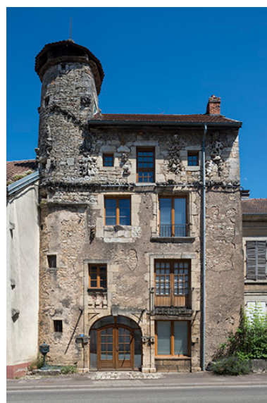
Élévation sur la rue Armand- Paulmard, vue de face. Phot. Jérôme Mongreville IVR43_20187000431NUC4A
