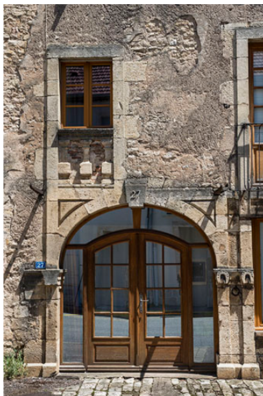
Baies du rez-de-chaussée et du premier étage. Phot. Jérôme Mongreville IVR43_20187000428NUC4A
