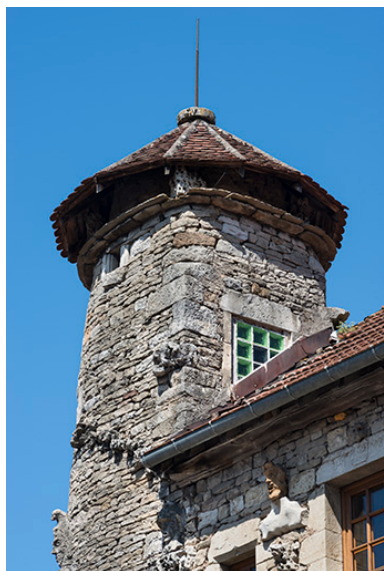
Dernier niveau et couverture de la tourelle. Phot. Jérôme Mongreville IVR43_20187000432NUC4A
