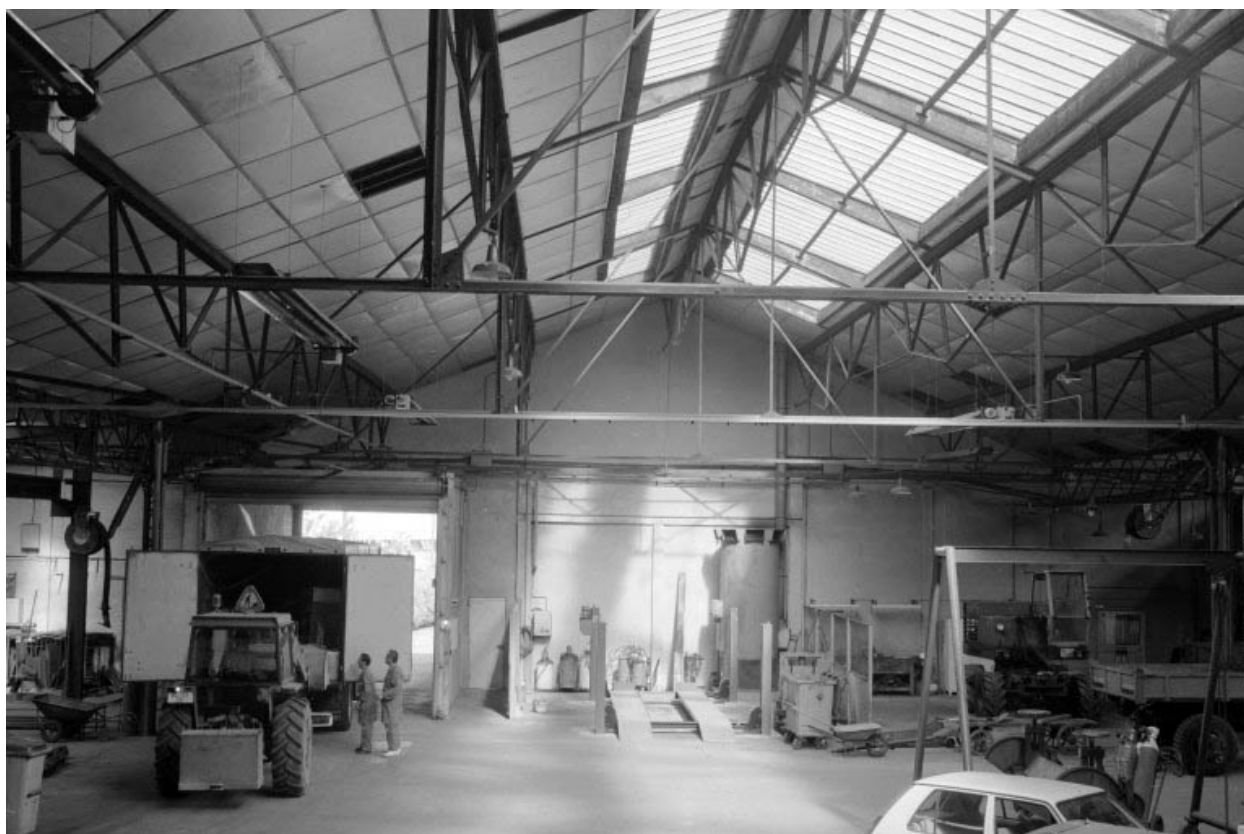
Intérieur de l'atelier de fabrication.
