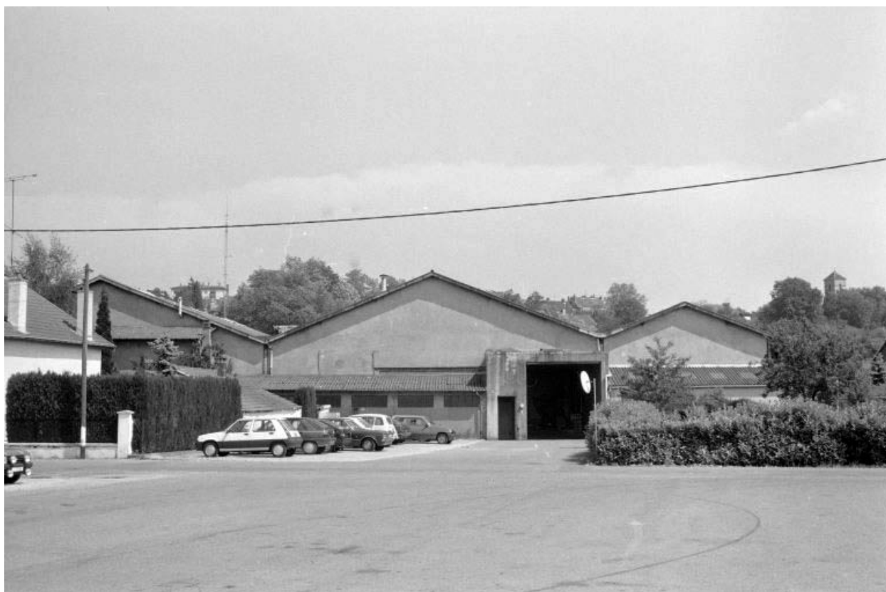
Façade postérieure vue de l'ouest.
