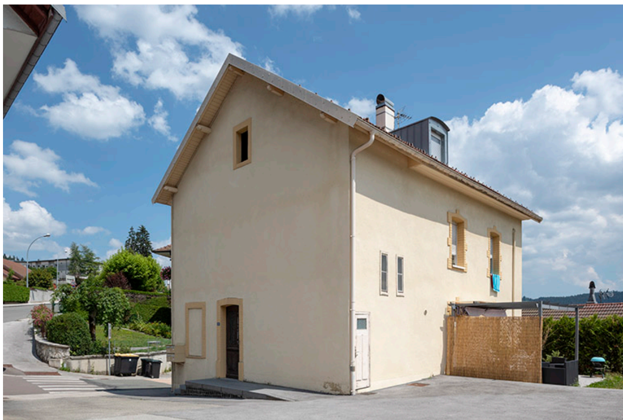
Façades postérieure et latérale droite.
