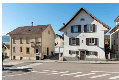
Vue d'ensemble, depuis le nord. Phot. Sonia Dourlot IVR43_20182501046NUC4A
