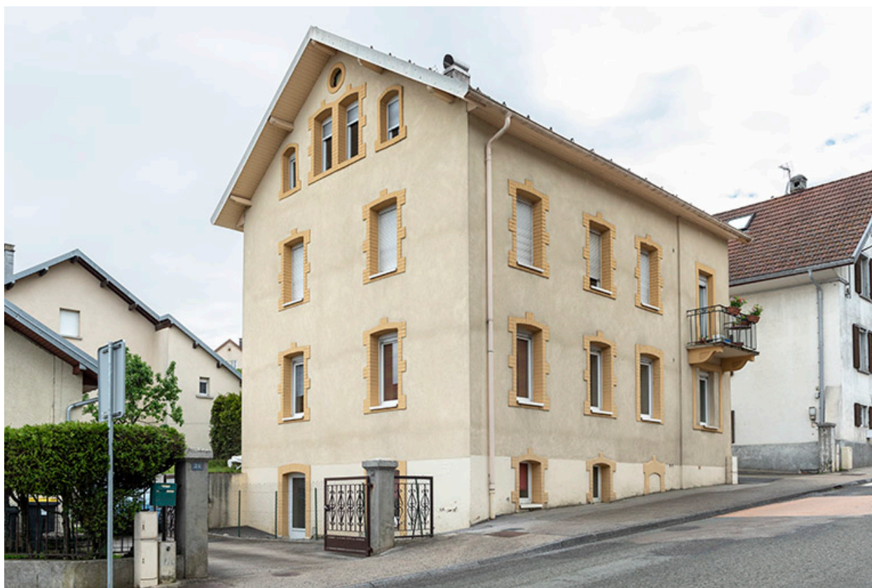
Façades antérieure et latérale gauche.
