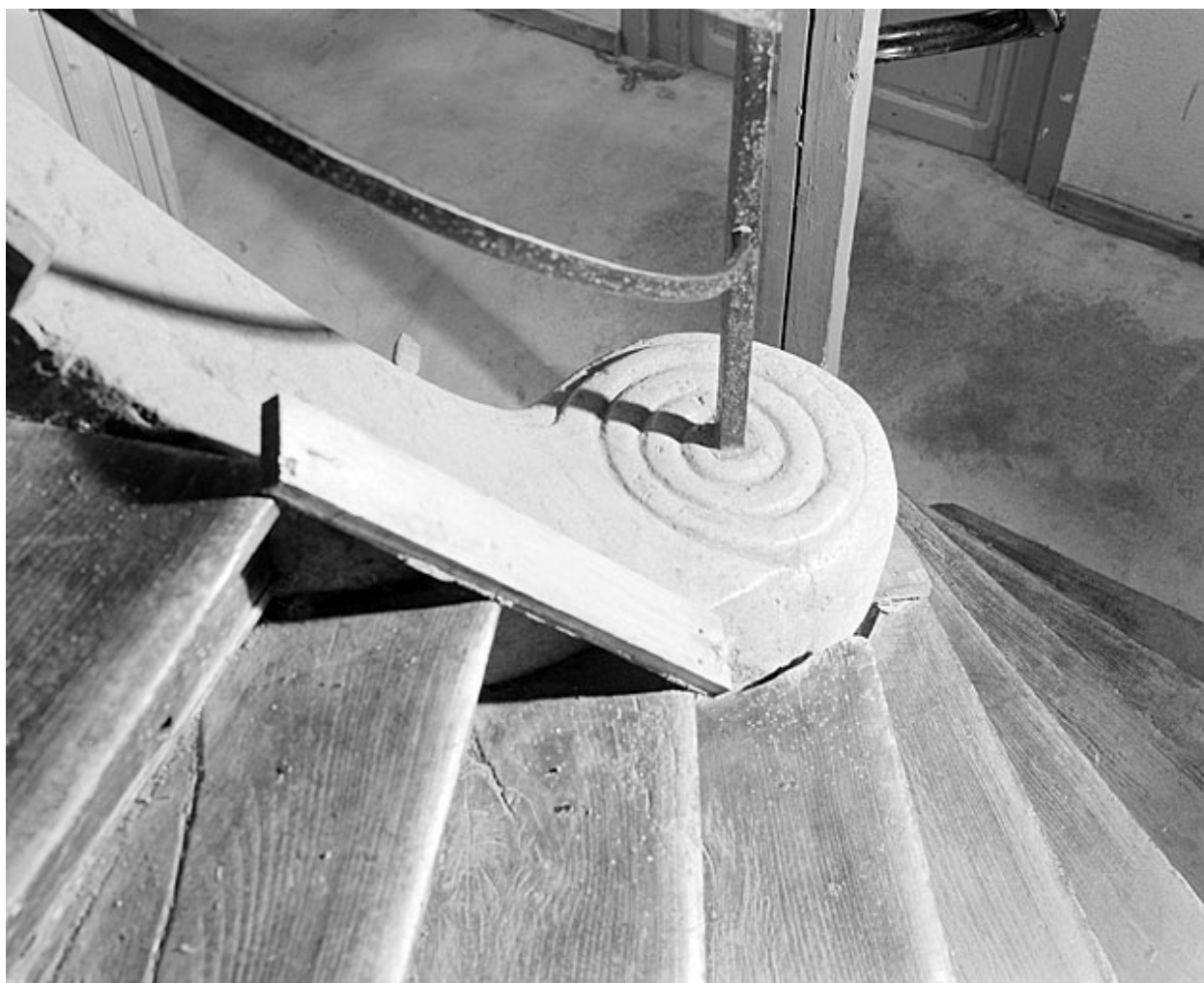
Escalier tournant : départ de la rampe d'appui.
