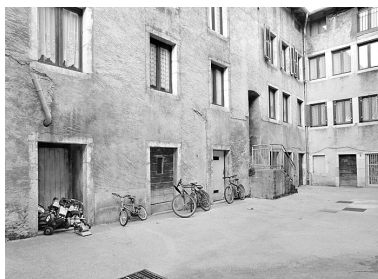
Corps de bâtiment occidental (communs et logements). Phot. Yves Sancey IVR43_20033900390X
