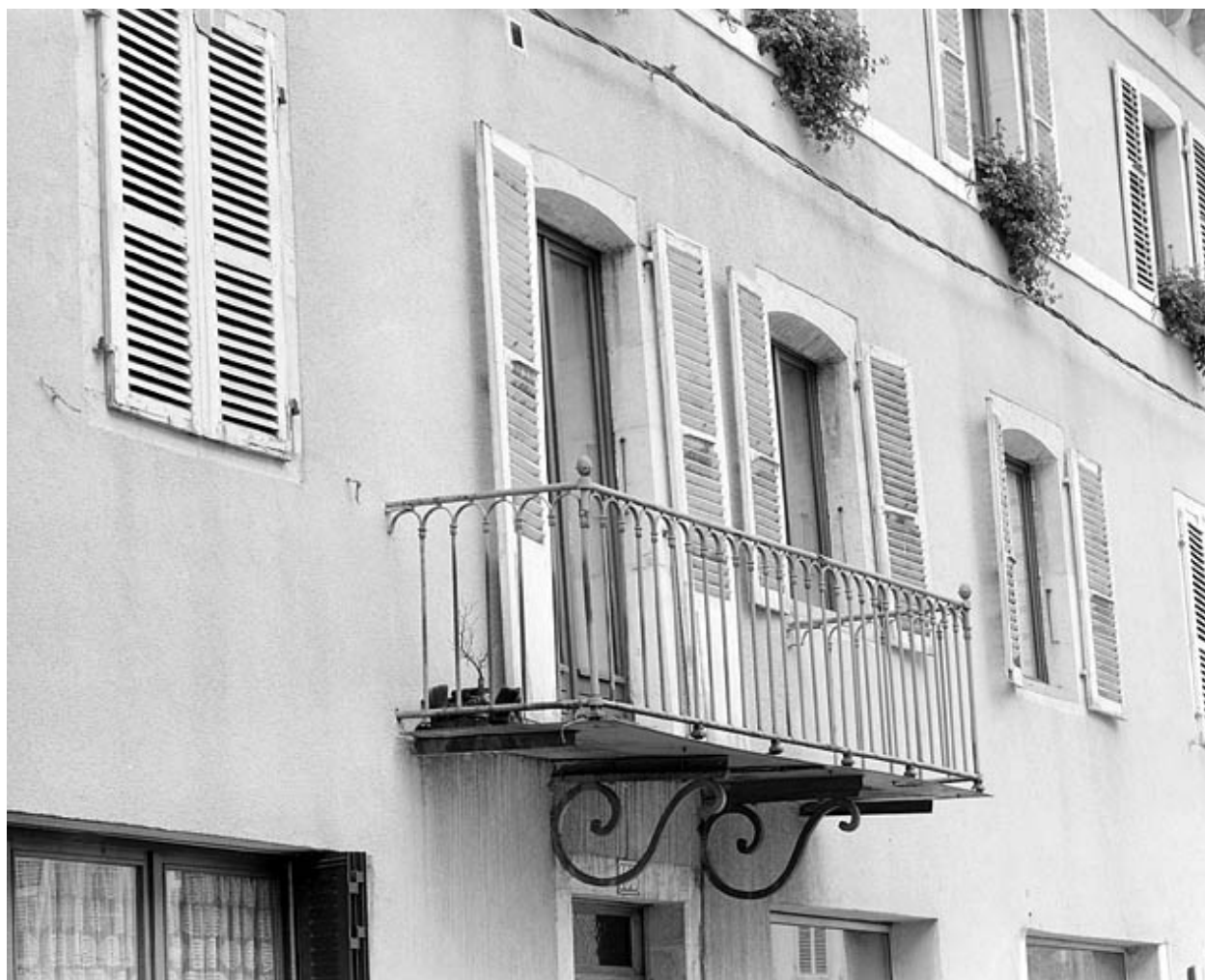
Balcon de la porte-fenêtre centrale.
