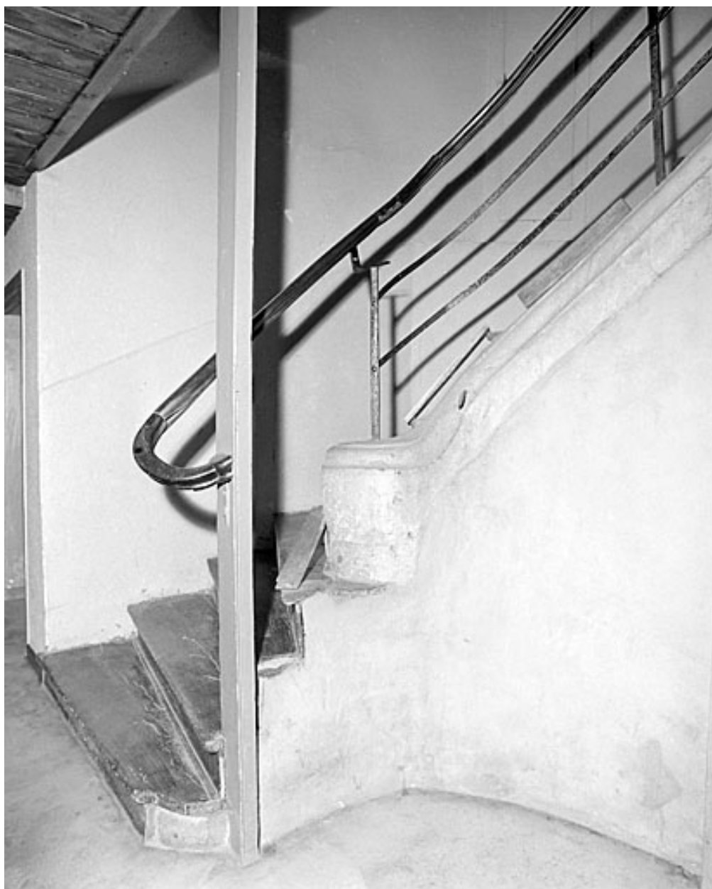
Escalier tournant : première volée.
