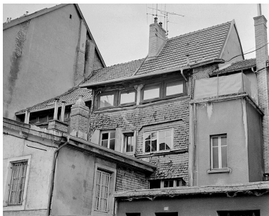
Galeries donnant sur l'ancienne cour. Phot. Jérôme Mongreville IVR43_19872500561X
