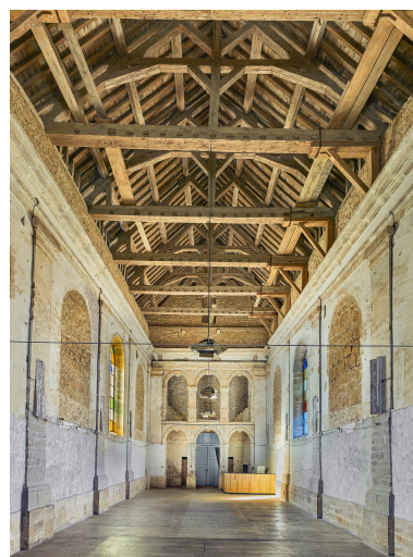
La nef, la charpente et la tribune.
