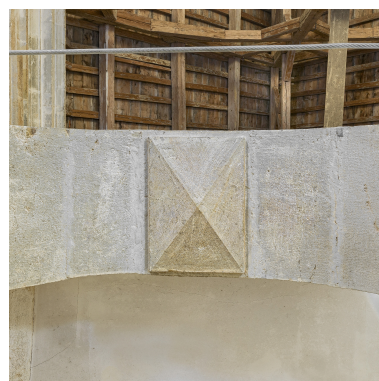
Détail de la clé de voûte de la tribune. Phot. Thierry Kuntz IVR43_20213900340NUC4A
