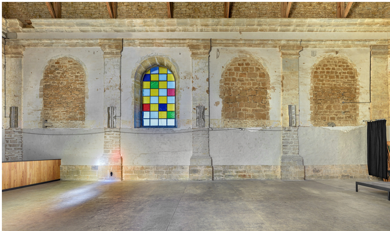
Mur latéral de la nef.
