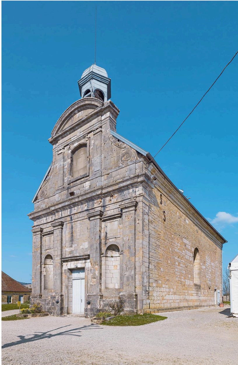
Façades antérieure et latérale droite.
