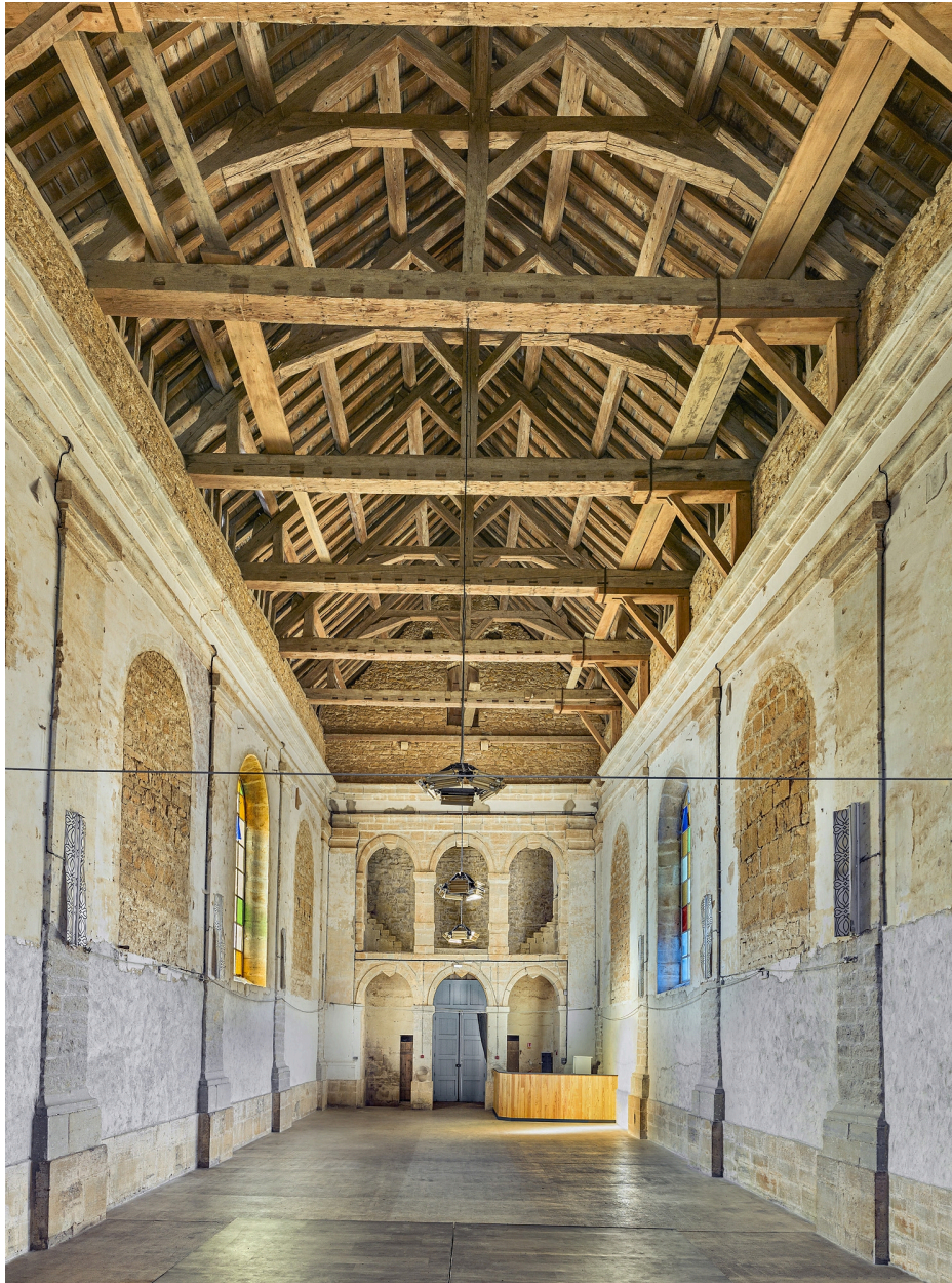
La nef, la charpente et la tribune.
