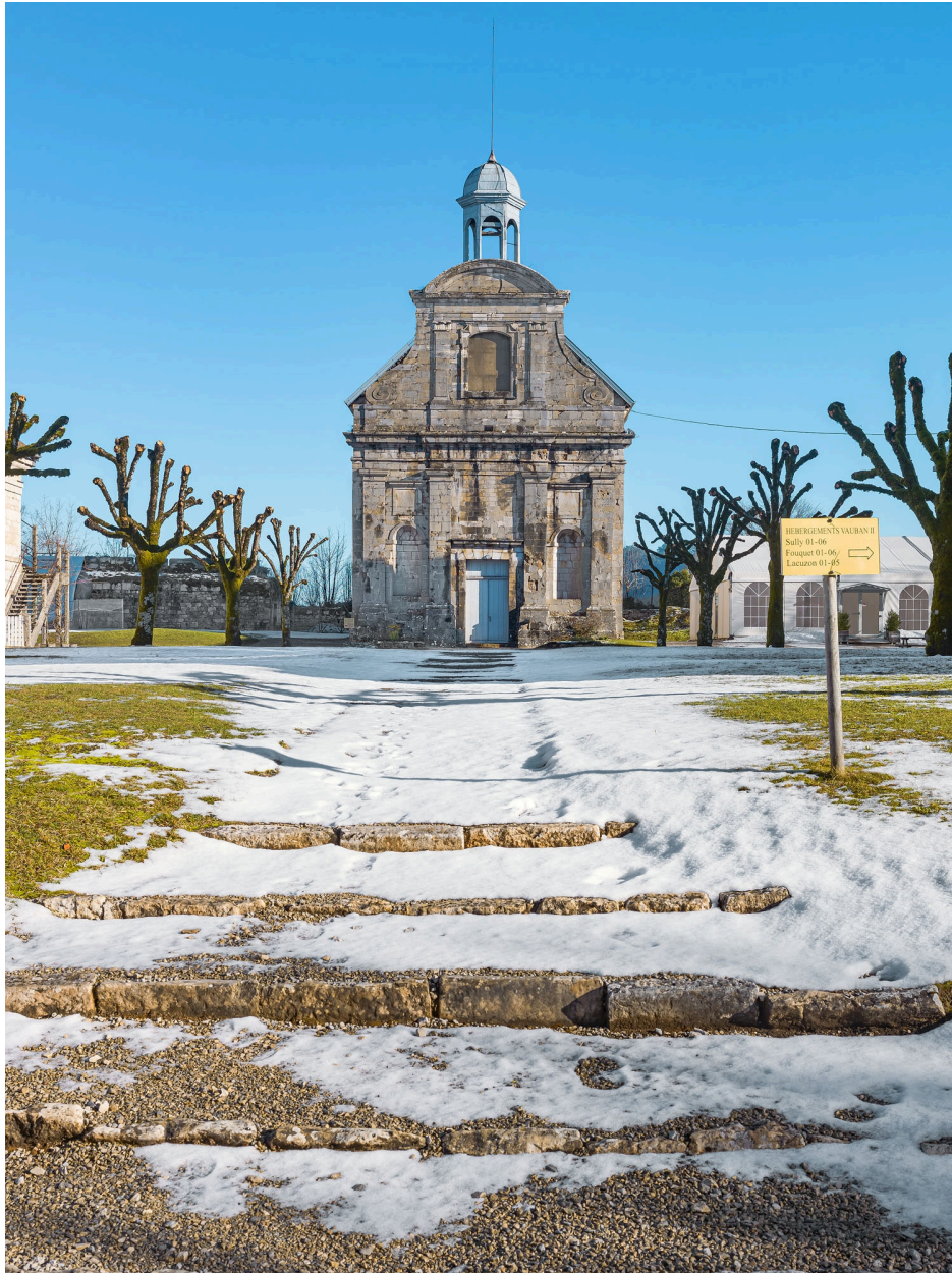
Façade principale de la chapelle depuis la place d'armes.
