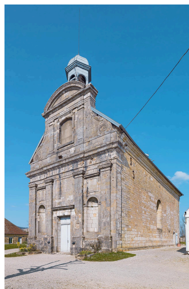
Façades antérieure et latérale droite. Phot. Thierry Kuntz IVR43_20223900567NUC4A
