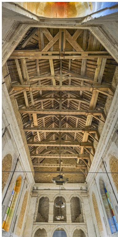
La charpente : détail. Phot. Thierry Kuntz IVR43_20213900330NUC4A
