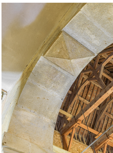
Clé de voûte de l'arcade centrale de la tribune. Phot. Thierry Kuntz IVR43_20213900338NUC4A
