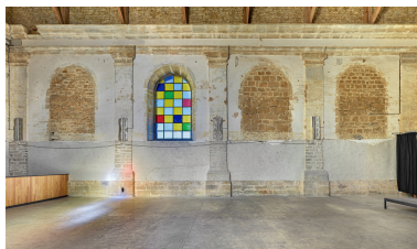
Mur latéral de la nef. Phot. Thierry Kuntz IVR43_20213900336NUC4A
