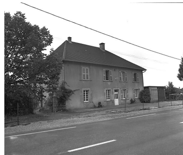
Maison située 21 route de Besançon. Phot. Yves Sancey IVR43_19802501179X
