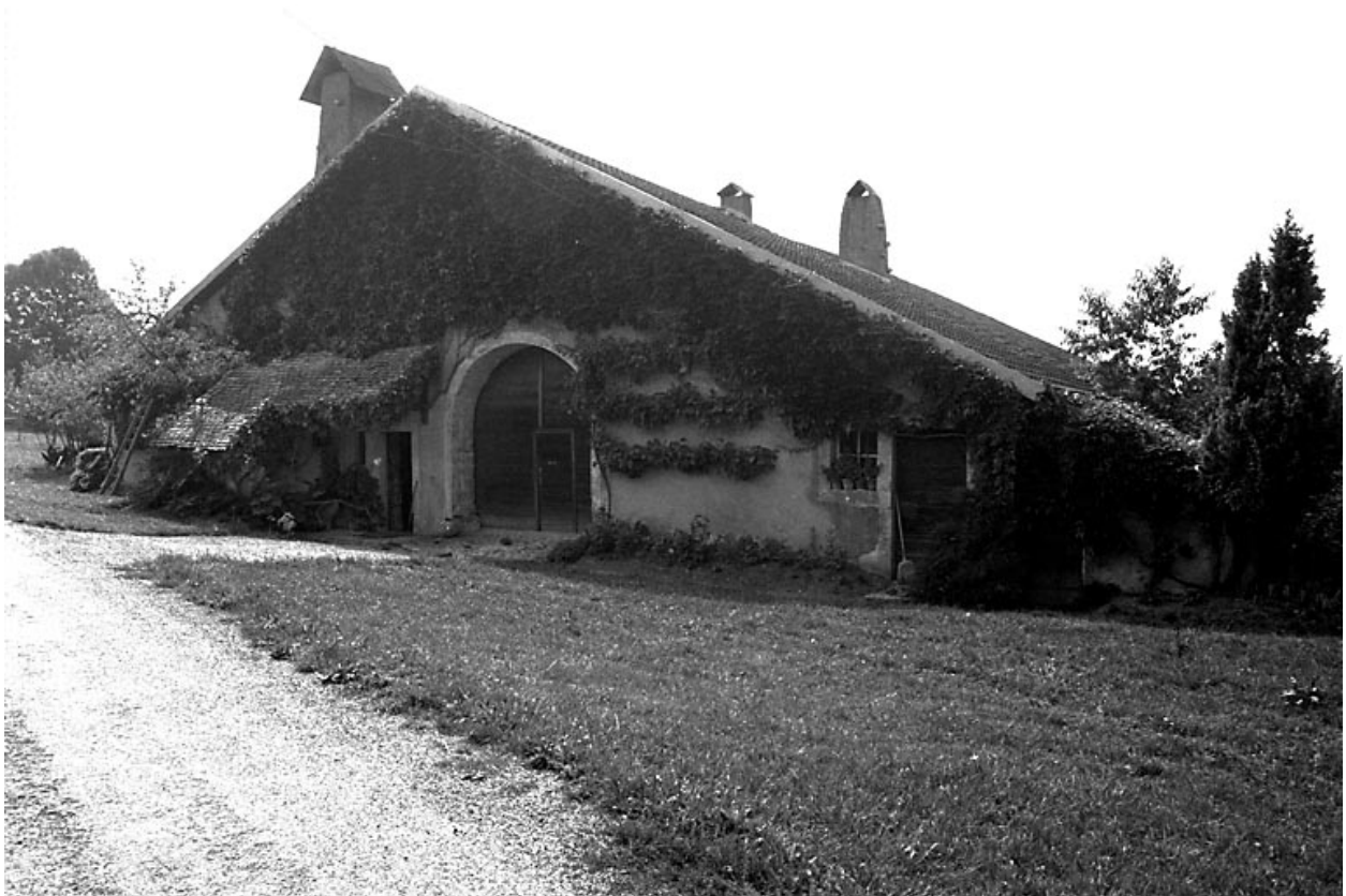
Ferme située au lieudit Bois-Vieille.
