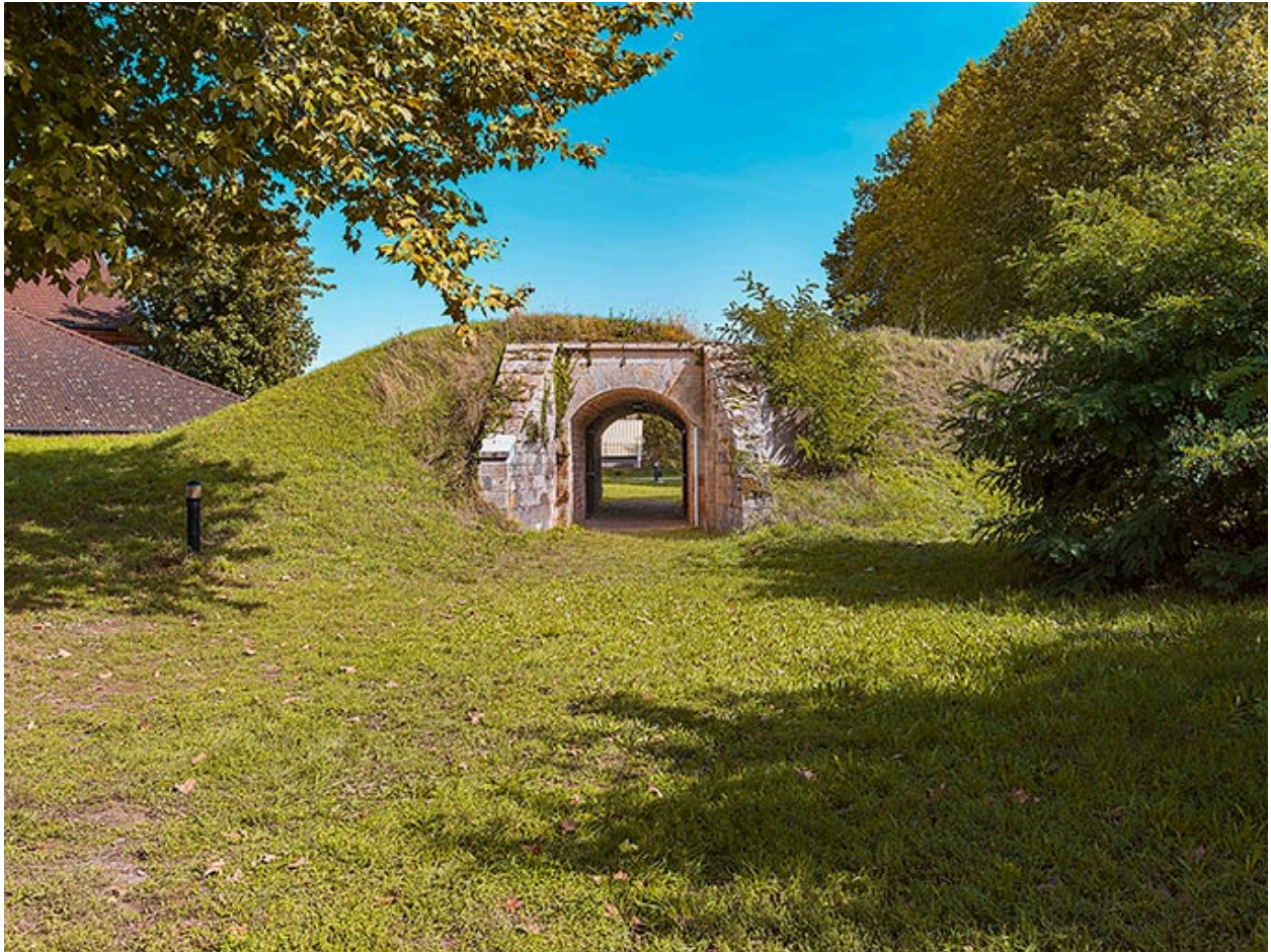
Passage entre le terre-plein du bastion et sa gorge.
