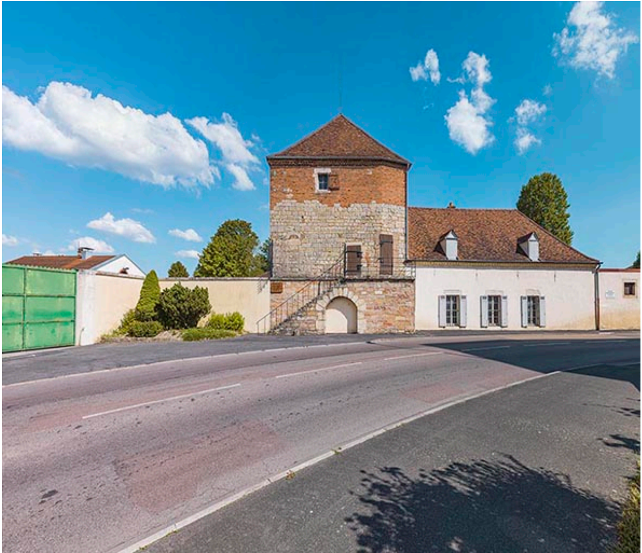
La tour Belvoir, face côté gorge.
