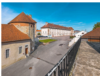
La tour Belvoir et les casernes d'infanterie. Phot. Thierry Kuntz IVR26_20232100195NUC4A
