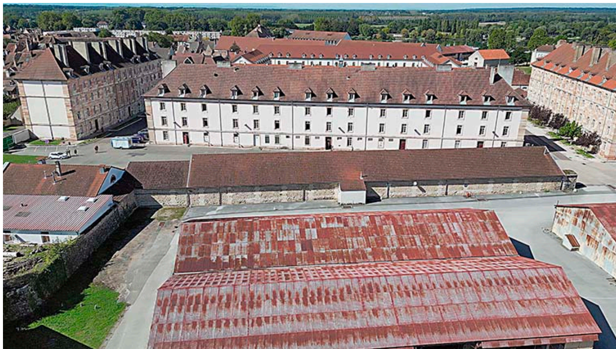
Vue aérienne du rempart reliant les bastions du Gouverneur et du Cygne.
