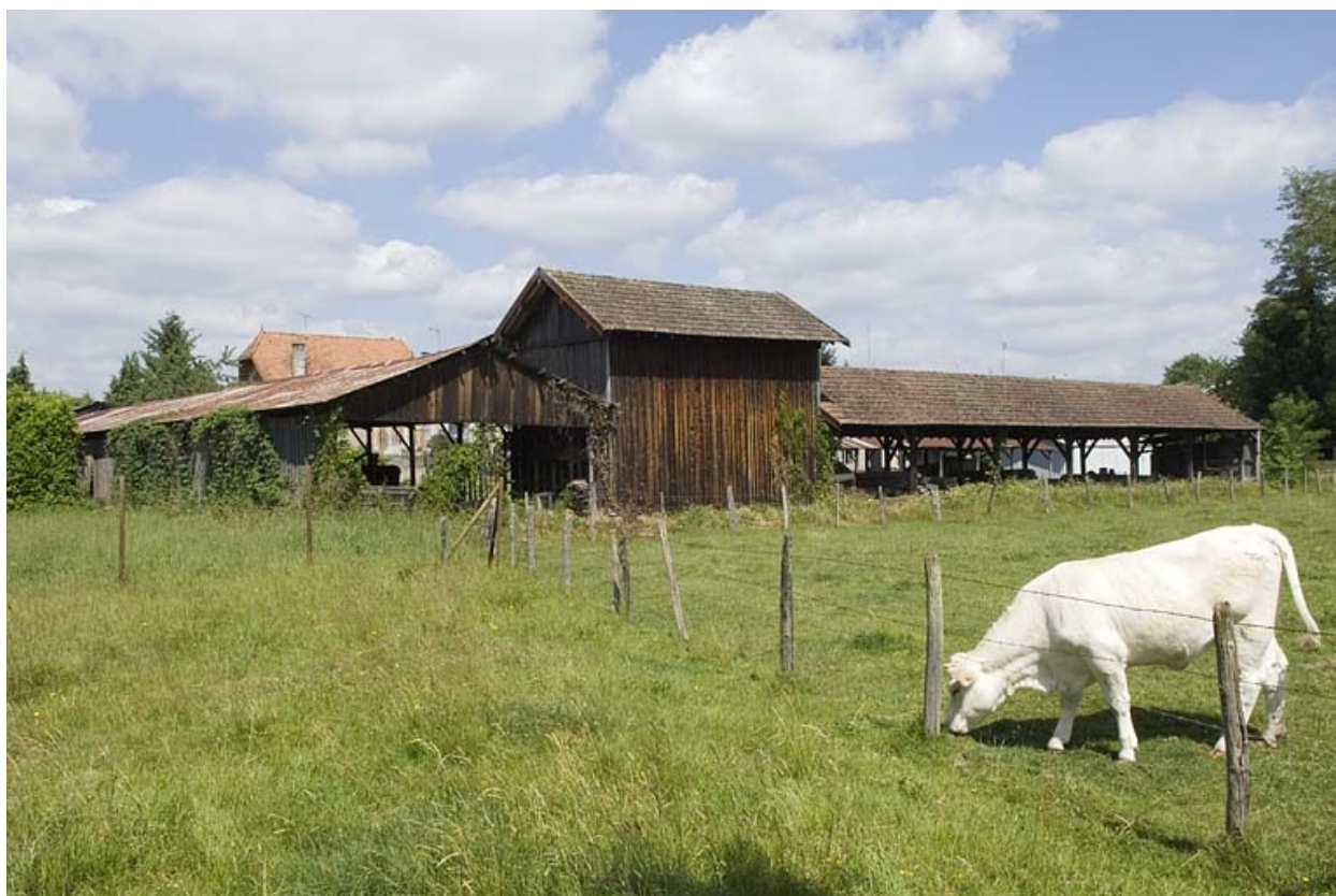
Entrepôts industriels depuis le sud.
