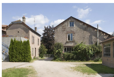
Logement et bâtiment du moulin. Phot. Jérôme Mongreville IVR43_20097000429NUC2A
