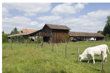
Entrepôts industriels depuis le sud. Phot. Jérôme Mongreville IVR43_20097000434NUC2A
