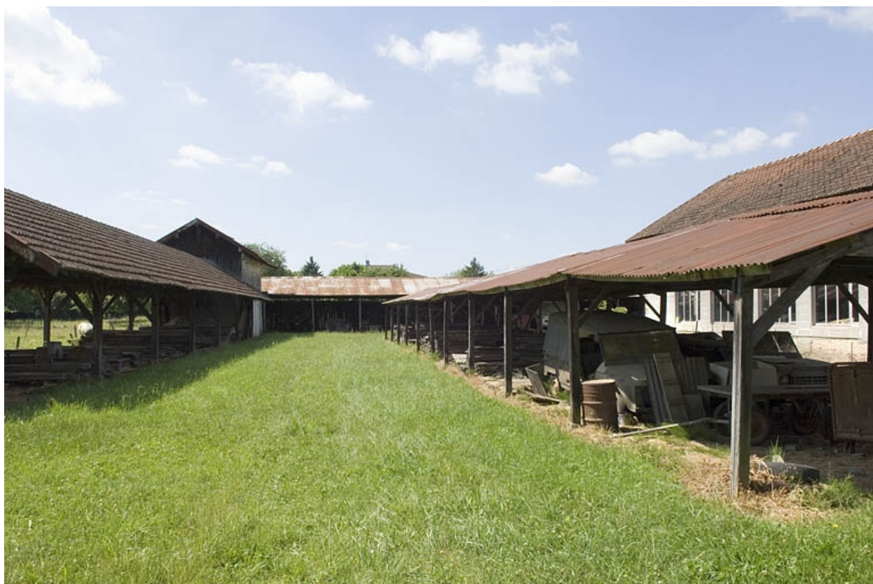
Entrepôts industriels sud.
