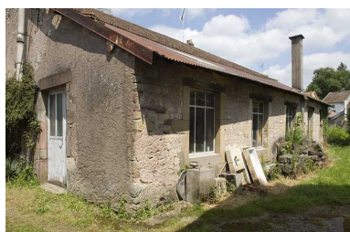
Façade sud de l'ancien moulin. Phot. Jérôme Mongreville IVR43_20097000442NUC2A
