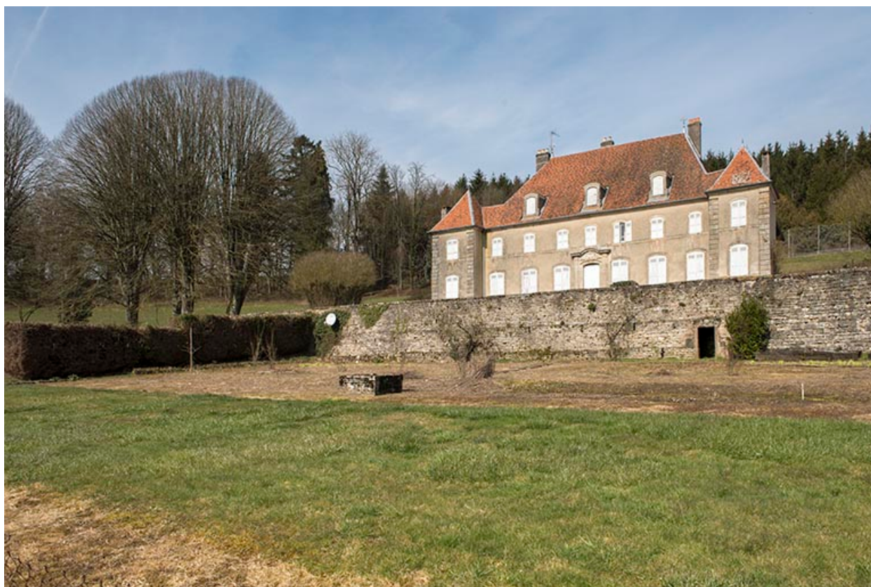
Façade antérieure (sud) du château.
