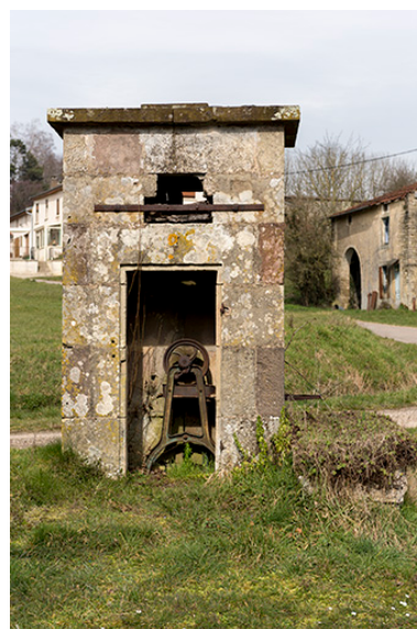
Vue de face (sud) de la fontaine. Phot. Sonia Dourlot IVR43_20177000548NUC4A
