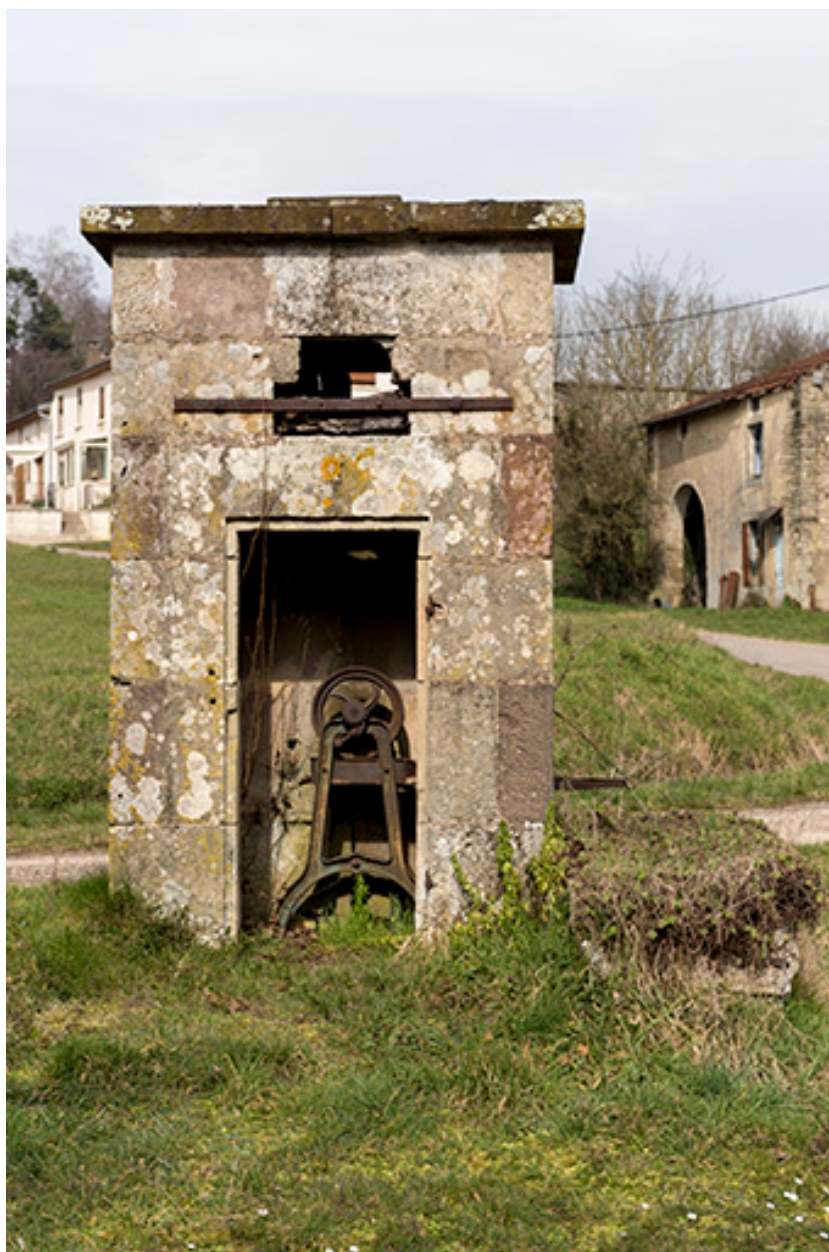
Vue de face (sud) de la fontaine.
