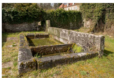
vue de l'est de l'ancien lavoir. Phot. Sonia Dourlot IVR43_20177000547NUC4A
