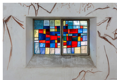
Vue d'une verrière (baie 5). Phot. Pierre-Marie Barbe-Richaud IVR26_20248900186NUC4A
