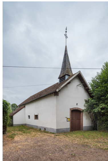
Vue des façades est (antérieure) et sud. Phot. Pierre-Marie Barbe-Richaud IVR26_20238901120NUC4A
