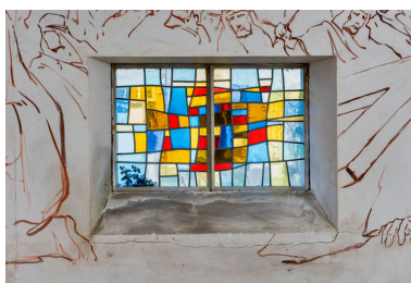
Vue d'une verrière (baie 1). Phot. Pierre-Marie Barbe-Richaud IVR26_20248900184NUC4A
