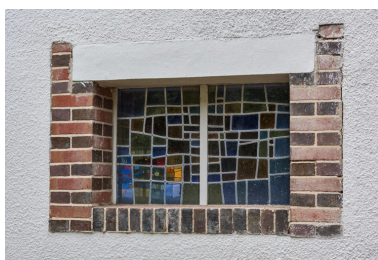
Vue extérieure d'une baie. Phot. Pierre-Marie Barbe-Richaud IVR26_20238901123NUC4A
