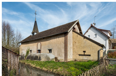
Vue de la façade nord. Phot. Pierre-Marie Barbe-Richaud IVR26_20248900206NUC4A
