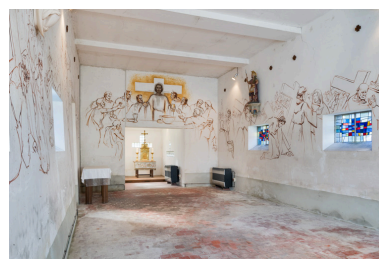
Vue de la nef (de trois quarts). Phot. Pierre-Marie Barbe-Richaud IVR26_20248900176NUC4A
