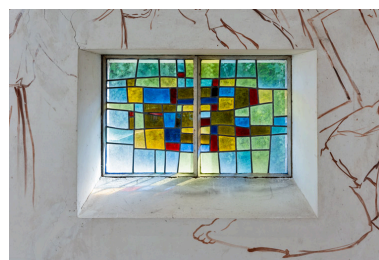
Vue d'une verrière (baie 2). Phot. Pierre-Marie Barbe-Richaud IVR26_20248900183NUC4A
