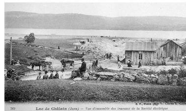
Lac de Châlain (Jura) - Vue d'ensemble des travaux de la Société électrique. Phot. , Phot. Raoul Chapuis IVR43_19883900427X
