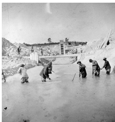
Prise d'eau vue d'amont [délayage de la marn]. Phot. IVR43_19913900222X
