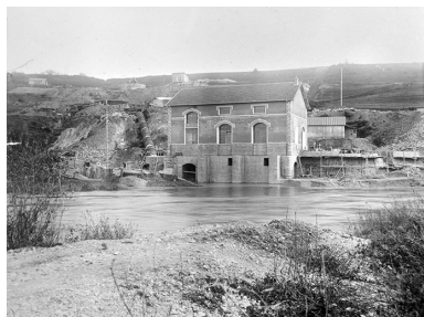
Centrale et conduite forcée en cours d'achèvement. Phot. IVR43_19913900218X
