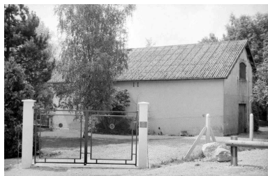
Bâtiment de prise d'eau. Phot. Laurent Poupard IVR43_19923901358Z
