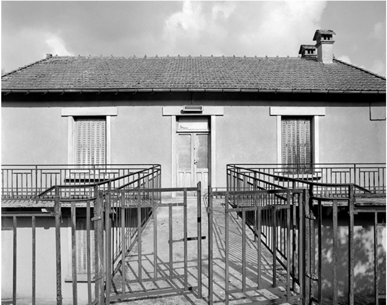
Façade antérieure du logement d'ouvriers.
