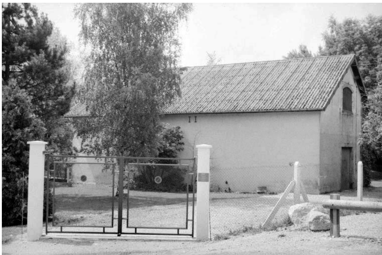
Bâtiment de prise d'eau.
