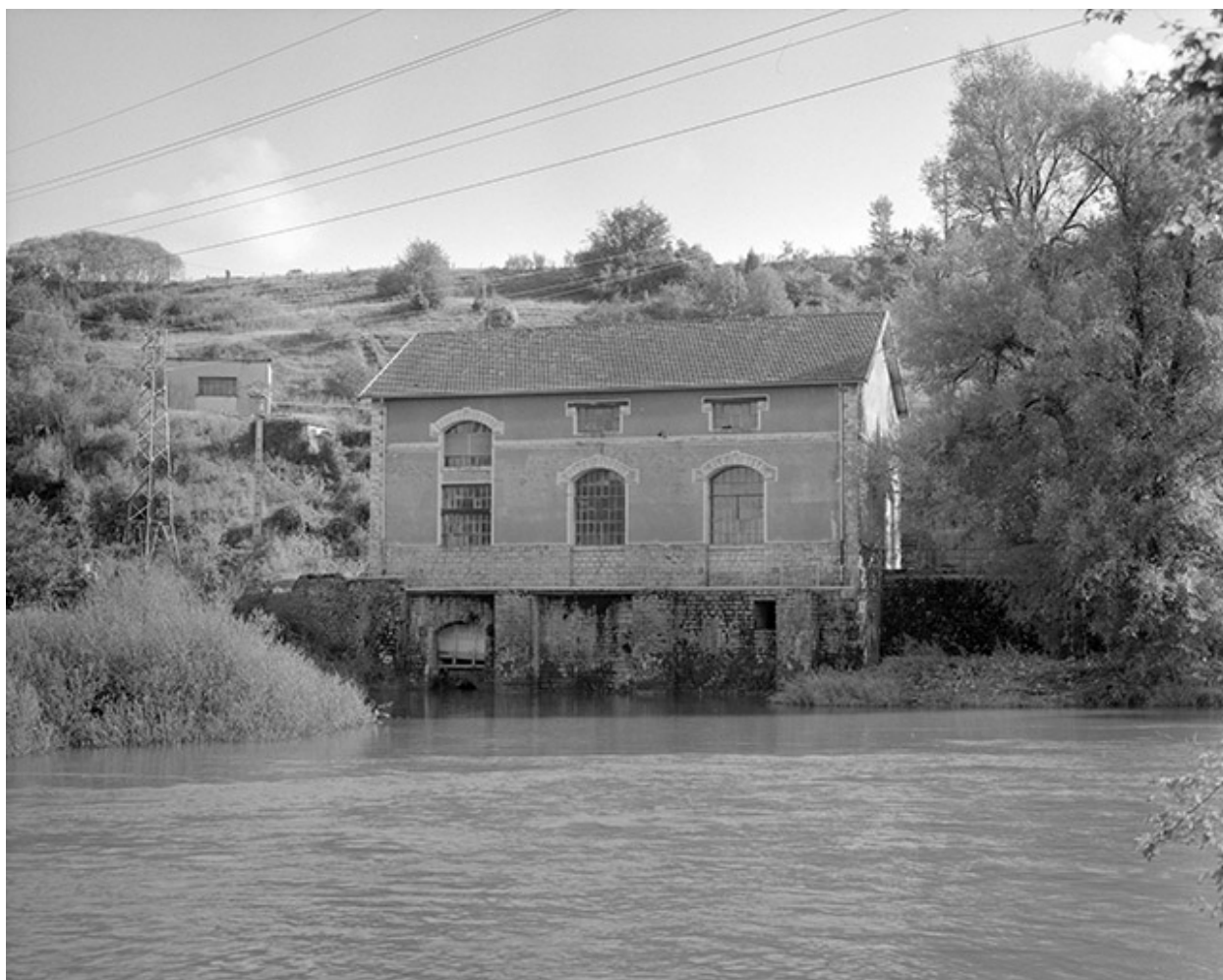
Façade postérieure de la centrale.
