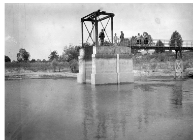
Prise d'eau au Lac de Chalain. Phot. IVR43_19913900219X
