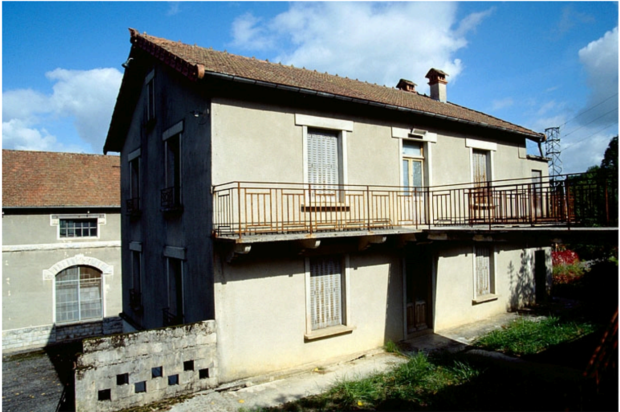
Façade antérieure du logement d'ouvriers, de trois quarts gauche.
