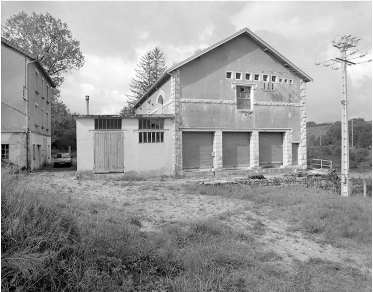
Façade latérale droite de la centrale.
