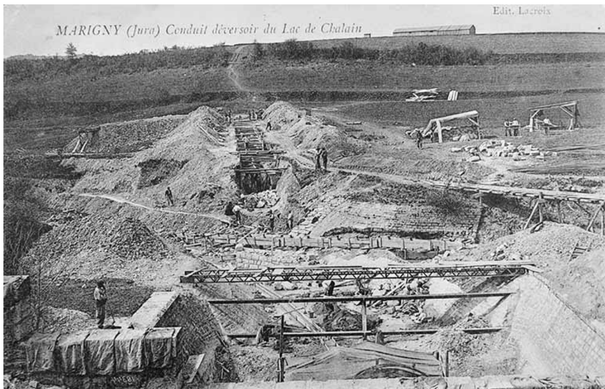
Marigny (Jura). Conduit déversoir du Lac de Chalain [le chantier vu depuis le haut de la conduite].
