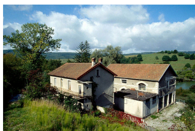
Vue d'ensemble depuis le sud-est. Phot. Jérôme Mongreville IVR43_19913900616ZA
