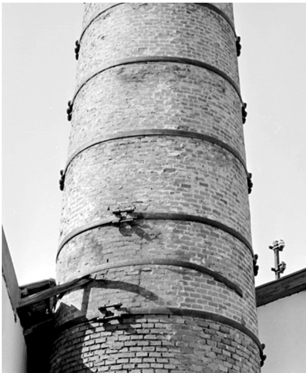
Détail de la cheminée : cerclages métalliques.
