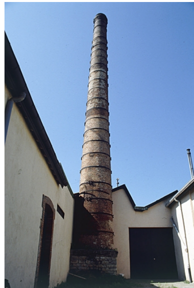
Cheminée. Phot. Yves Sancey IVR43_20009000261ZA
