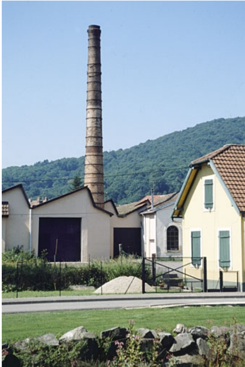
Ateliers de fabrication et cheminée depuis l'est.
