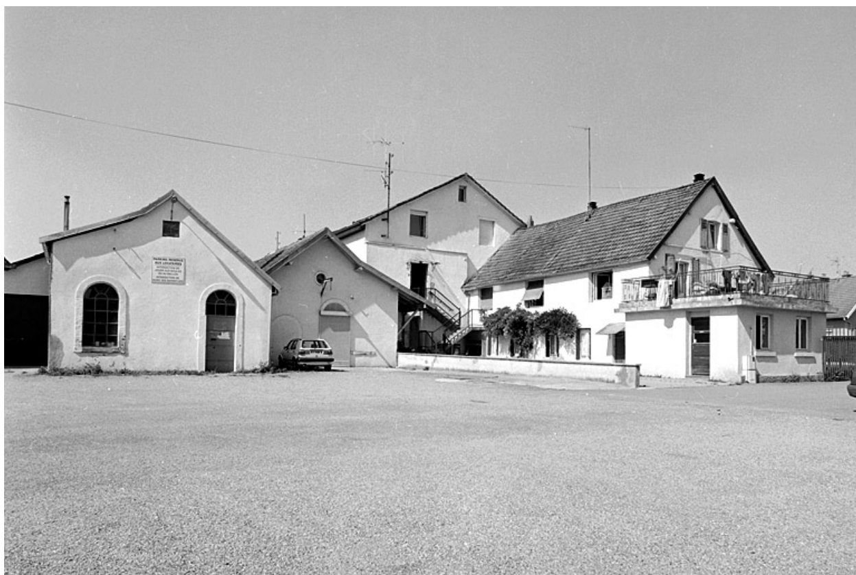
Pignons des ateliers depuis la cour.
