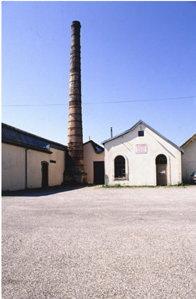
Cheminée et salle des machines.
