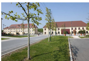
Usine textile Japy à Audincourt. Phot. Jérôme Mongreville IVR43_20112501139NUC4A
