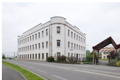
Immeuble de bureaux de l'usine Peugeot de Beaulieu-Mandeure. Phot. Jérôme Mongreville IVR43_20122501088NUC4A
