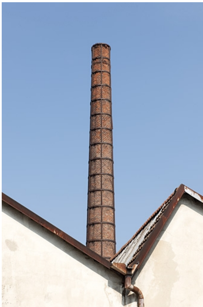
Cheminée de l'usine métallurgique de Berne (Seloncourt).
