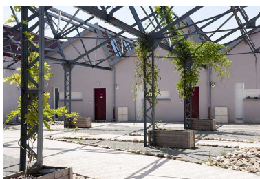
Ancienne usine d'équipement industriel de la SCEMAS (Seloncourt). Reconversion en logements. Phot. Jérôme Mongreville IVR43_20112501487NUC4A
