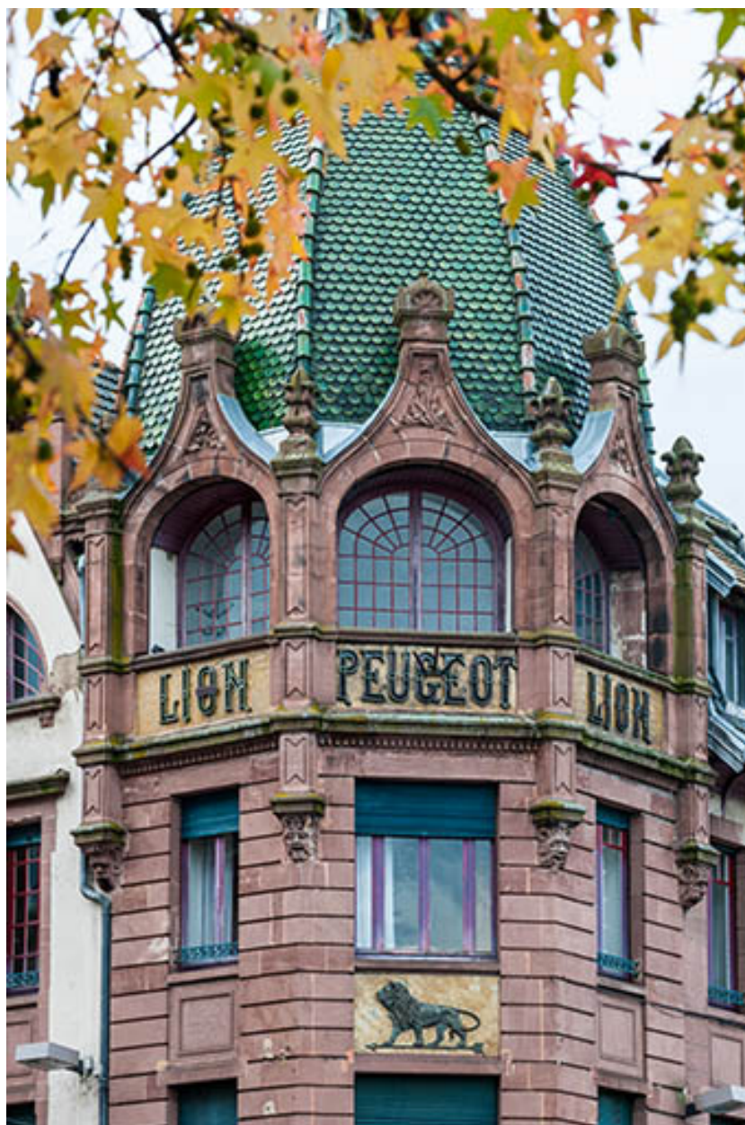
Immeuble Peugeot, 37 rue Cuvier à Montbéliard.
