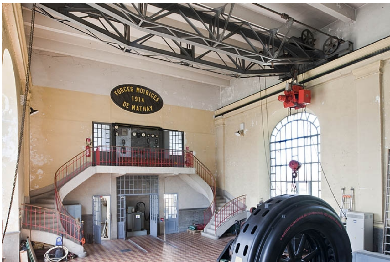
Centrale hydroélectrique de Mathay.
