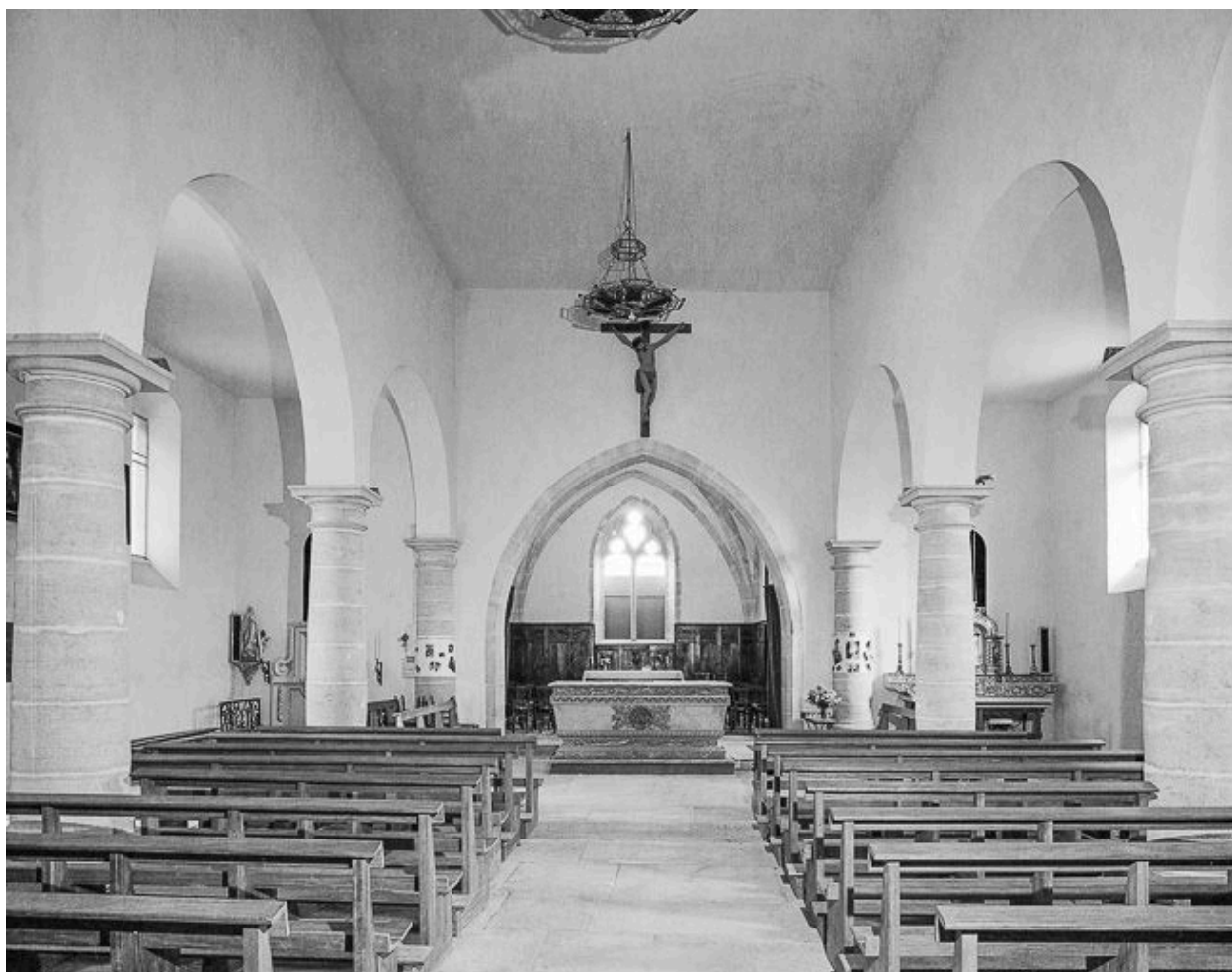
Intérieur : nef et chœur vus depuis l'entrée.
