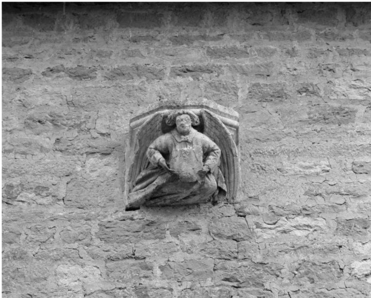
Façade antérieure : console gauche.
