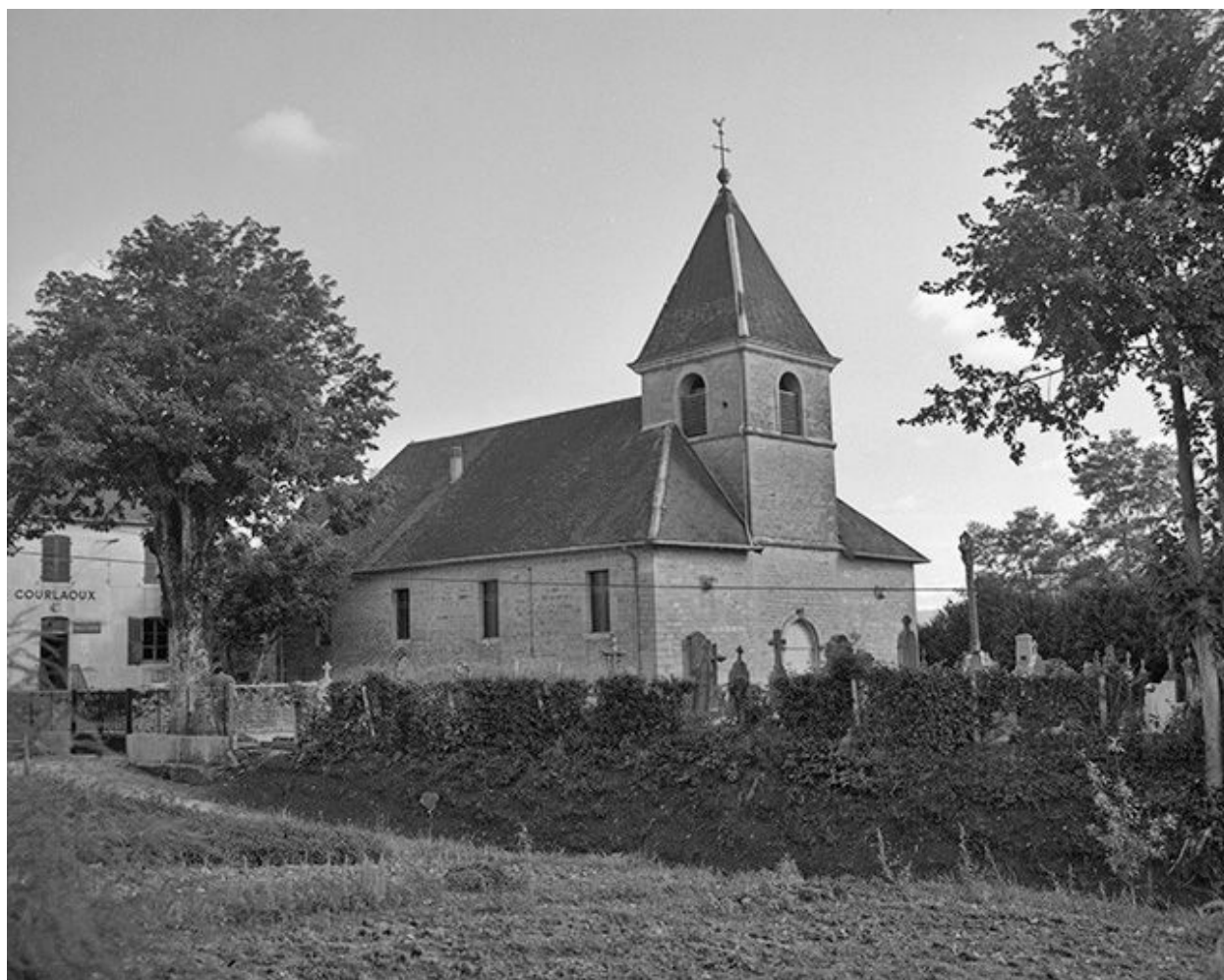
Extérieur : façade antérieure et face gauche.
