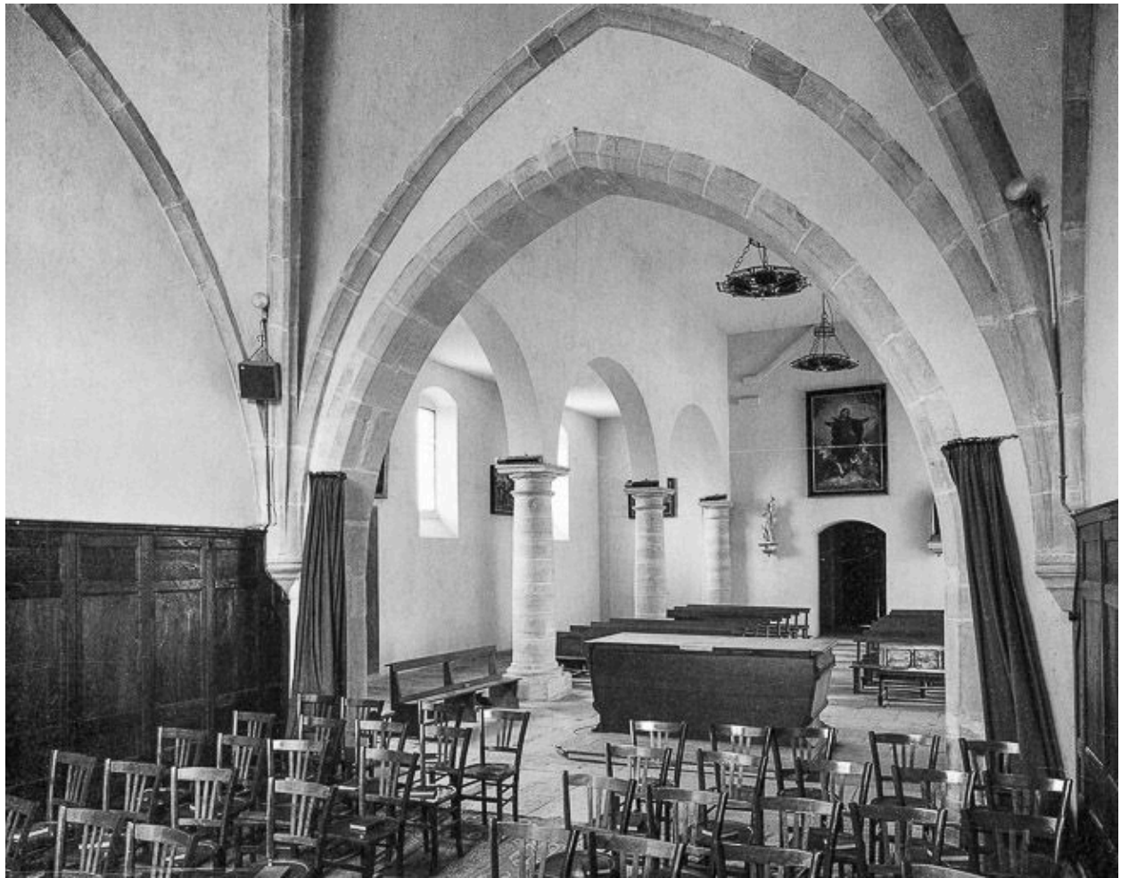
Intérieur : élévation droite de la nef.
