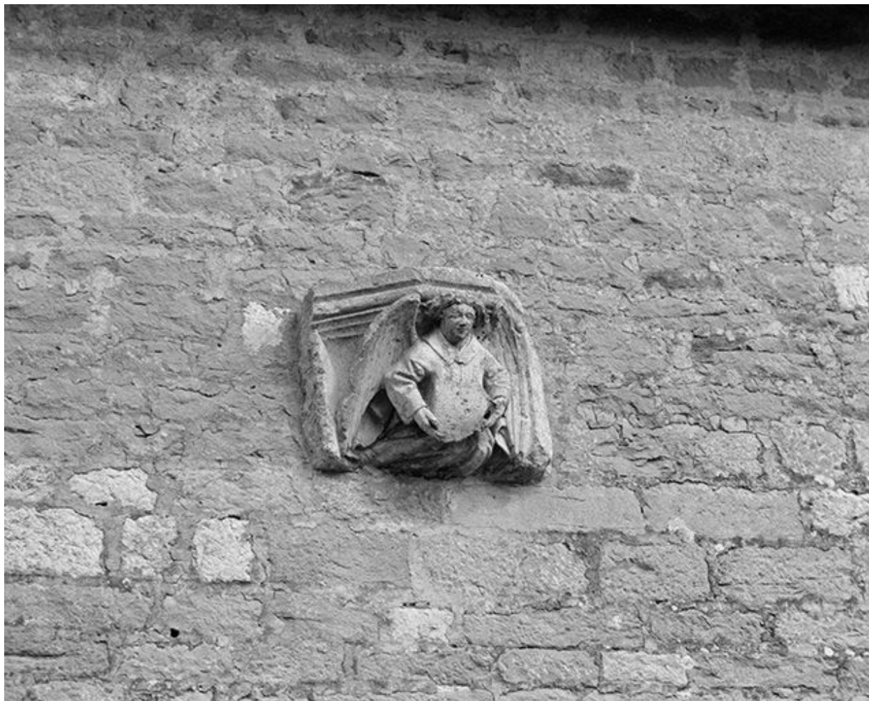
Façade antérieure : console droite.
