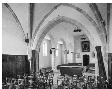
Intérieur : élévation droite de la nef. Phot. Yves Sancey IVR43_19843900148V
