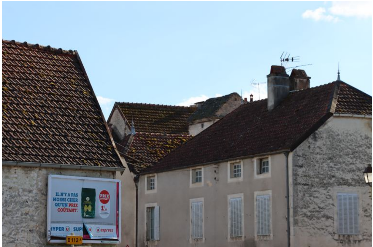
Vue éloignée de la toiture en laves de la tour d'escalier de la demeure
