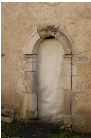
Détail de la porte du rez-de- chaussée de la tour d'escalier.
