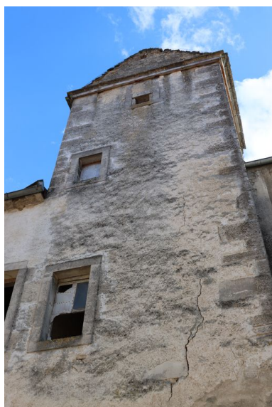
Vue de la tour d'escalier depuis le nord.
