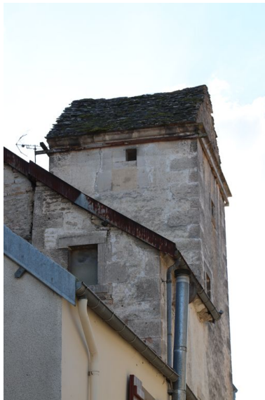
Vue de la tour d'escalier depuis l'ouest.
