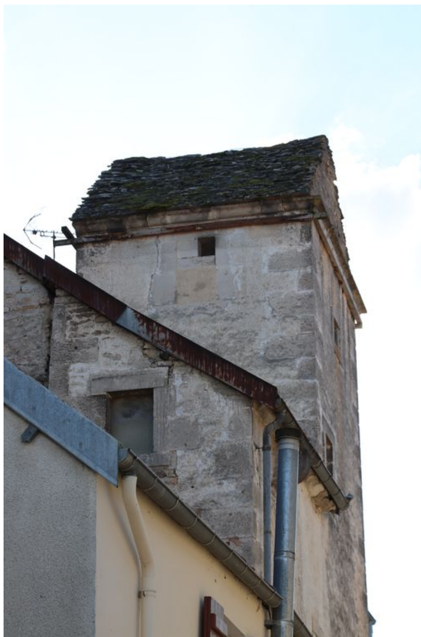
Vue de la tour d'escalier depuis l'ouest.
