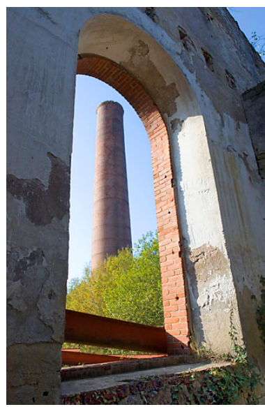
La cheminée vue depuis une ouverture du bâtiment des bureaux. Phot. Jérôme Mongreville IVR43_20077000590NUCA
