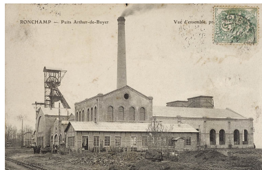
Ronchamp - Puits Arthur-de-Buyer - Vue d'ensemble [...]. Phot. Jérôme Mongreville IVR43_20057000636NUCA
