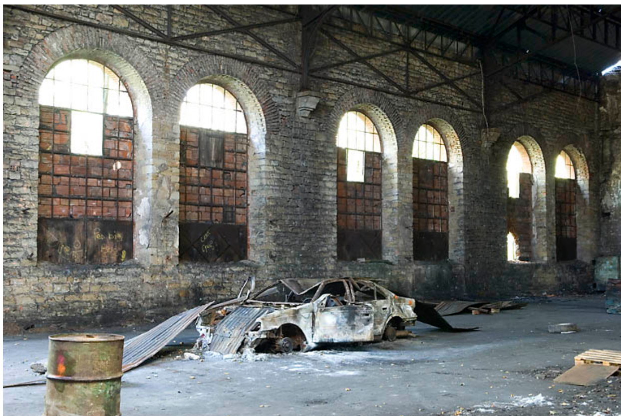
Mur nord du bâtiment des vestiaires.
