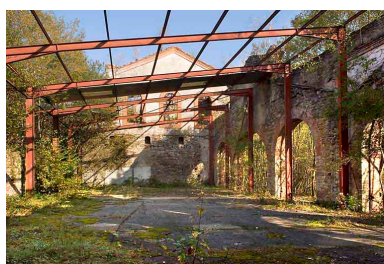
Salle des chaudières. Phot. Jérôme Mongreville IVR43_20077000586NUCA
