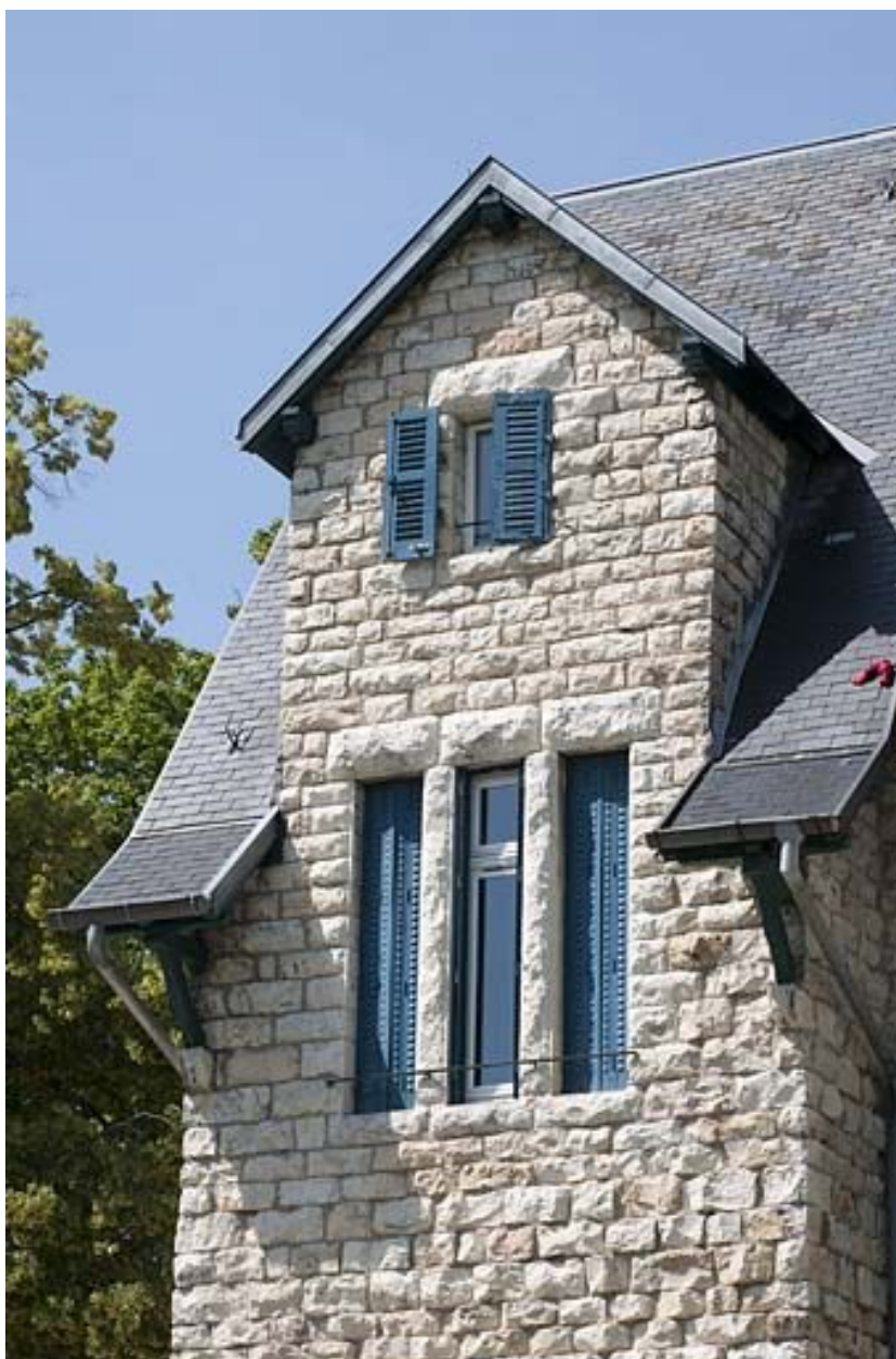
Façade postérieure. Pignon sud.
