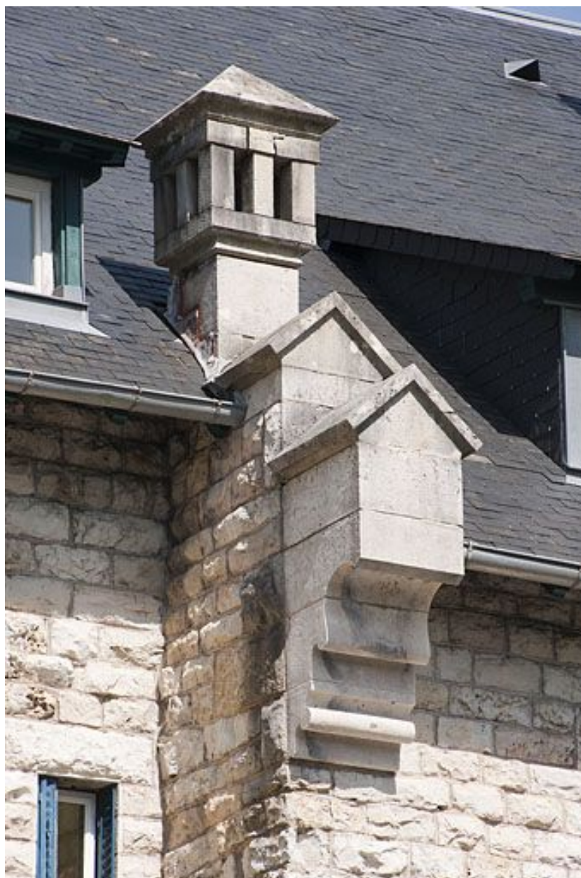
Façade antérieure. Détail d'une console.
