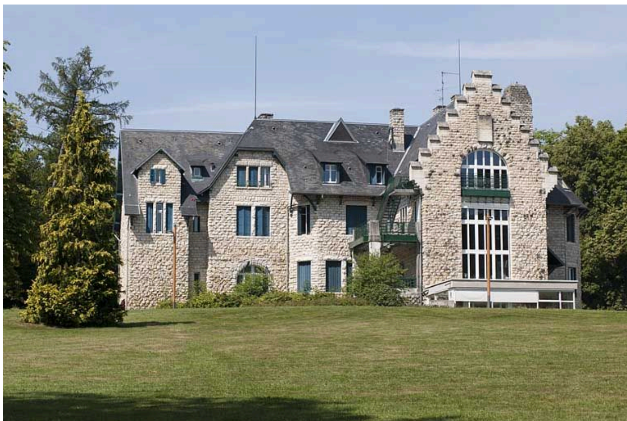
Façade postérieure depuis le sud-est.
