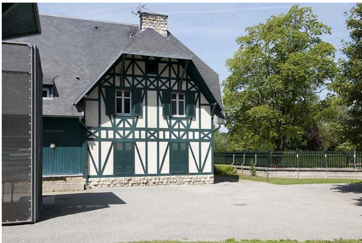
Conciergerie. Pignon nord de la façade postérieure.
