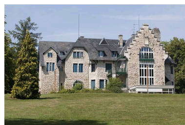
Façade postérieure depuis le sud-est.
