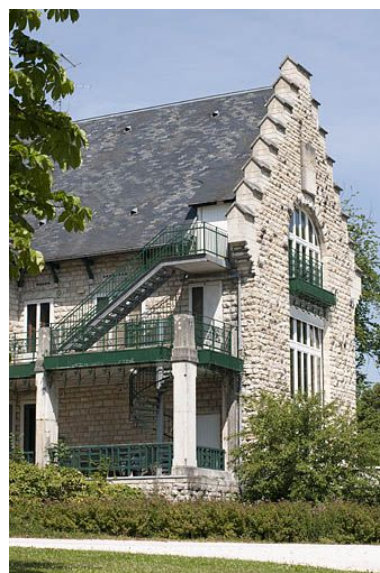
Façade postérieure. Pignon vu de trois quarts. Phot. Jérôme Mongreville IVR43_20112501493NUC4A
