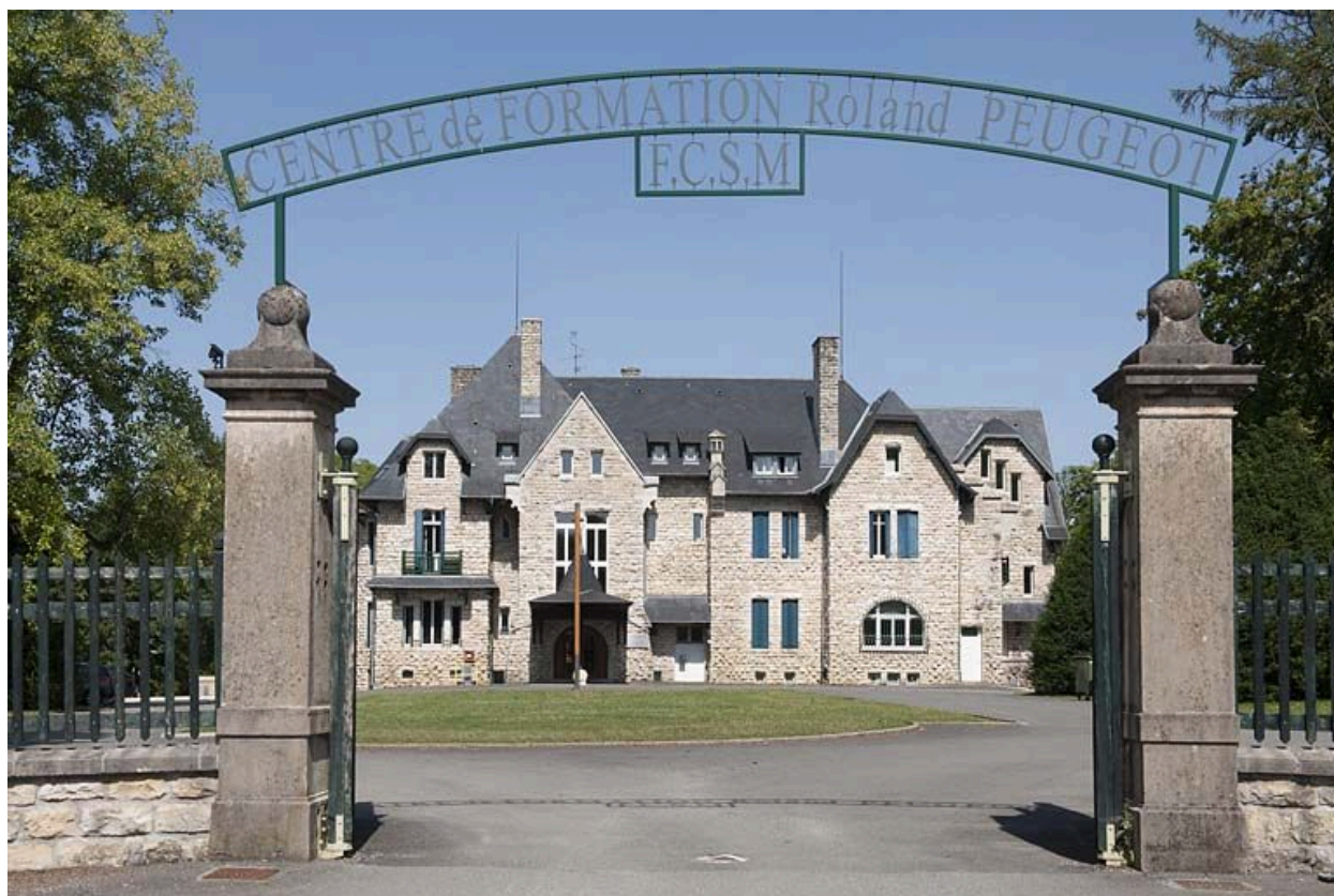
Vue rapprochée depuis l'entrée.
