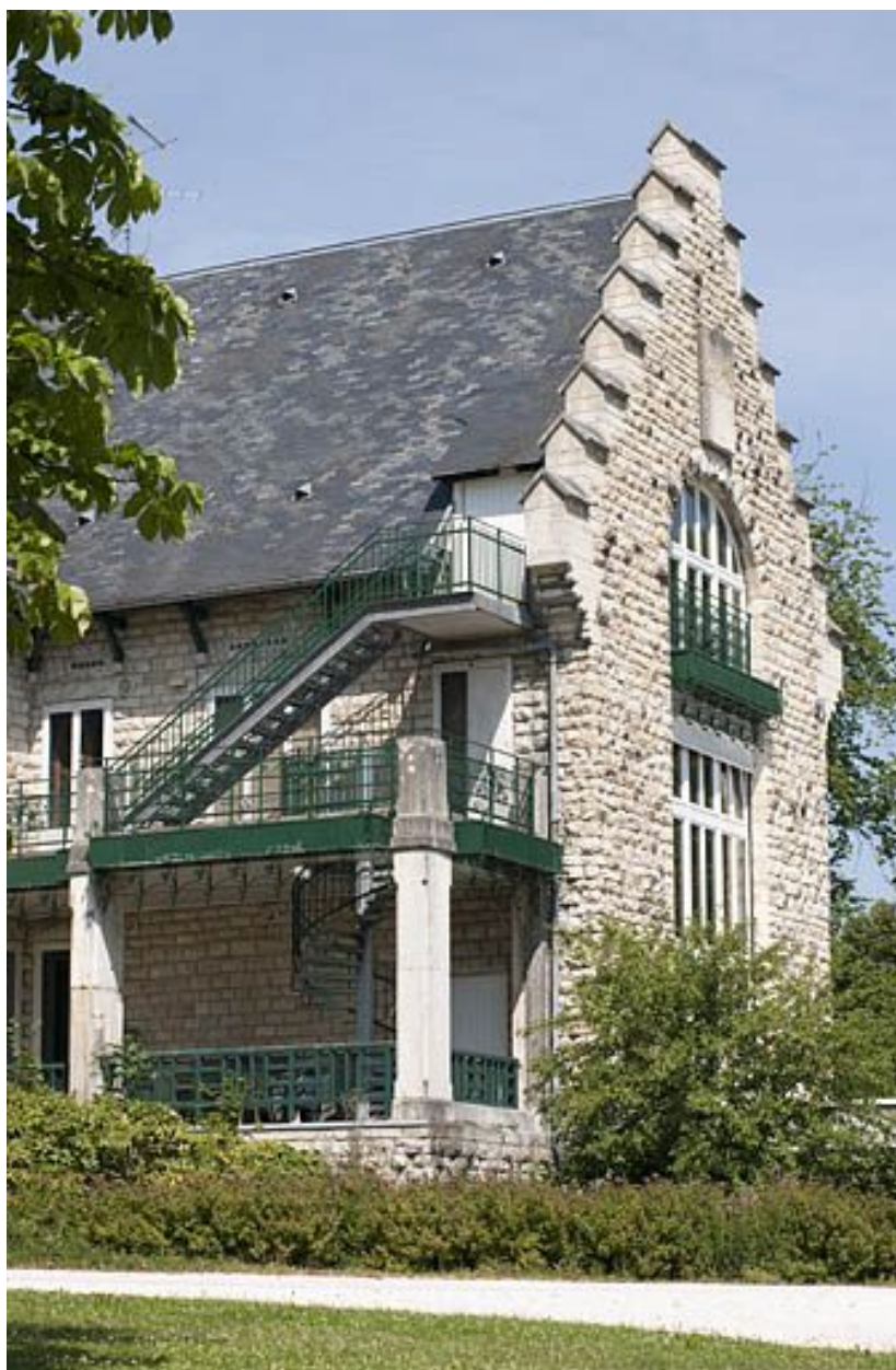
Façade postérieure. Pignon vu de trois quarts.
