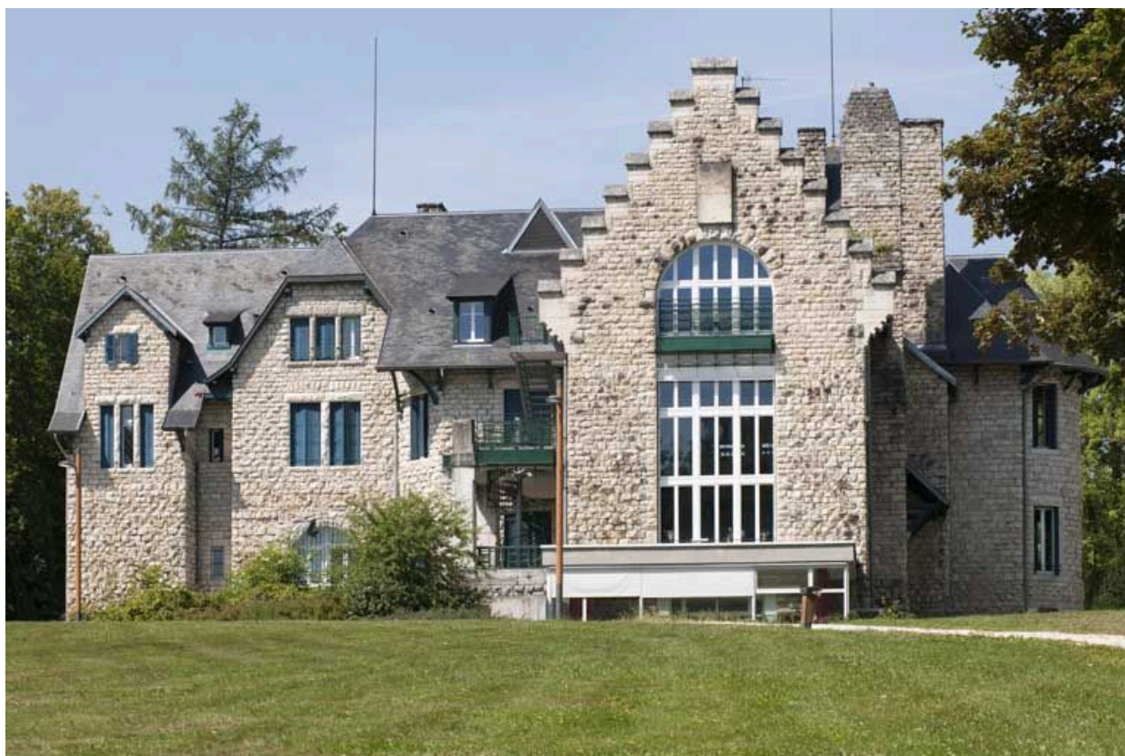
Façade postérieure depuis l'est.
