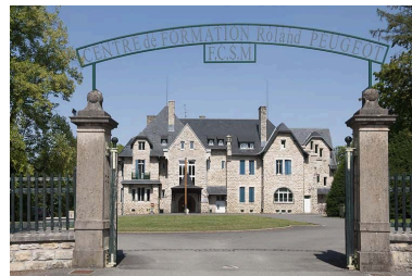
Vue rapprochée depuis l'entrée.
