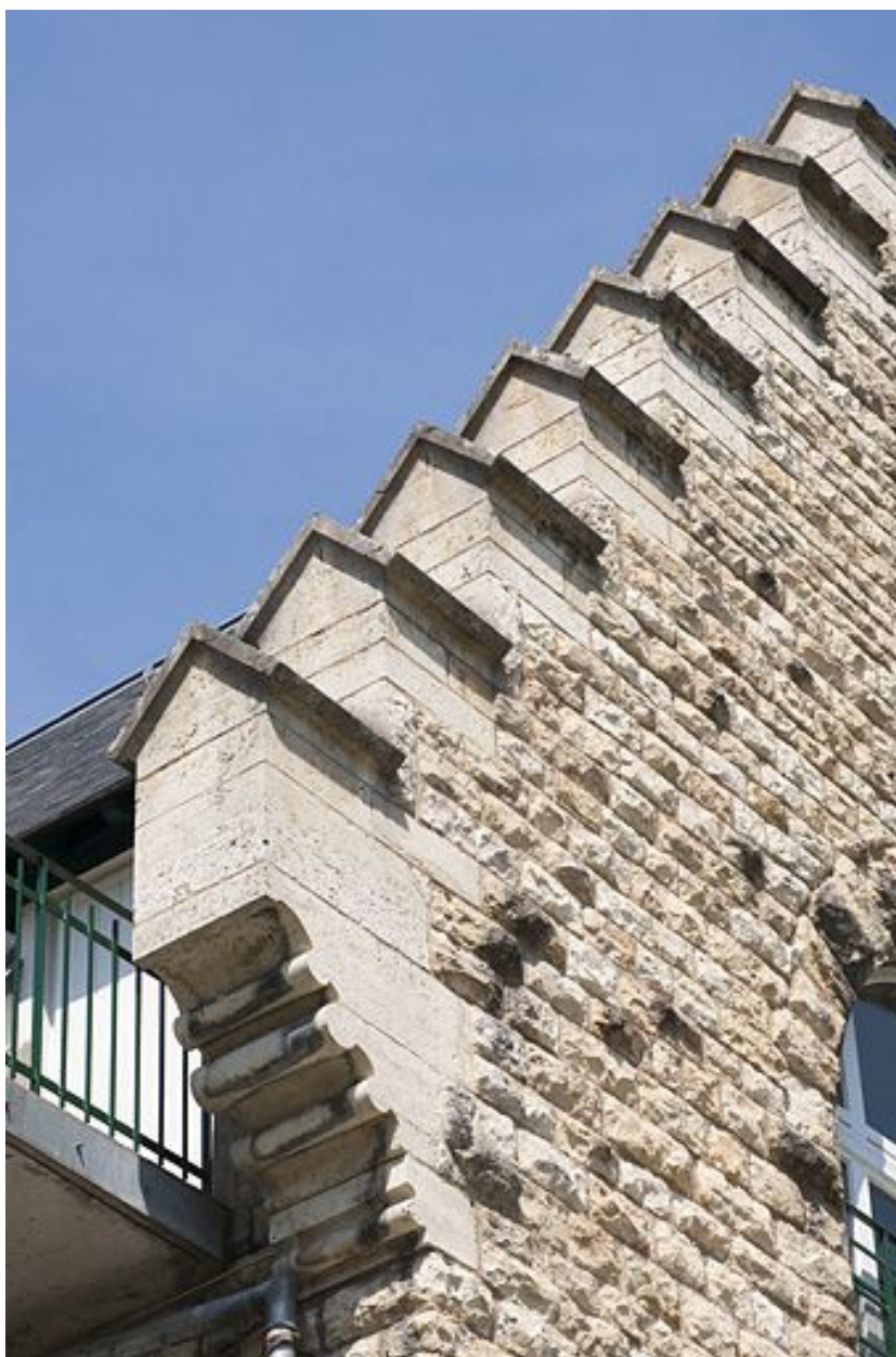
Façade postérieure. Détail des redents du pignon.
