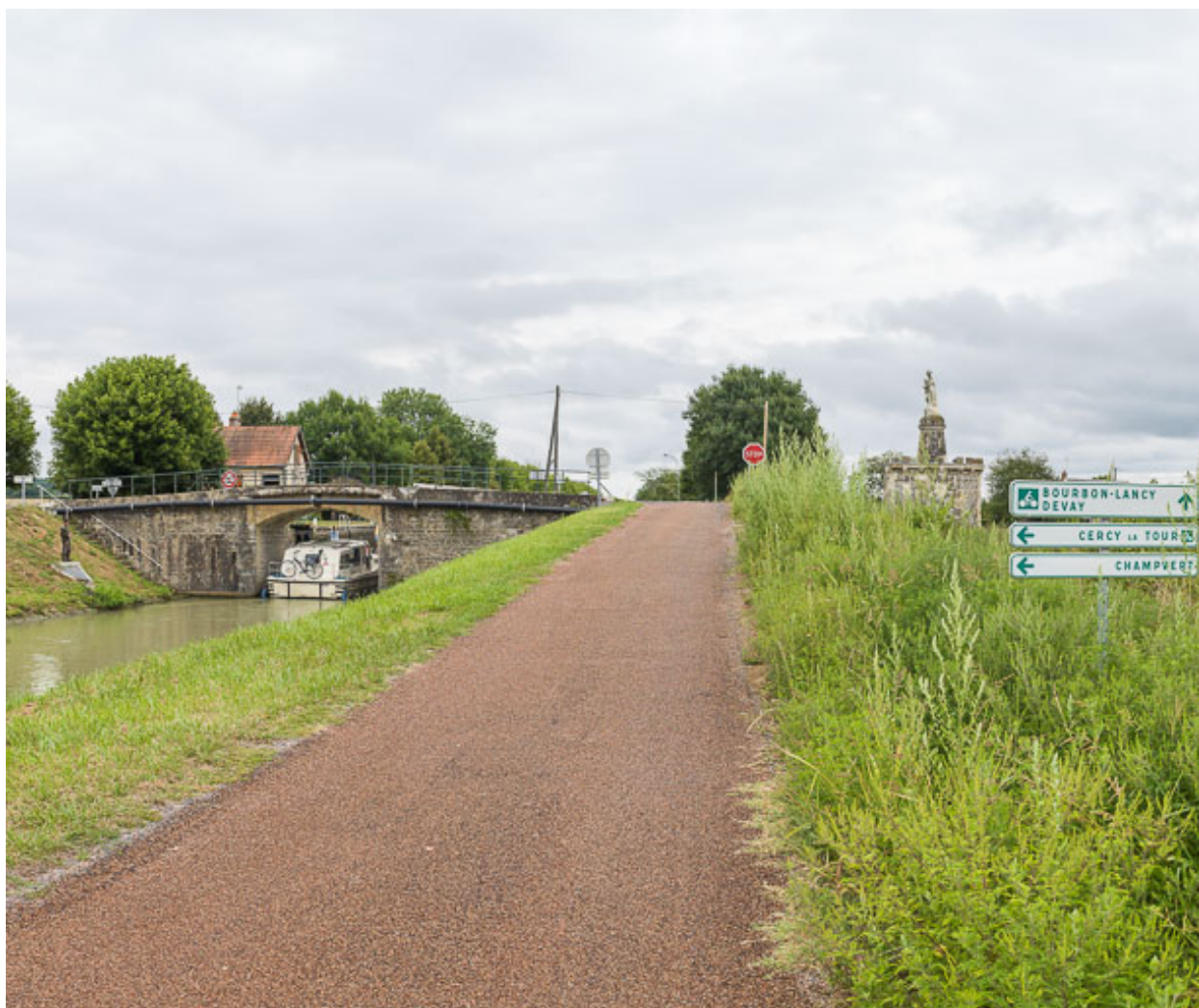
Vue du pont et du site.
