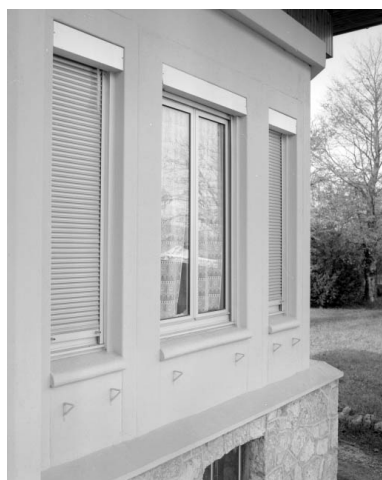
Façade antérieure : fenêtres du renforcement à droite. Phot. Yves Sancey IVR43_19943901603X
