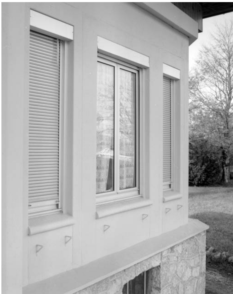
Façade antérieure : fenêtres du renforcement à droite.
