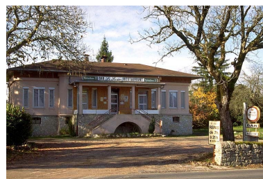
Vue d'ensemble. Phot. Yves Sancey IVR43_19943901596ZA
