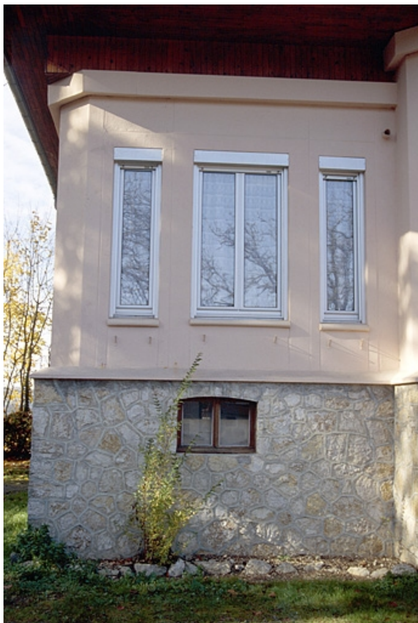
Façade antérieure : fenêtres du renforcement à gauche.
