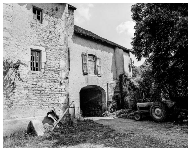
Porche d'entrée, élévation sur la cour. Phot. Dominique Dominguez IVR43_19773900037X
