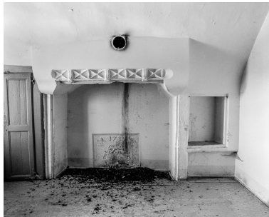
Corps de logis, cheminée. Phot. Dominique Dominguez IVR43_19773900044X
