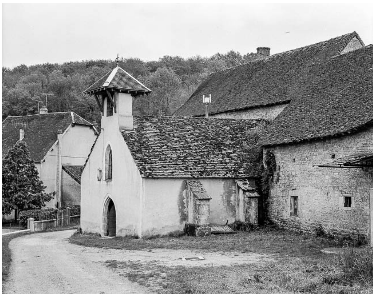
La chapelle, façade antérieure et face droite.
