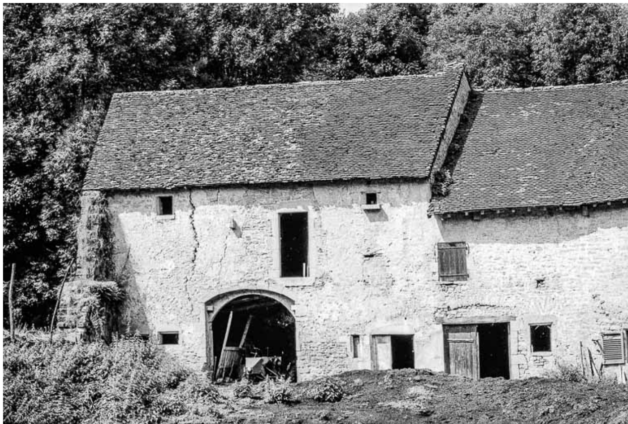
Partie agricole : façade sur cour.
