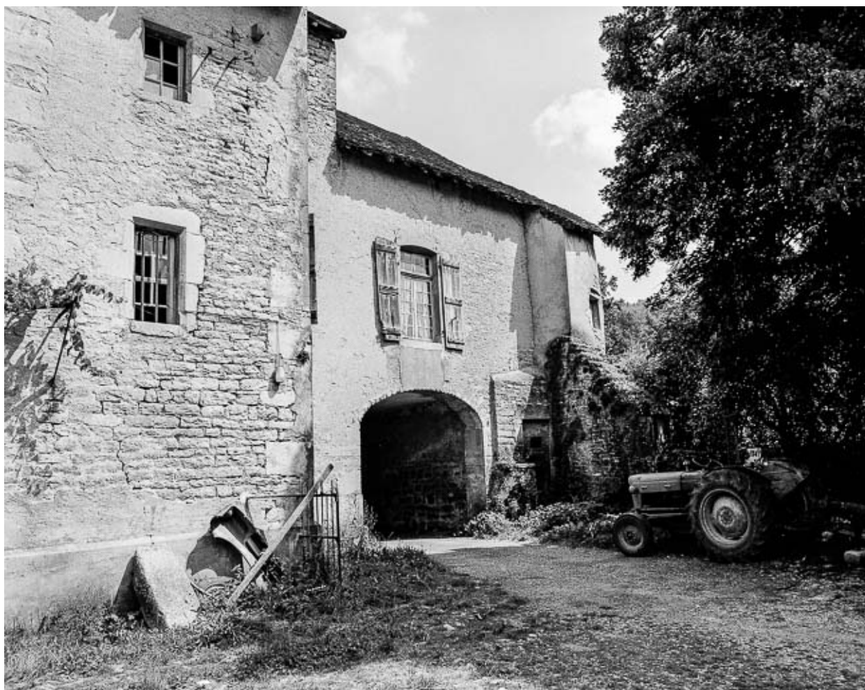
Porche d'entrée, élévation sur la cour.
