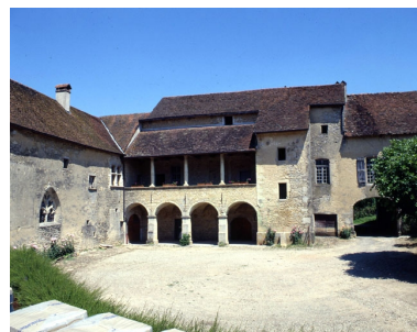
Galleries de la cour intérieure. Phot. Yves Sancey IVR43_19903901162XA
