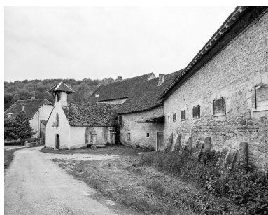
Chapelle et partie agricole : façade sur rue. Phot. Dominique Dominguez IVR43_19773900027X
