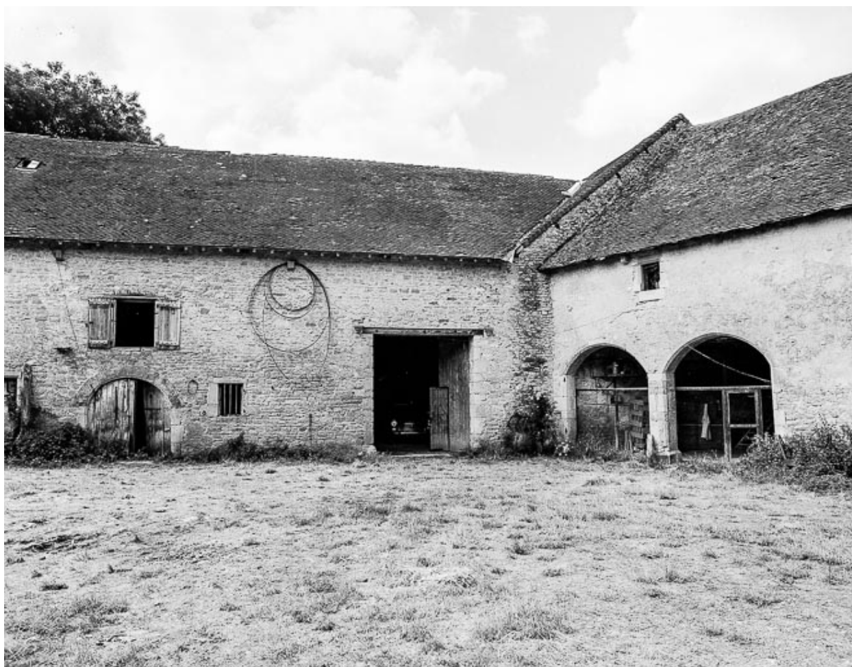
Partie agricole : façade sur cour.
