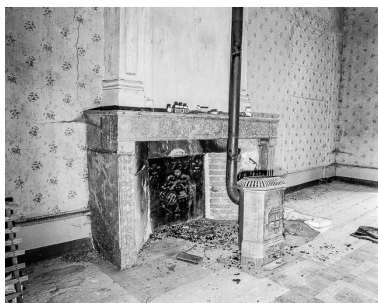
Corps de logis, cheminée. Phot. Dominique Dominguez IVR43_19773900043X
