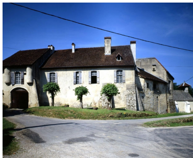
Façade antérieure. Phot. Yves Sancey IVR43_19903901160VA
