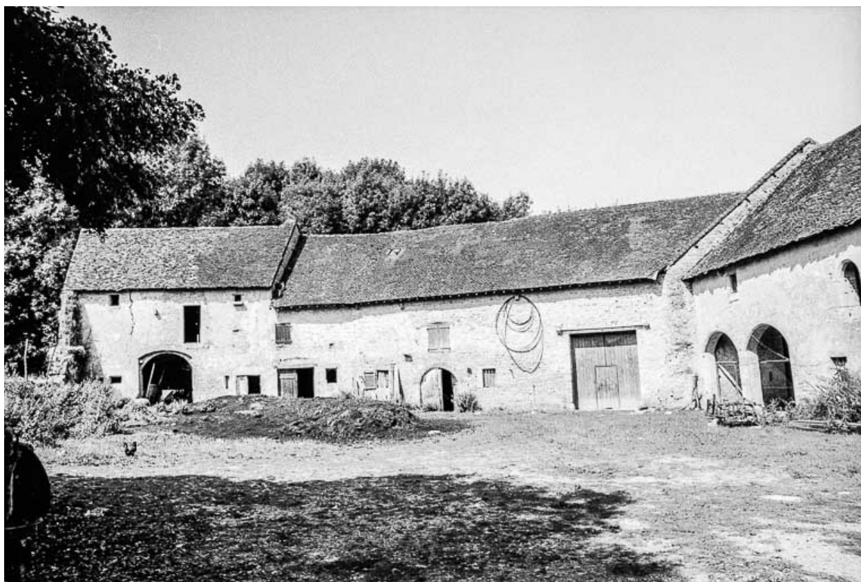
Partie agricole : façade sur cour.
