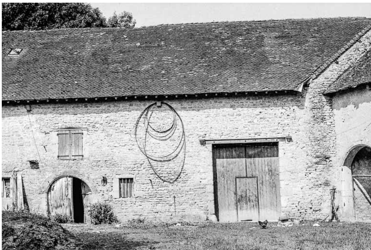
Partie agricole : façade sur cour.
