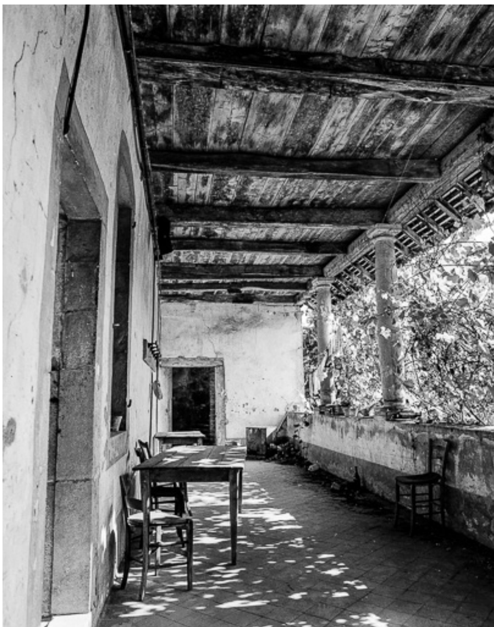
Corps de logis, étage de la galerie.
