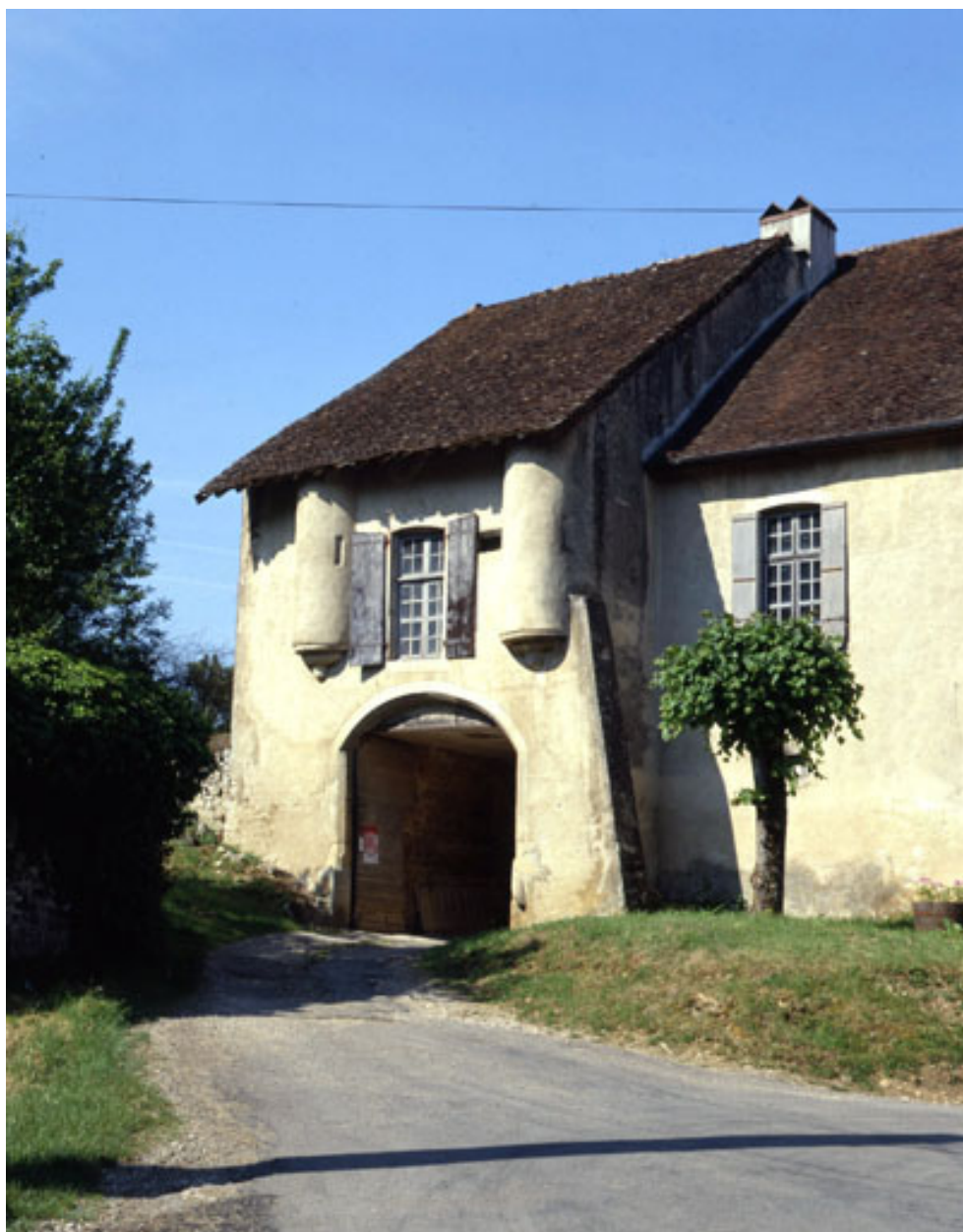
Bâtiment d'entrée : porche et façade latérale gauche.
