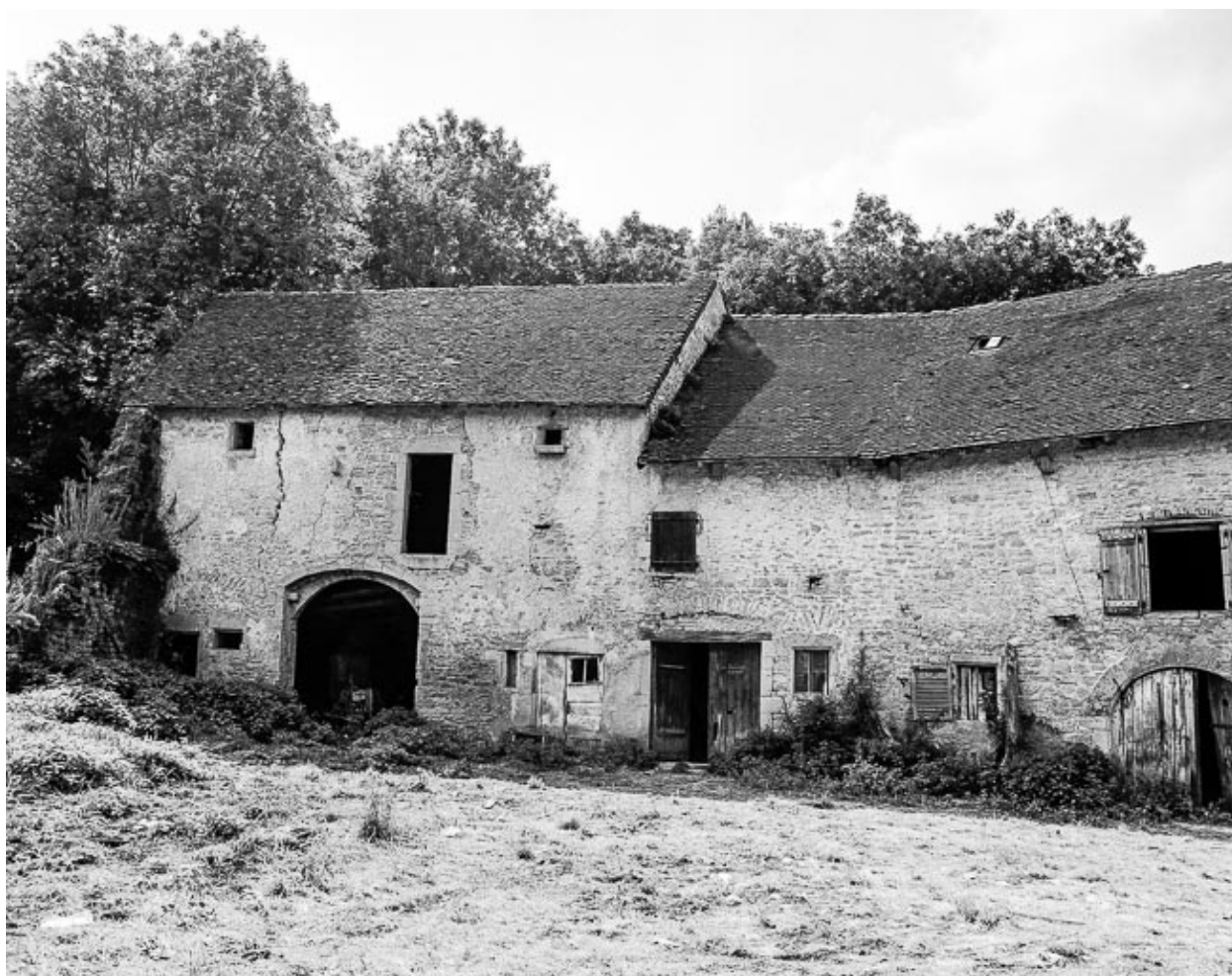
Partie agricole : façade sur cour.
