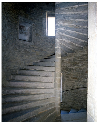
Escalier en vis de la tourelle. Phot. Yves Sancey IVR43_19903901164XA
