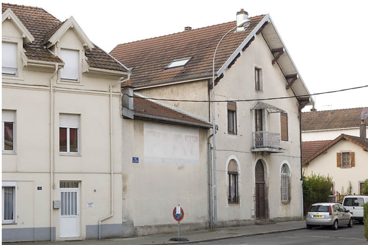
Logement patronal. Vue de trois quarts.
