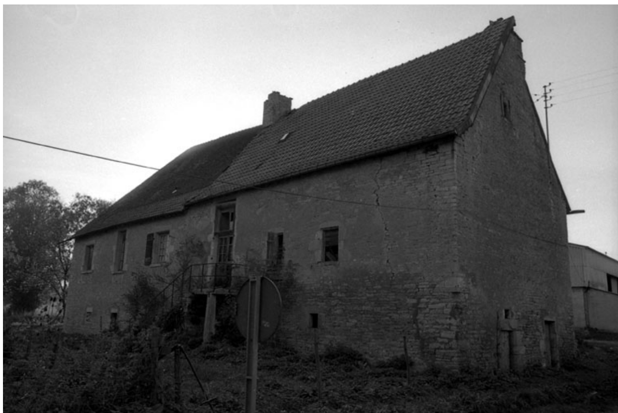
Partie agricole : façade postérieure.
