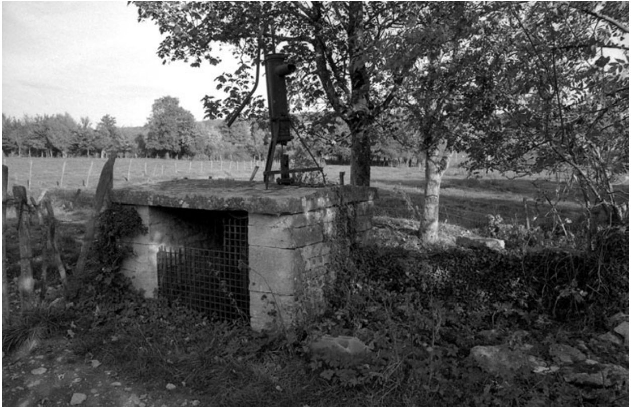
Vue du puits.
