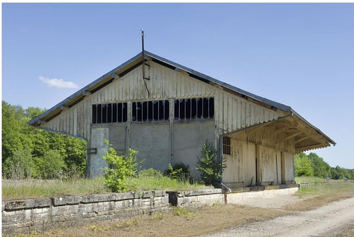
Gare des marchandises vue de trois-quarts.
