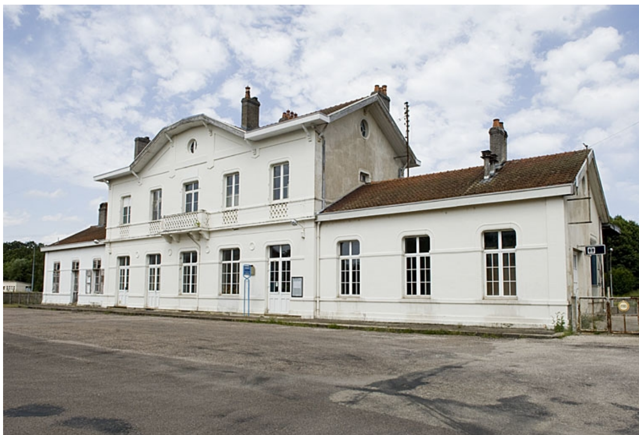
Bâtiment des voyageurs : vue générale depuis l'esplanade.
