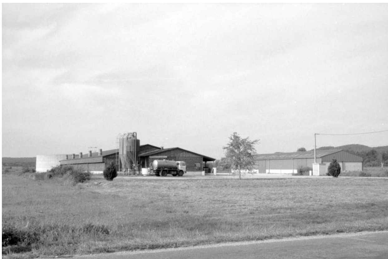
Porcherie et cave d'affinage vues du sud-ouest.
