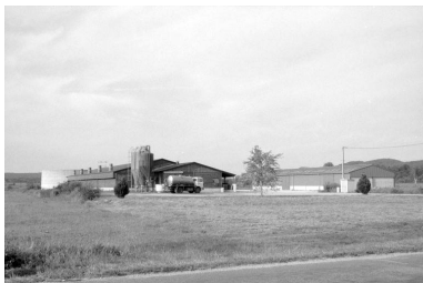
Porcherie et cave d'affinage vues du sud-ouest. Phot. Laurent Poupard IVR43_19923901310Z
