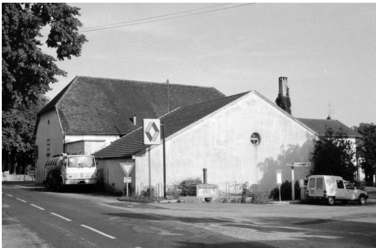
Fromagerie et pièce d'affinage vues du nord-ouest.
