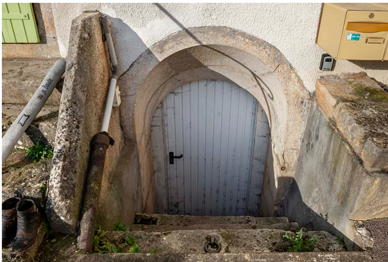
Escalier extérieur menant à la cave.
