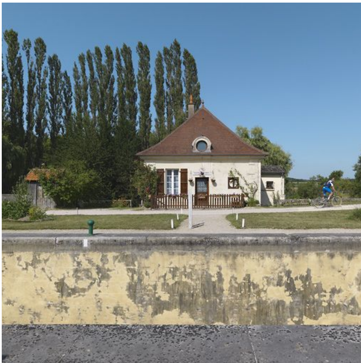
La maison éclusière vue de face.
