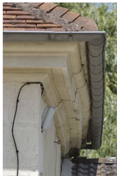
Détail de maçonnerie : la corniche en pierre de taille. Phot. Thierry Kuntz IVR26_20112103214NUC2A
