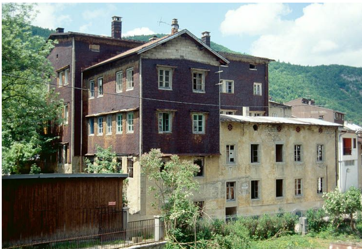
Bâtiment 6-8 rue Victor Poupin : façade postérieure.
