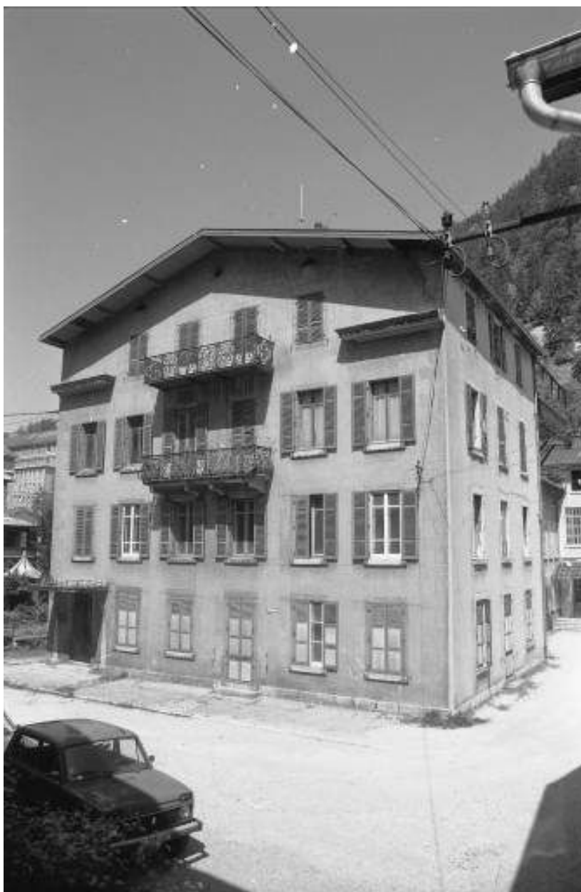
Logement patronal et anciens bureaux (1892) : façade antérieure.
