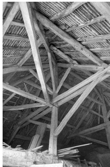
Charpente de la dépendance. Phot. Laurent Poupard IVR43_19923901333Z
