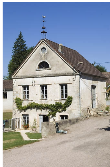
Bâtiment d'eau vu de trois quarts droite. Phot. Jérôme Mongreville IVR43_20087000618NUC2A
