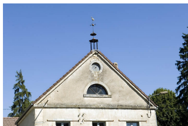
Fronton du bâtiment d'eau. Phot. Jérôme Mongreville IVR43_20087000617NUC2A
