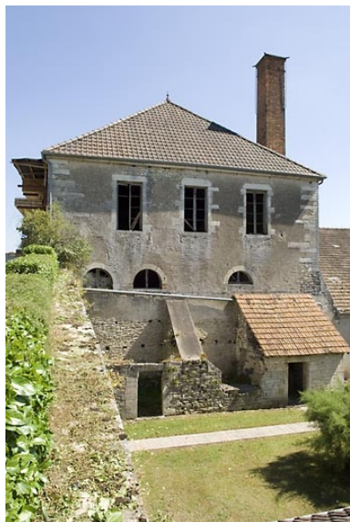
Façade nord-ouest du haut fourneau. Phot. Jérôme Mongreville IVR43_20087000620NUC2A
