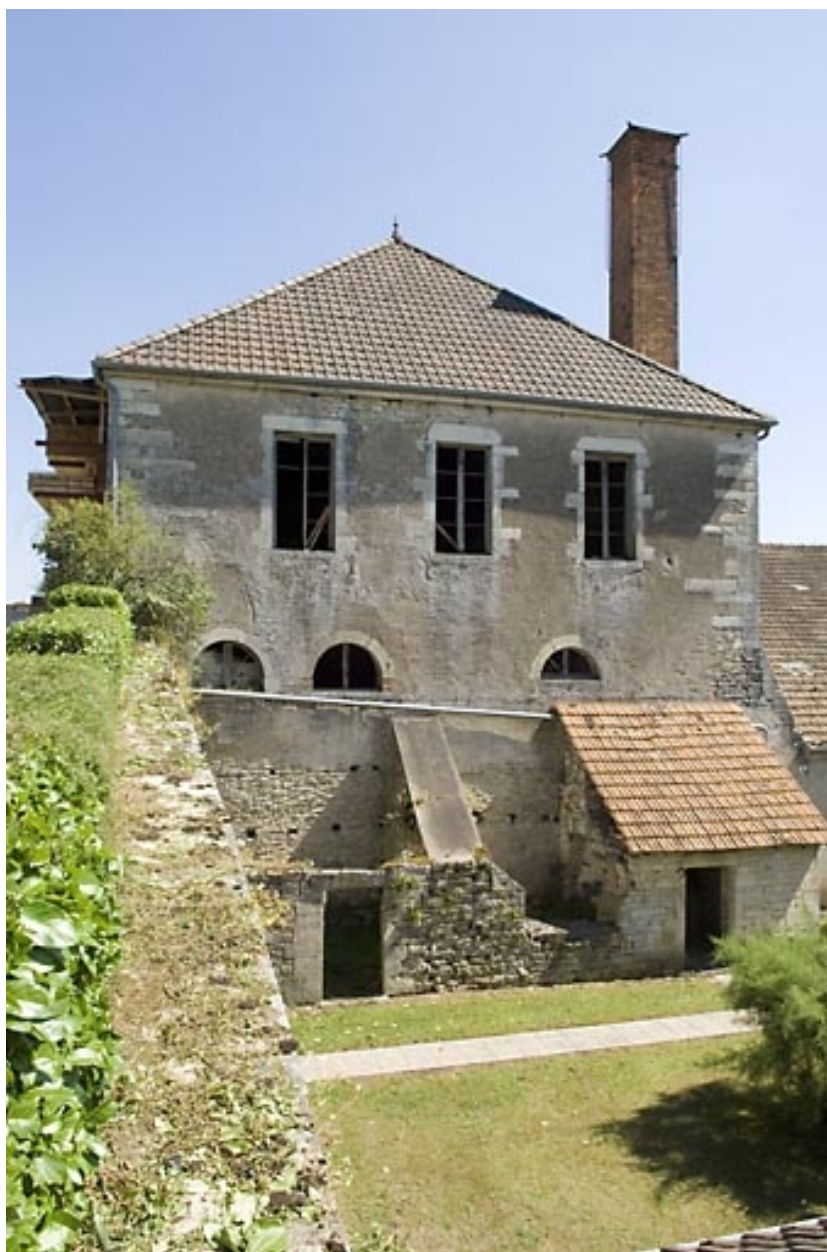
Façade nord-ouest du haut fourneau.
