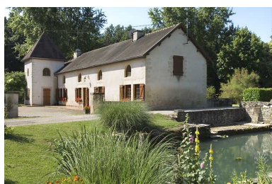
Logement ouvrier sud. Phot. Jérôme Mongreville IVR43_20087000619NUC2A
