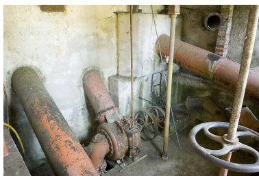
Intérieur du bâtiment d'eau. Phot. Jérôme Mongreville IVR43_20087000627NUC2A
