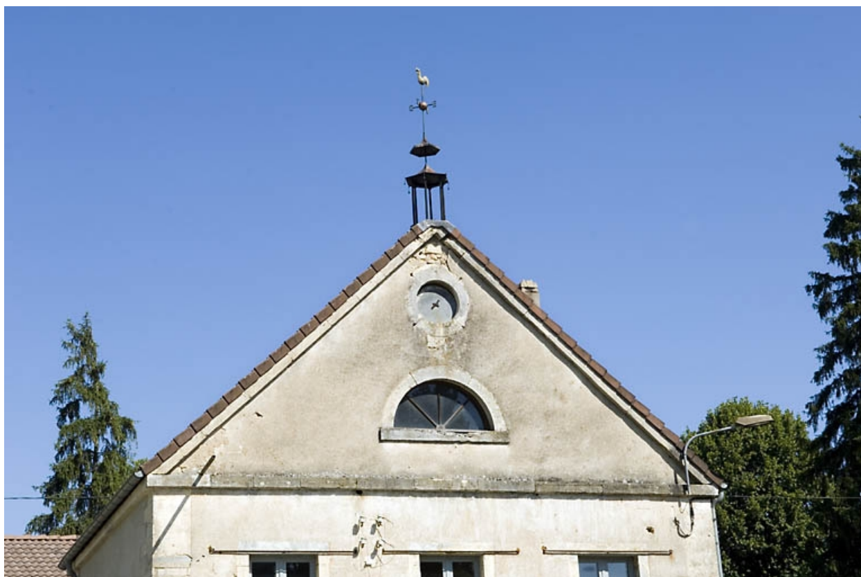
Fronton du bâtiment d'eau.
