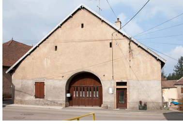
Façade antérieure. Phot. Jérôme Mongreville IVR43_20102500381NUC4A
