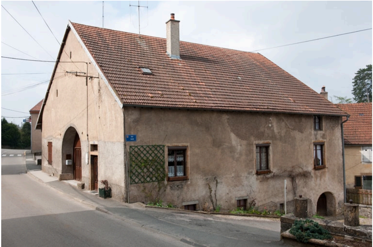
Façade antérieure et façade latérale droite.
