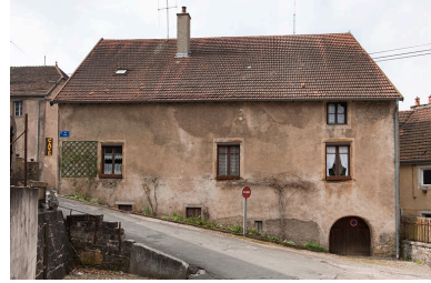
Façade latérale droite. Phot. Jérôme Mongreville IVR43_20102500379NUC4A
