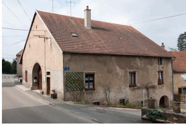
Façade antérieure et façade latérale droite. Phot. Jérôme Mongreville IVR43_20102500380NUC4A
