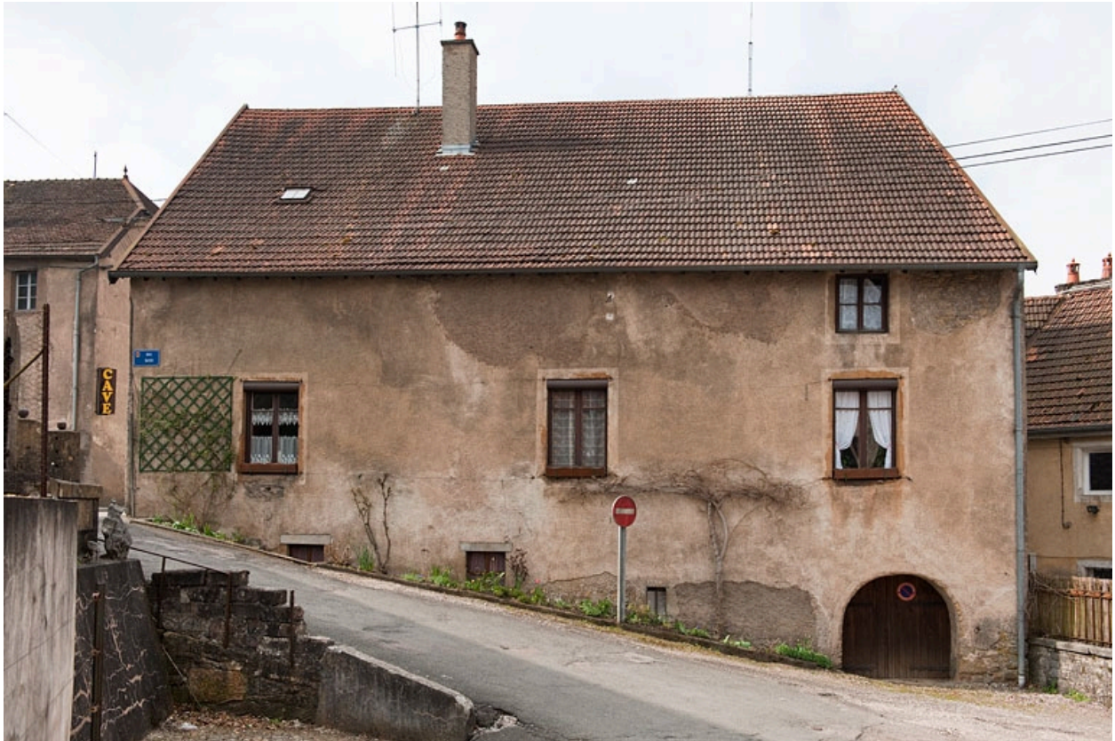
Façade latérale droite.
