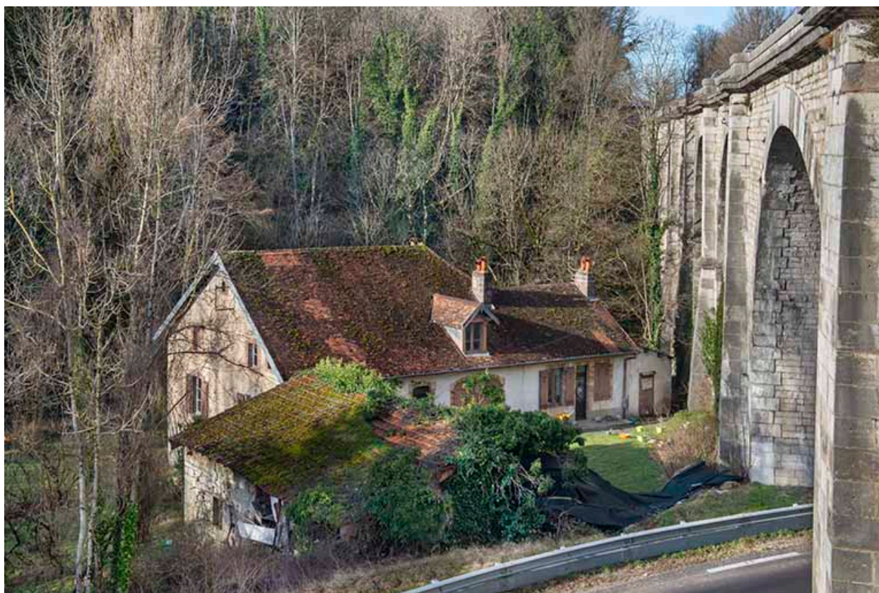
Maison au pied du viaduc, depuis l'est.
