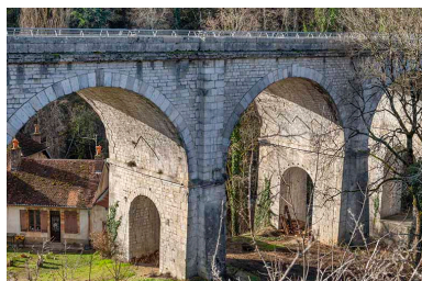
Vue sur les arches, depuis le nord-est. Phot. Jérôme Mongreville IVR43_20243900020NUC4A
