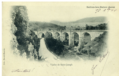
Salins-les-Bains (Jura) - Viaduc de Saint-Joseph, s.d. [fin 19e siècle]. Phot. auteur inconnu IVR43_20243900209NUC4A
