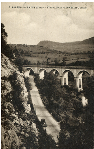
Salins-les-Bains (Jura) - Viaduc de la vallée de Saint-Joseph, s.d. [début 20e siècle]. Phot. G. Karrer IVR43_20243900205NUC4A
