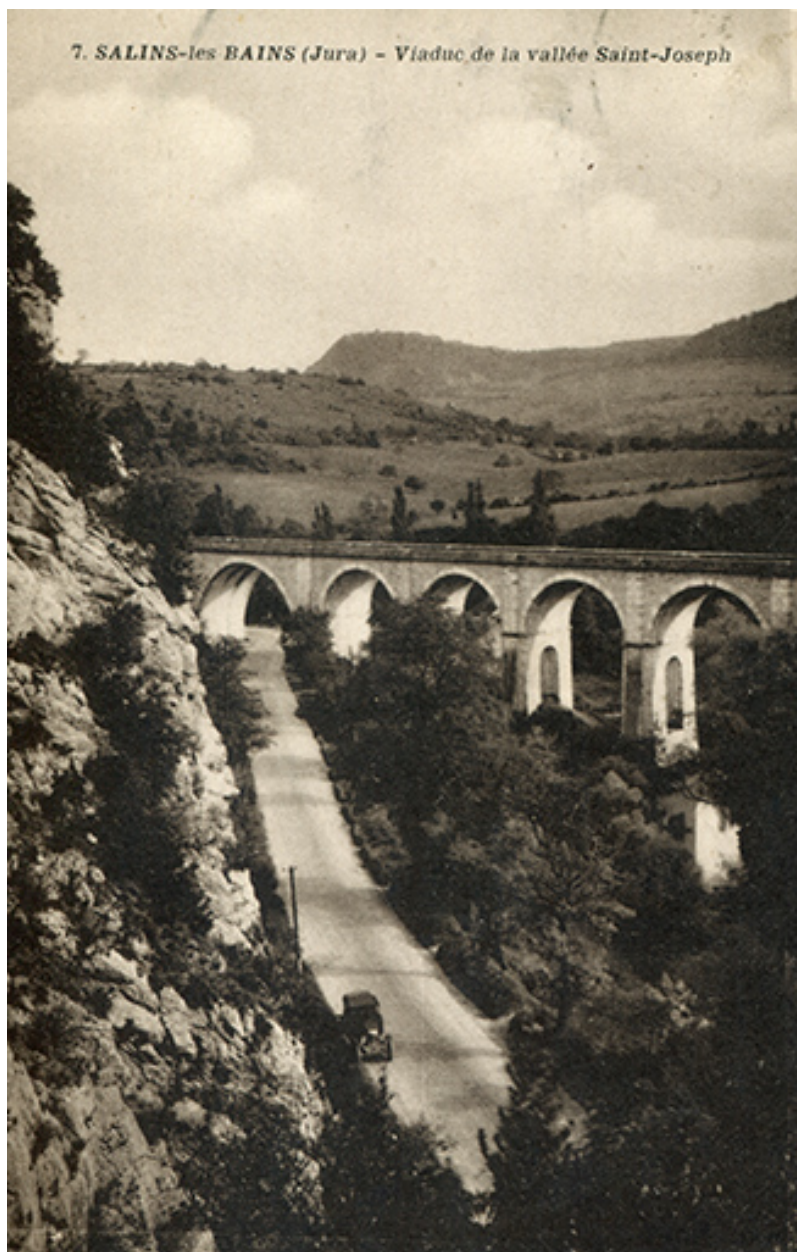
Salins-les-Bains (Jura) - Viaduc de la vallée de Saint-Joseph, s.d. [début 20e siècle].
