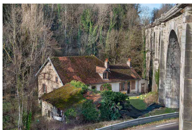
Maison au pied du viaduc, depuis l'est. Phot. Jérôme Mongreville IVR43_20243900013NUC4A
