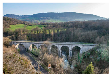
Vue d'ensemble, depuis le nord-ouest. Phot. Jérôme Mongreville IVR43_20243900590NUC4A
