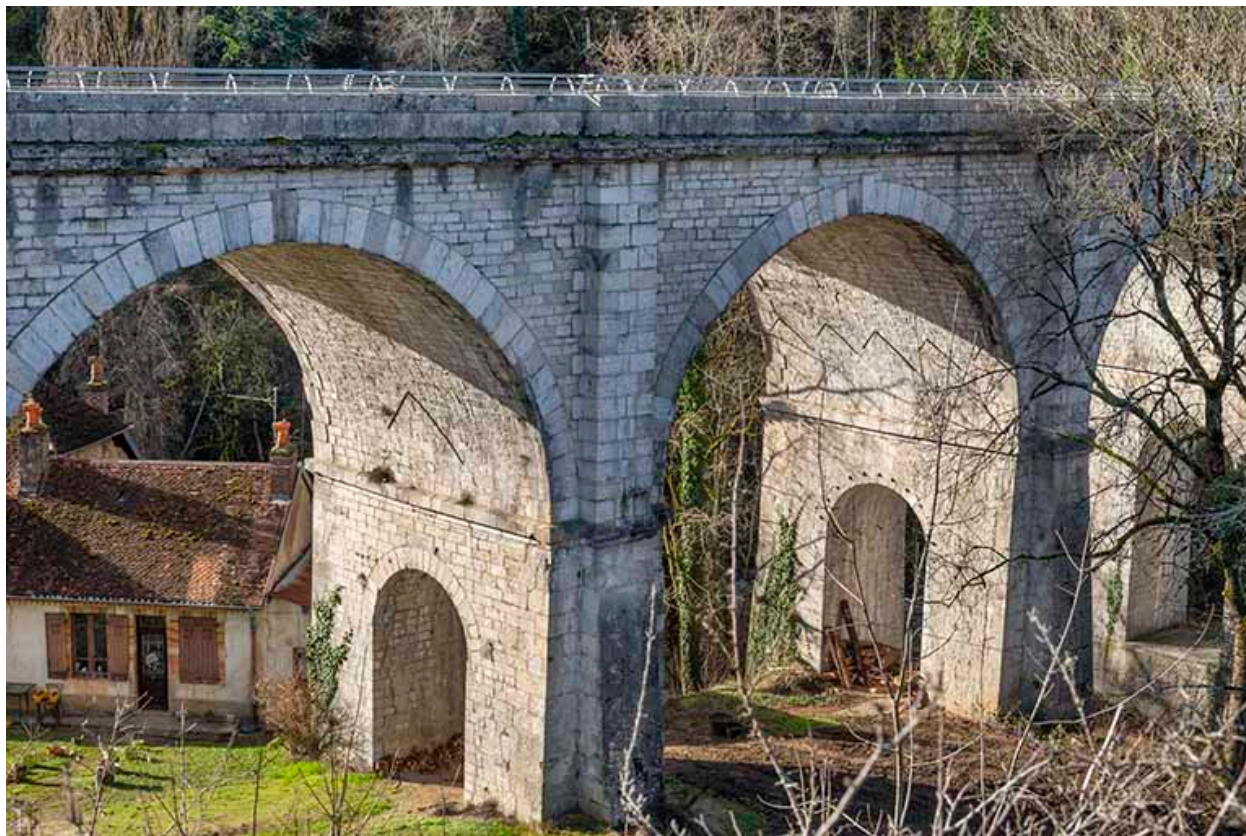
Vue sur les arches, depuis le nord-est.
