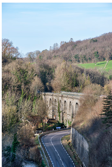
Vue d'ensemble, depuis l'est. Phot. Jérôme Mongreville IVR43_20243900010NUC4A
