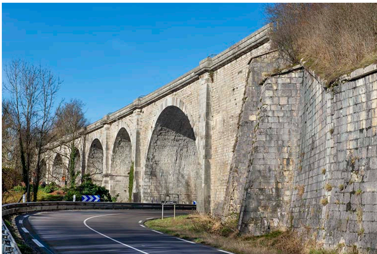
Vue depuis la route départementale, à l'est.
