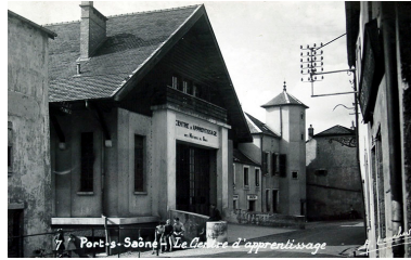
Le centre d'apprentissage, carte postale. Autr. auteur inconnu IVR43_20177000960NUC1A
