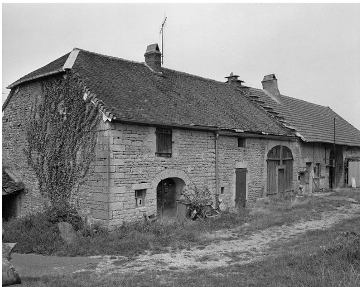
Frébuans : ferme située rue du Château d'Eau.
