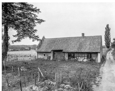
Condamine : ferme située au lieudit Les Piés. Phot. Yves Sancey IVR43_19843900033X
