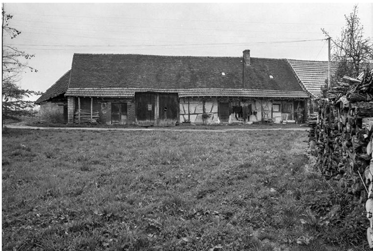
Courlaoux : ferme située au lieudit Chartay.
