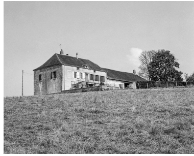
Saint-Didier : ferme de vigneron située chemin de Montard. Phot. Yves Sancey IVR43_19843900296X
