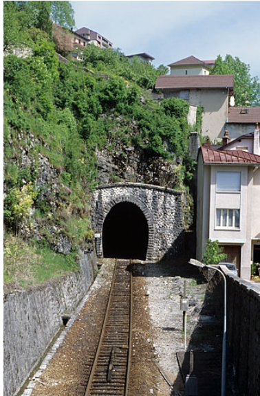
Tête côté La Cluse (sud). Phot. Yves Sancey IVR43_20053900736ZA
