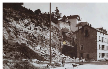
[Création de la plate-forme de la voie à la tête du tunnel côté La Cluse], entre août 1908 et avril 1911.
