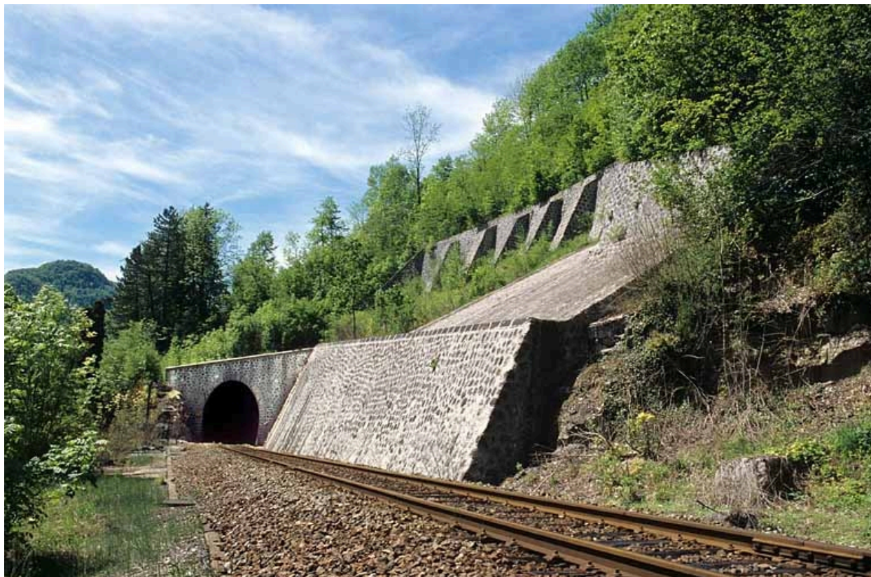
Vue d'ensemble, depuis le nord : murs de soutènement et tête côté Andelot-en-Montagne.
