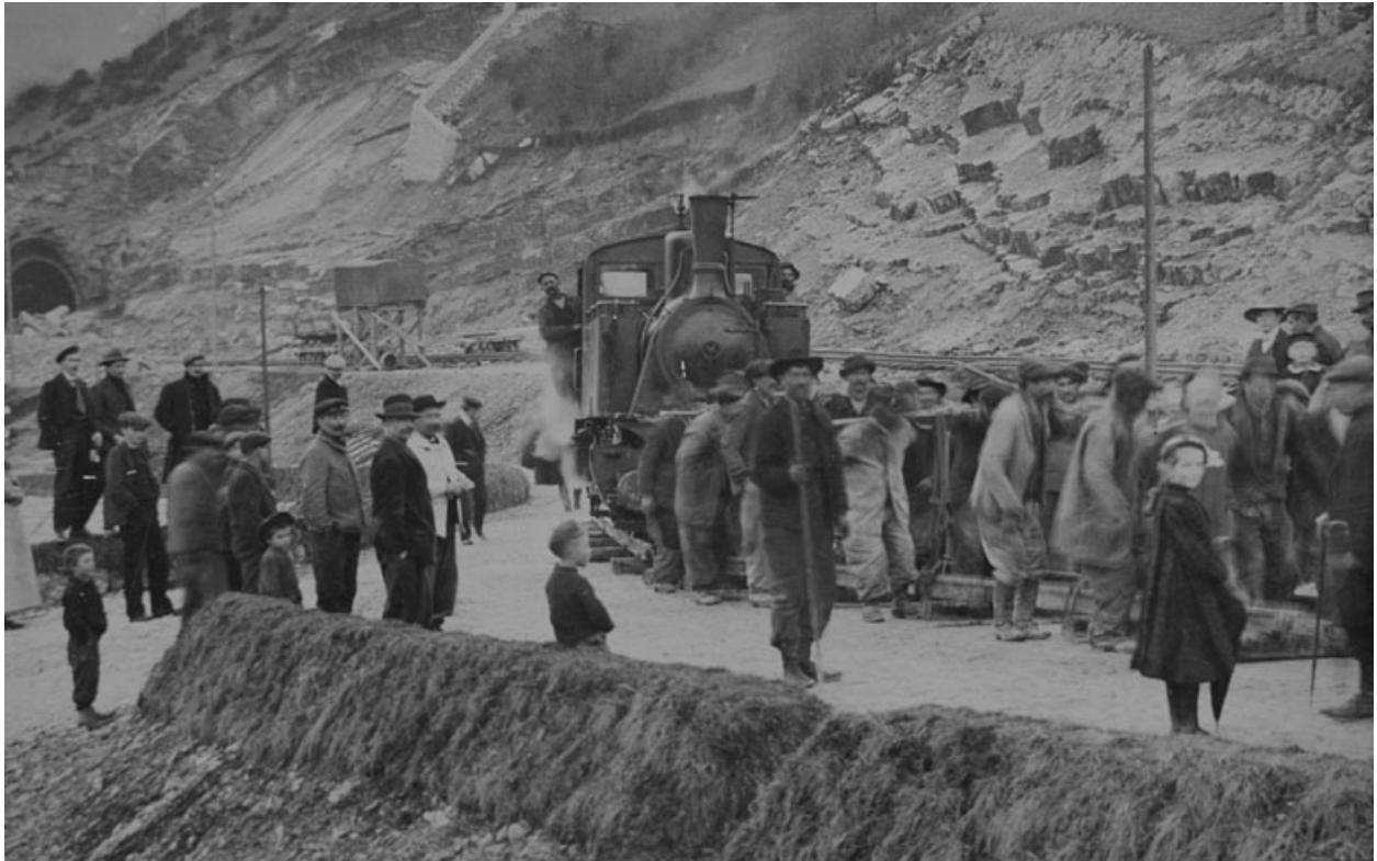
[Pose d'une voie provisoire côté Andelot-en-Montagne], 1912.
