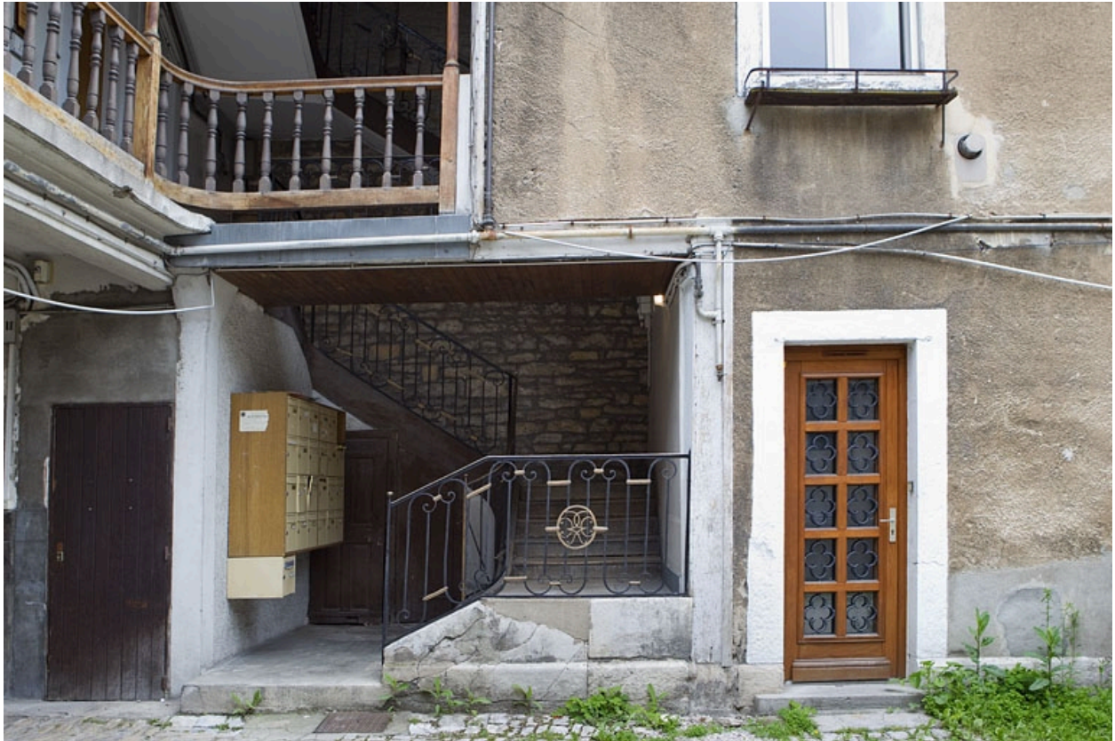
Détail du départ de l'escalier principal.
