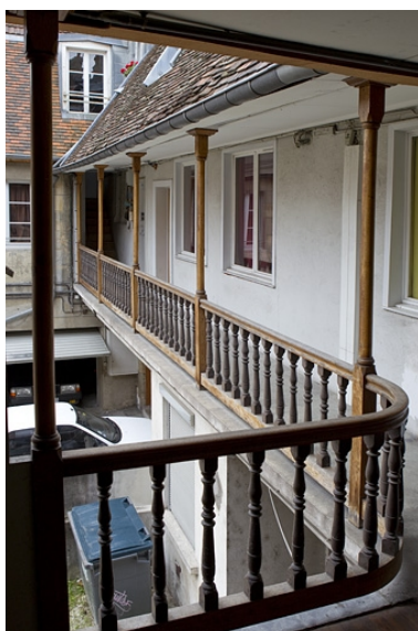
Détail de galerie sur cour du logis principal depuis le haut de l'escalier. Phot. Yves Sancey IVR43_20102500777NUC2A
