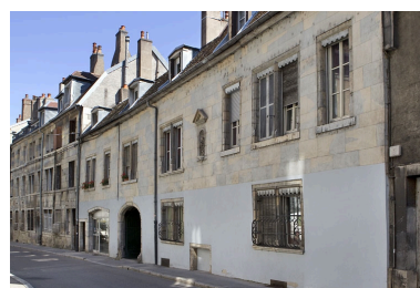
Vue d'ensemble du logis principal depuis la rue, de trois quarts droit.
