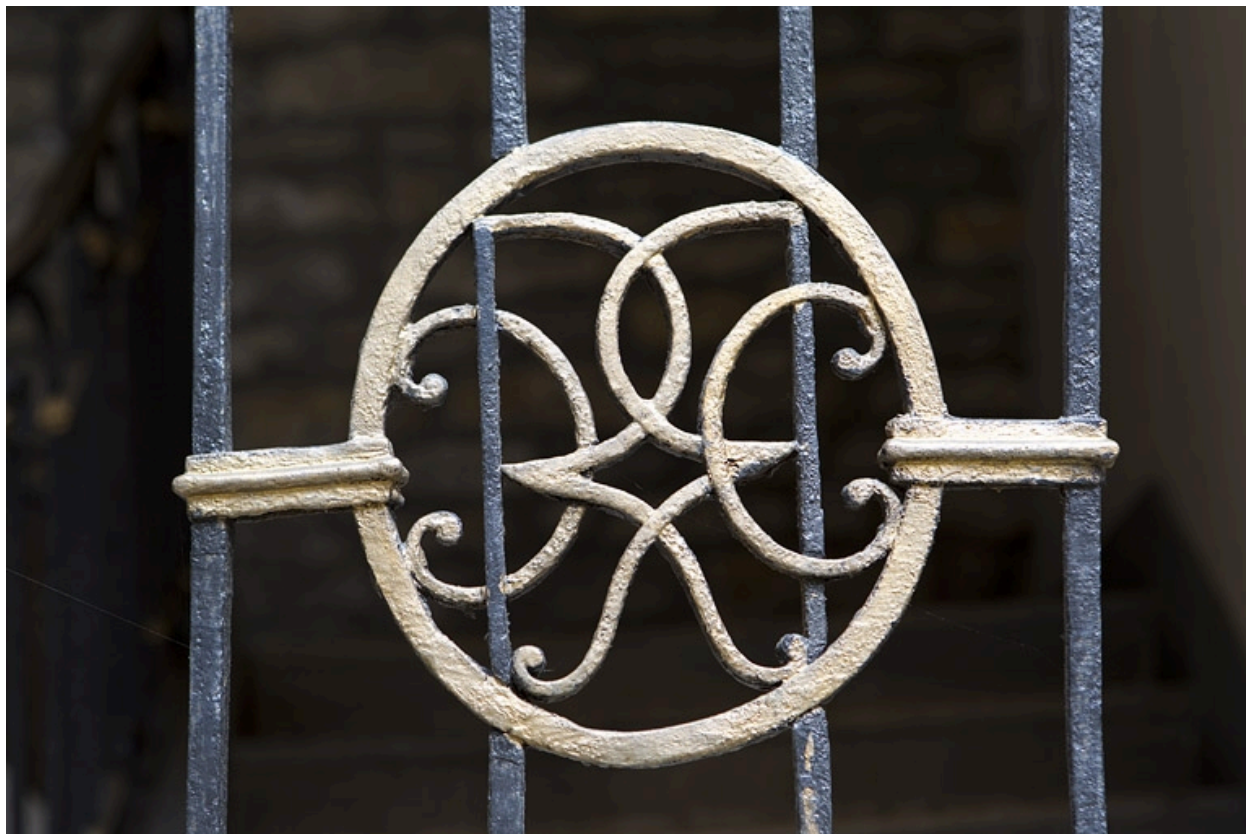
Détail du médaillon en ferronnerie de la rampe de l'escalier principal.
