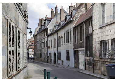
Vue d'ensemble du logis principal dans l'alignement de la rue de trois quarts droit.
