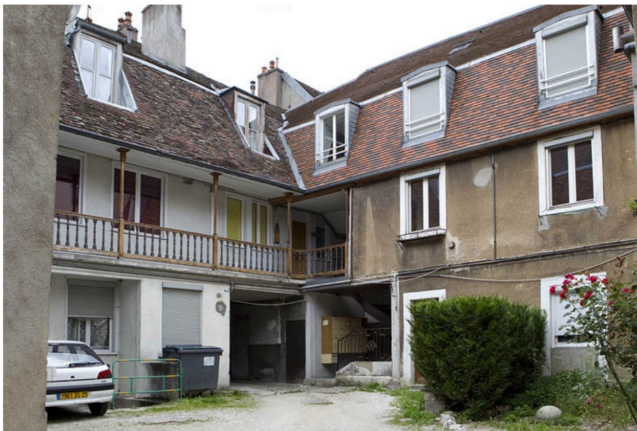
Vue des façades sur cour du logis principal, de trois quarts gauche.
