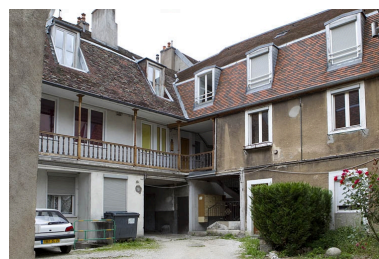
Vue des façades sur cour du logis principal, de trois quarts gauche. Phot. Yves Sancey IVR43_20102500775NUC2A
