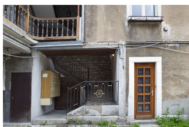
Détail du départ de l'escalier principal. Phot. Yves Sancey IVR43_20102500776NUC2A
