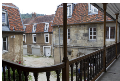
Vue d'ensemble des logis sur cour depuis la galerie du logis principal. Phot. Yves Sancey IVR43_20102500780NUC2A
