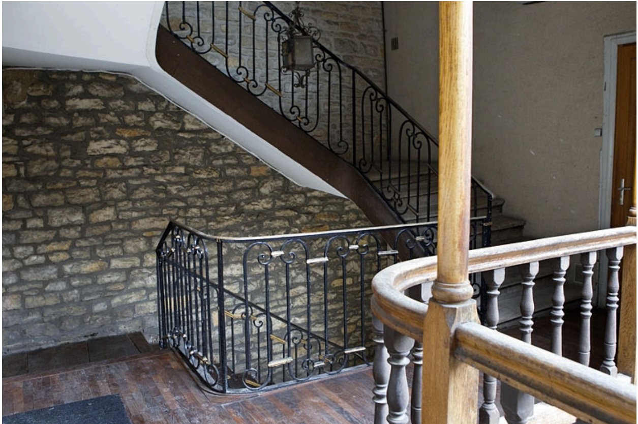
Détail de l'intérieur de l'escalier principal.
