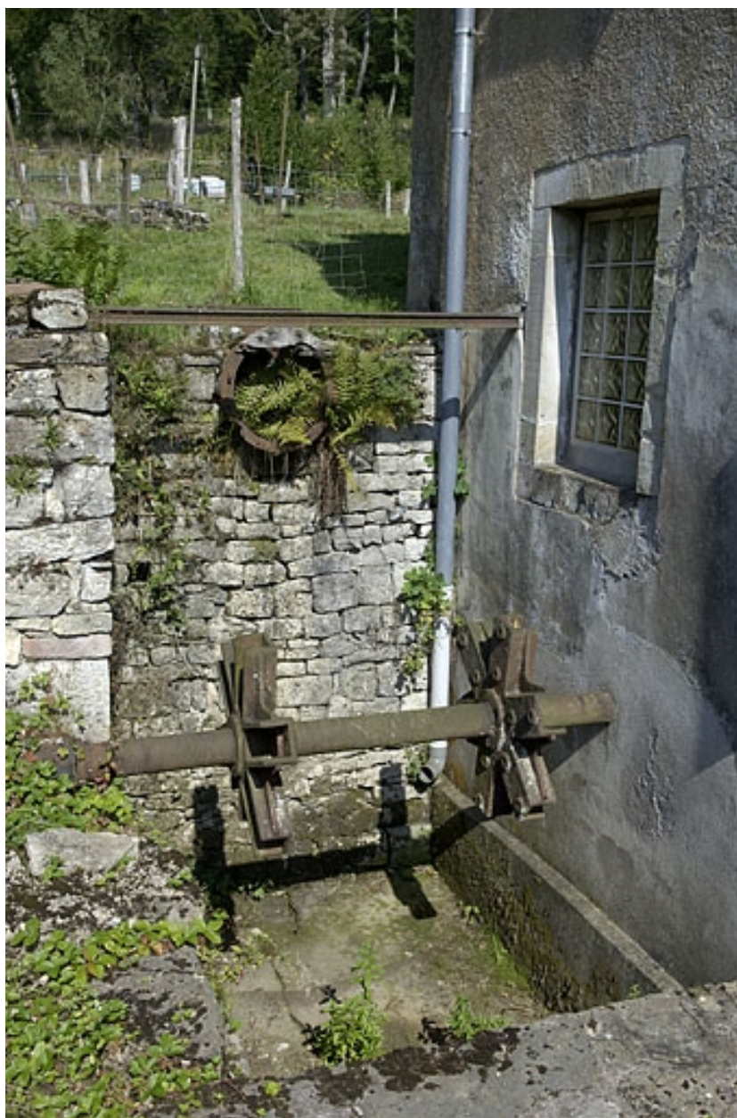
Emplacement de la roue hydraulique.
