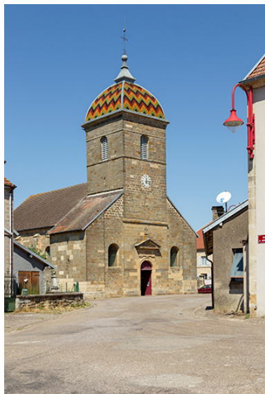
Vue de trois-quart sud-est. Phot. Sonia Dourlot IVR43_20167001887NUC2A
