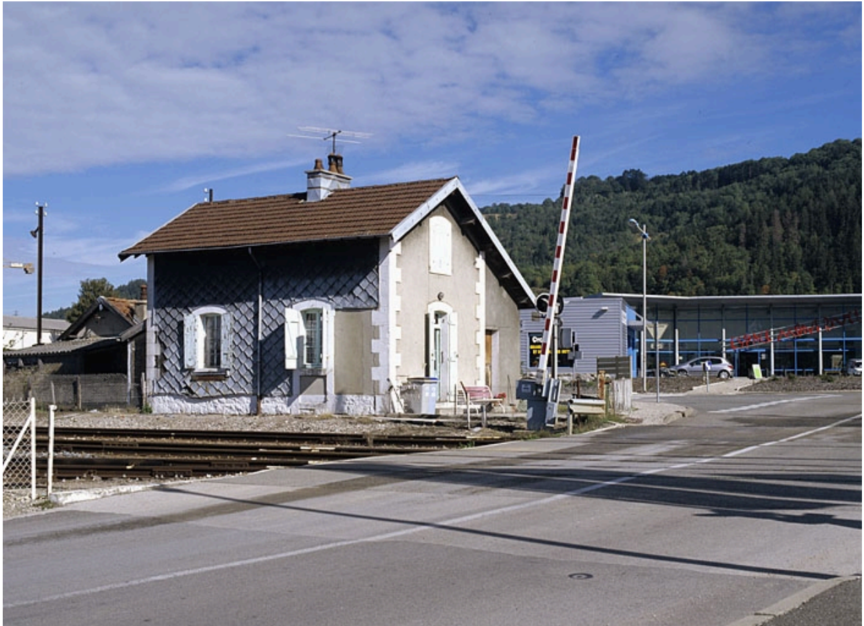
Façades antérieure et latérale gauche.
