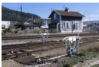
Vue d'ensemble, depuis l'ouest. Phot. Yves Sancey IVR43_20043900186ZA
