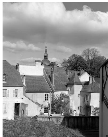
Partie de la ville haute depuis la rue du Réservoir. Phot. Yves Sancey IVR43_19917000093X
