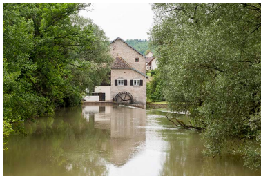
Vue d'ensemble depuis l'amont du Lison. Phot. Jérôme Mongreville IVR43_20162500440NUC4A
