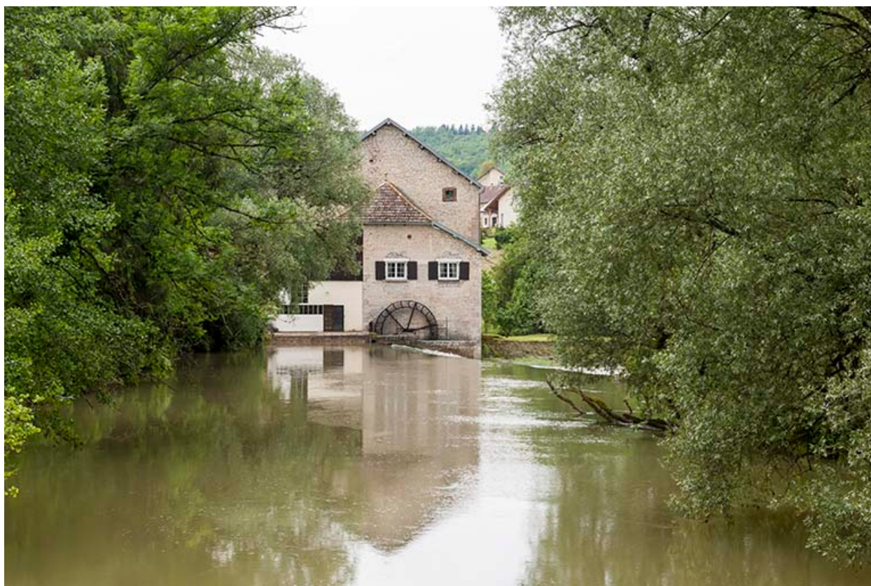
Vue d'ensemble depuis l'amont du Lison.
