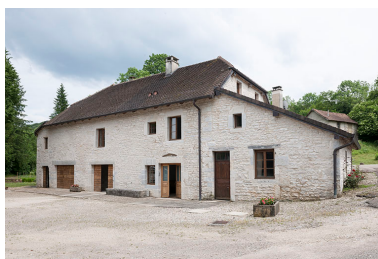
Dépendances (ferme et boulangerie). Phot. Jérôme Mongreville IVR43_20162500443NUC4A
